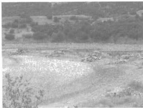
Φωτογραφίες 7 & 8. Προστατευτικοί πρόβολοι κατά της διάβρωσης, κάθετοι στην εξωτερική κοίτη σε στροφή του Πηνειού ποταμού, στη Σαρακήνα.
