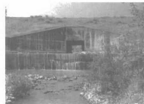
Φωτογραφία 1. Το φράγμα της Θεόπετρας, που διοχετεύει μέρος των νερών του Ληθαίου προς τον Πηνειό, μέσω καναλιού.
