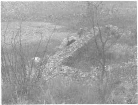
Φωτογραφίες 7 & 8. Προστατευτικοί πρόβολοι κατά της διάβρωσης, κάθετοι στην εξωτερική κοίτη σε στροφή του Πηνειού ποταμού, στη Σαρακήνα.
