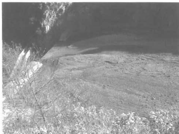
Φωτογραφία 12. Κακή συντήρηση και πλήρωση στο ορεινό φράγμα συγκράτησης των υδάτων στην Παλαιοκαρυά.
