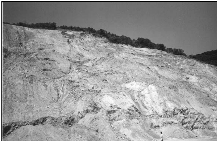
Σχήμα 5. Ολική κατάρρευση των αναβαθμίδων το Σεπτέμβριο του 2003.
