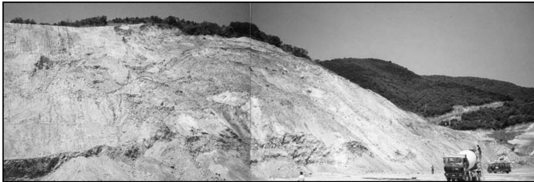
Σχήμα 4. Ολική κατάρρευση των αναβαθμίδων το Σεπτέμβριο του 2003.
