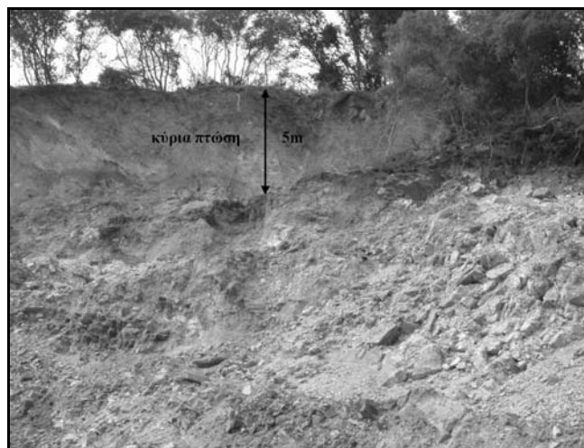
Σχήμα 6. Εμφανής η κύρια πτώση της στέψης του πρανούς (Σεπτέμβριος 2003).
