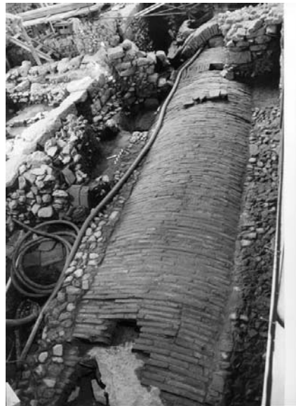
Σχήμα 8. Ηριδανός ποταμός- Σταθμός ME-TPO Μοναστηράκι.
