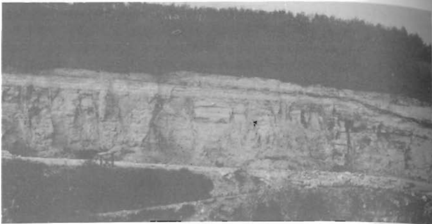
Σχ. 2. Κεντρικό τμήμα τριανσέρας Α, Μεταξάδες, ΒΑ Ελλάδα. Fig.2. Central part of shaft A, Metaxades, NE Greece.
