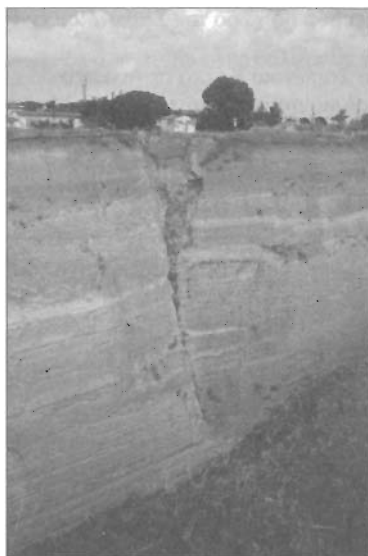
Εικ.8: Σεισμικό ρήγμα στην τομή της διώρυγας της Κορίνθου Fig.8: Seismic fault in the cross section of Korinthos canal.
