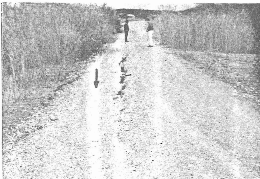
Εικ. 5. Εδαφικές διαρρήξεις διεύθυνσης ΝΝΑ-ΒΒΔ κατά μήκος του αγροτικού δρόμου Βαρθολομιού - Μπούκας. Οι διαρρήξεις έχουν άλμα της τάξης των 5-10 εκατοστών με αποτέλεσμα το ενδιάμεσο μικρο-τέμαχος να έχει ταπεινωθεί σε σχέση με τα εκατέρωθεν.
