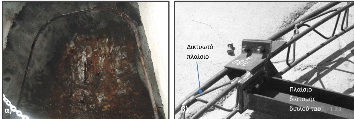
Εικόνα 3.2 Χαλύβδινα πλαίσια α) πλαίσια διατομής διπλού ταυ (HEB) κατά την εφαρμογή τους στο μέτωπο -100 του μεταλλείου Ολυμπιάδας, β) δικτυωτά πλαίσια (lattice girder) και (HEB).
