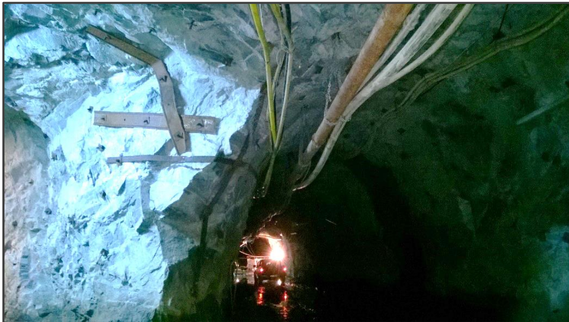
Εικόνα 3.3 Εφαρμογή των μεταλλικών των μεταλλικών «συνδέμων» (straps) στο επίπεδο -173 του μεταλλείου Ολυμπιάδας.
