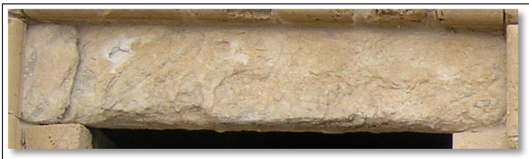
Εικόνα 5.2.2: Μηχανισμός φθοράς τύπου "απολέπιση".
