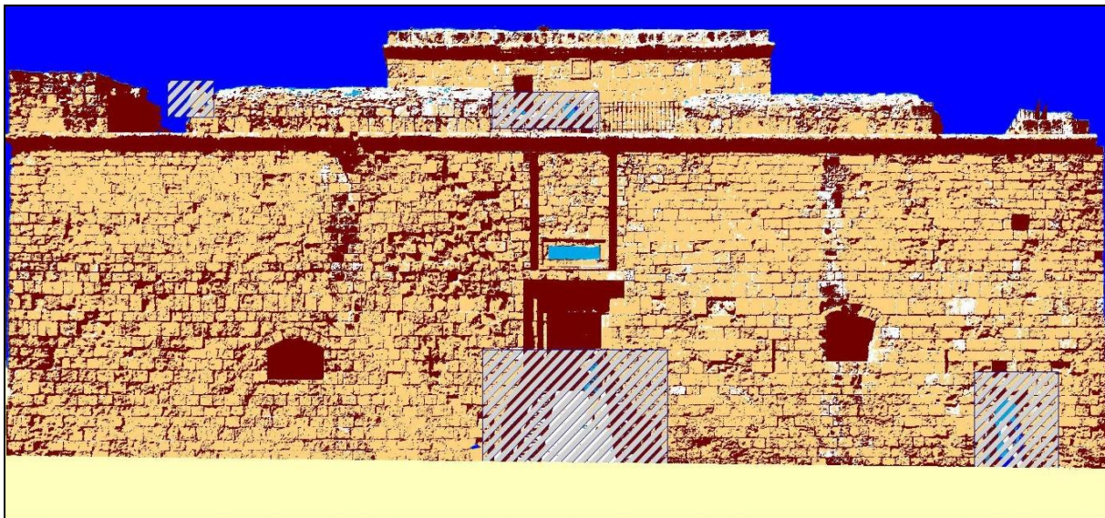
Εικόνα 5.2.16: Πρόσοψη κάστρου. Οι διαφορετικοί χρωματισμοί που προέκυψαν από την επεξεργασία και ταξινόμηση της ορθο-φωτογραφίας, αντικατοπτρίζουν τη διαφορετική κατάσταση της τοιχοποιίας στα συγκεκριμένα σημεία. Στην πάνω ορθοφωτογραφία οι περιοχές με έντονη φθορά αποτυπώνονται με κόκκινο χρώμα ενώ στην κάτω με μαύρο.
