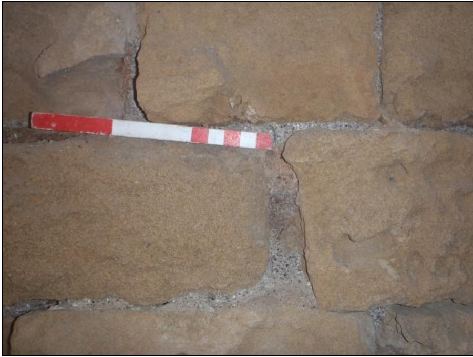
Εικ. 4.1.22β: Μακροσκοπική εικόνα της θέσης λήψεως δείγματος 22.
