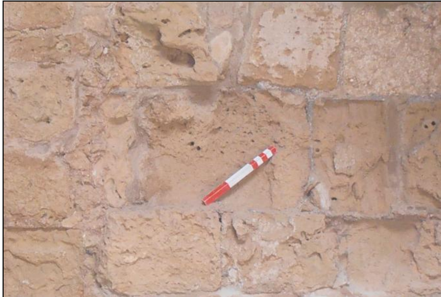
Εικ. 4.1.15β: Μακροσκοπική εικόνα της θέσης λήψεως δείγματος 15.
