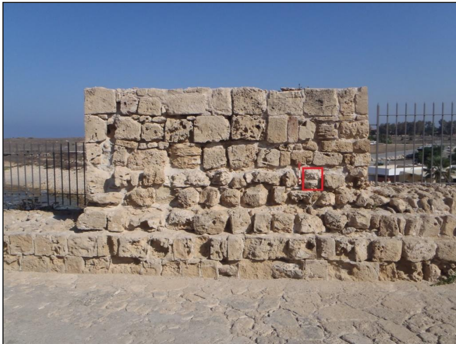
Εικ. 4.1.5α: Μακροσκοπική εικόνα τμήματος εξωτερικής βόρειας τοιχοποιίας, Θέση δείγματος 5.
