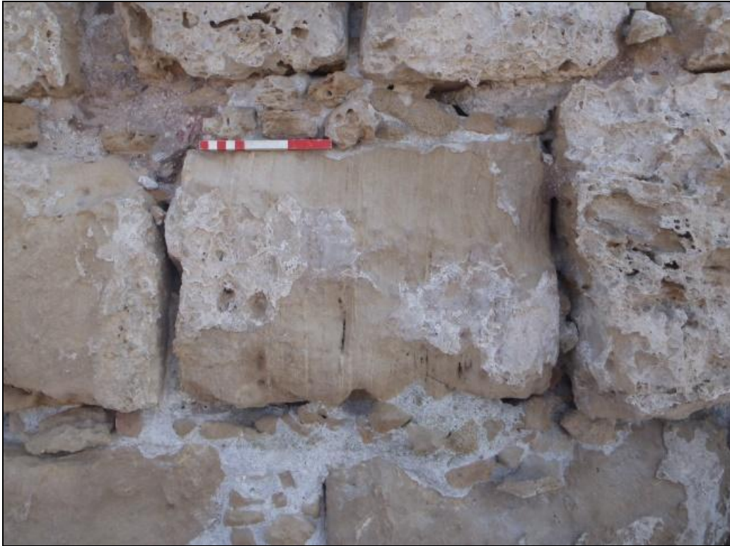
Εικ. 4.1.6β: Μακροσκοπική εικόνα της θέσης λήψεως δείγματος 6.
