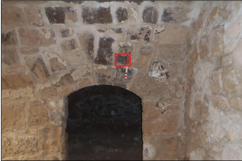
Εικ. 4.1.19α: Μακροσκοπική εικόνα δυτικής εσωτερικής τοιχοποιίας. Θέση δείγματος 19.
