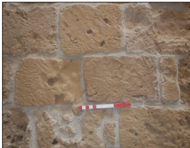
Εικ. 4.1.20β: Μακροσκοπική εικόνα της θέσης λήψεως δείγματος 20.
