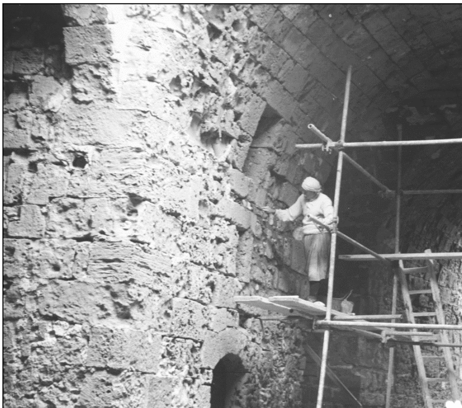
Εικ. 1.11. Εργασίες επισκευής στο εσωτερικό του κάστρου (Φωτογραφικό αρχείο Τμήματος Αρχαιοτήτων Κύπρου, 1961).
