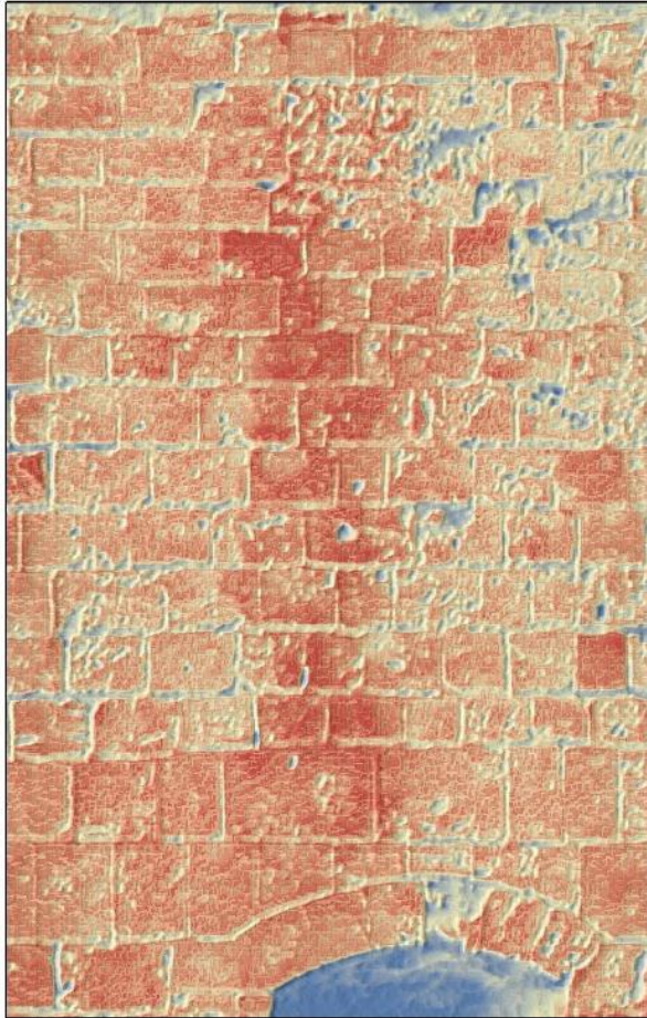
Εικόνα 5.2.19. Πρόσωση κάστρον (δεξιά της εισόδου για τον παρατηρητή). Αποτύπωση φθοράς μέσω απόδοσης αναγλύφου. Οι χρωματικές διαβαθμίσεις ανταποκρίνονται στο εύρος της φθοράς, με σκούρο μπλε να αποκαλύπτει τις περιοχές με την μεγαλύτερη απώλεια υλικού.
