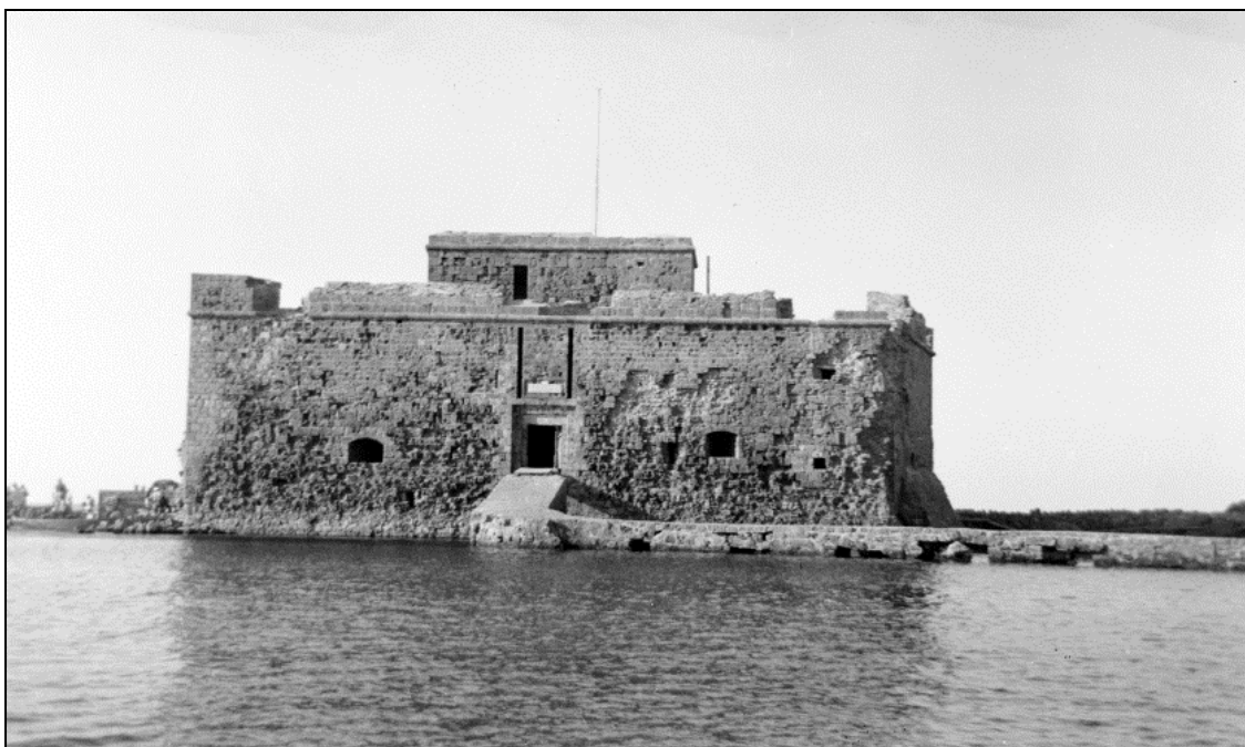
Εικ. 1.7. Πρόσωση του κάστρου με έντονη φθορά της εξωτερικής επιφάνειάς του (Φωτογραφικό αρχείο Τμήματος Αρχαιοτήτων Κύπρου, 1939).
