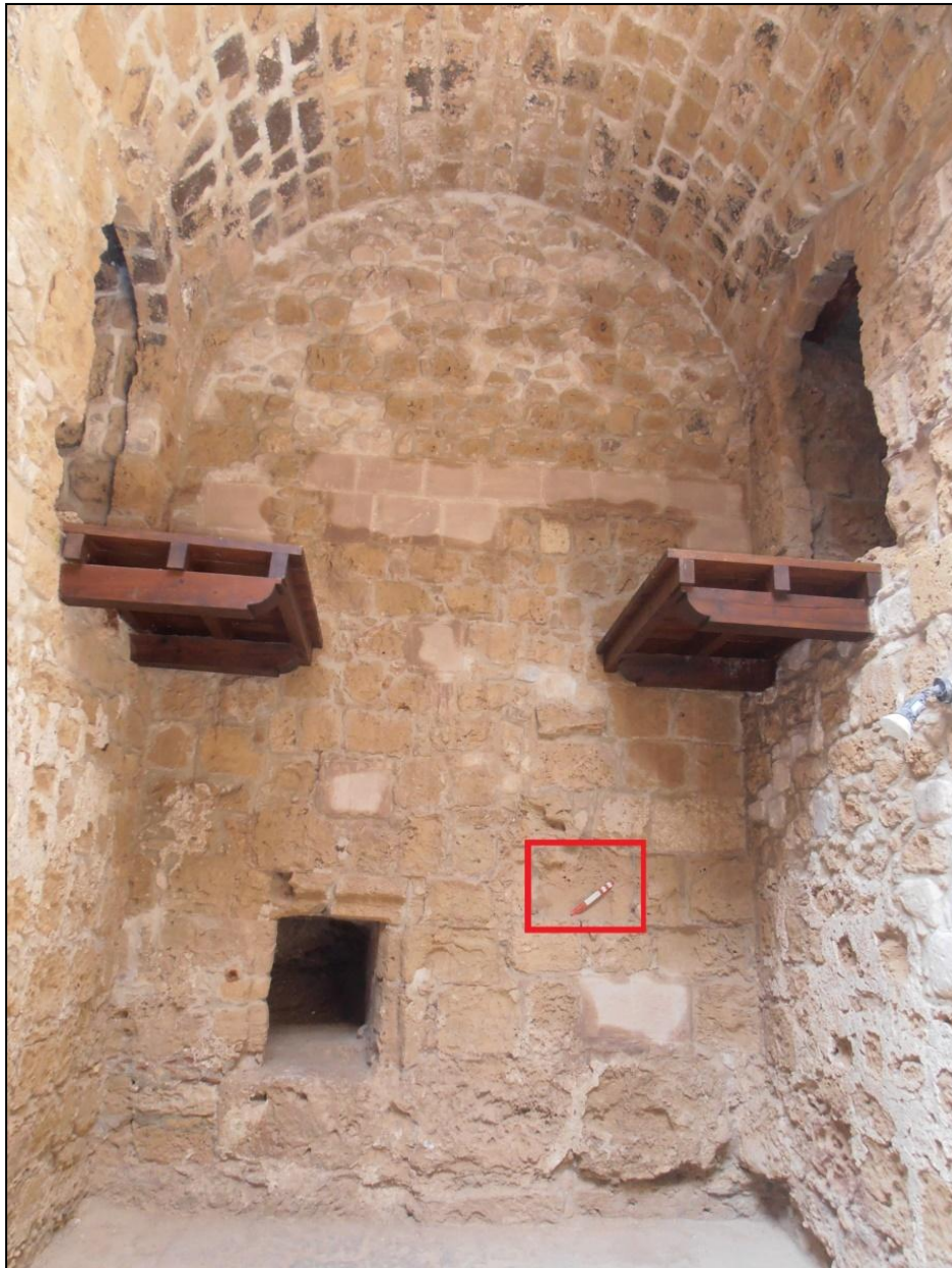
Εικ. 4.1.15α: Μακροσκοπική εικόνα δυτικής εσωτερικής τοιχοποιίας, Θέση δείγματος 15.
