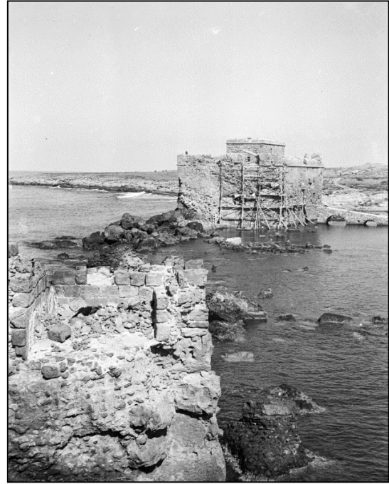
Εικ. 1.4. Εργασίες επιδιόρθωσης στη νότια εξωτερική τοιχοποιία. Λήψη φωτογραφίας από τα ερείπια του ανατολικού πύργου. Το μνημείο περιμετρικά είναι απροστάτευτο από τον κυματισμό (Φωτογραφικό αρχείο Τμήματος Αρχαιοτήτων Κύπρου, 1938).
