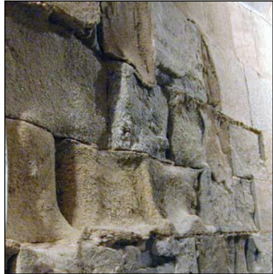
Εικ. 3.2.2: Αποφλοίωση ψαμμίτη, χαρακτηρίζεται από απόσπαση (αριστερά) πολλαπλών λεπτών στρωμάτων υποπαράλληλων προς την επιφάνεια του πετρώματος και αποικοδόμηση (δεξιά) χονδρόκοκκου γρανίτη (ICOMOS-ISCS, 2008).
