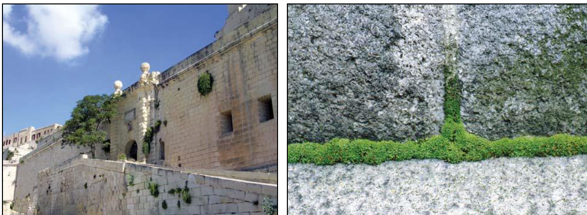
Εικ. 3.2.5: Βιολογικός αποικισμός (κυρίως φυτών και φυκιών) σε ασβεστολιθική τοιχοποιία (αριστερά) και ανάπτυξη βρύων (δεξιά) στους αρμούς γρανιτικών πετρωμάτων (ICOMOS-ISCS, 2008).
