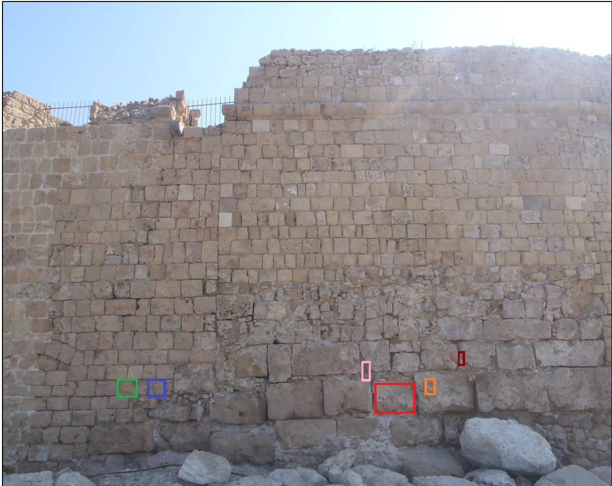
Εικ. 4.1.6α: Μακροσκοπική εικόνα τμήματος εξωτερικής δυτικής τοιχοποιίας. Θέση δείγματος 6 , Θέση δείγματος 7 , Θέση δείγματος 8 , Θέση δείγματος 16 , Θέση δείγματος 17 , Θέση δείγματος 18 .
