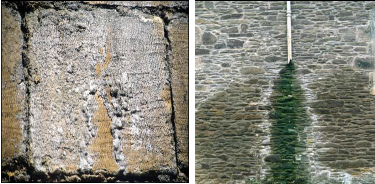
Εικ. 3.2.4: Κρούστα αλάτων (αλίτης) σε πορώδη ασβεστόλιθο (αριστερά) και αποχρωματισμός τοιχοποιίας από παρουσίας υγρασίας (δεξιά) λόγω σπασμένης σωλήνας αποχέτευσης (ICOMOS-ISCS, 2008).
