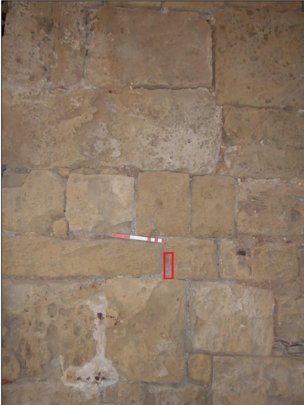
Εικ. 4.1.22α: Μακροσκοπική εικόνα δυτικής εσωτερικής τοιχοποιίας, Θέση δείγματος 22.
