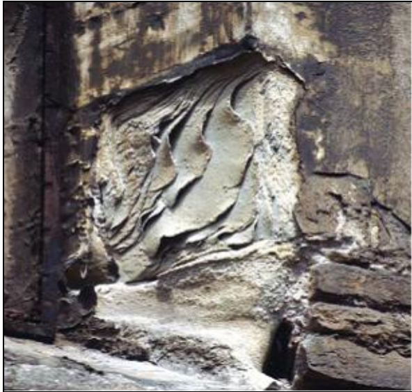
Εικ. 3.2.2: Αποφλοίωση ψαμμίτη, χαρακτηρίζεται από απόσπαση (αριστερά) πολλαπλών λεπτών στρωμάτων υποπαράλληλων προς την επιφάνεια του πετρώματος και αποικοδόμηση (δεξιά) χονδρόκοκκου γρανίτη (ICOMOS-ISCS, 2008).
