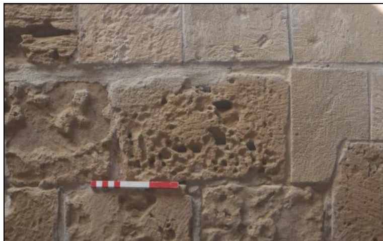
Εικ. 4.1.21β: Μακροσκοπική εικόνα της θέσης λήψεως δείγματος 21.
