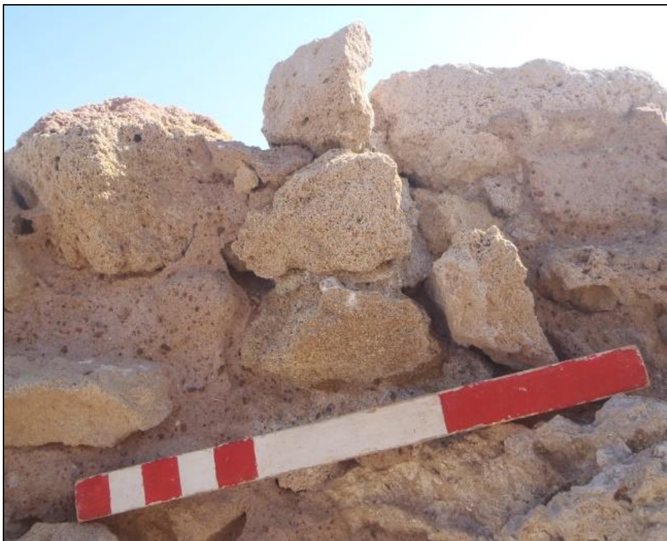
Εικ. 4.1.4β: Μακροσκοπική εικόνα της θέσης λήψεως δείγματος 4.
