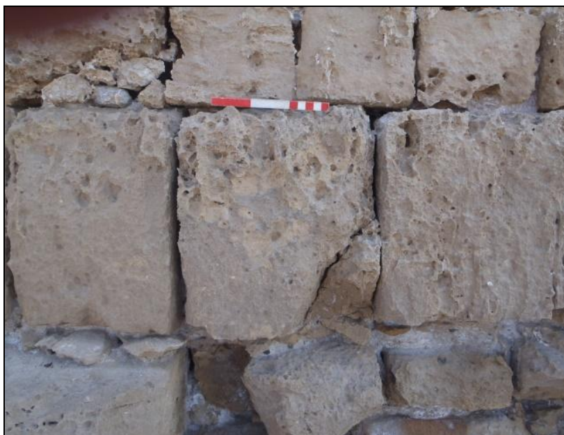
Εικ. 4.1.1β: Μακροσκοπική εικόνα της θέσης λήψεως δείγματος 1.
