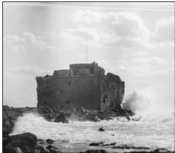
Εικ. 1.6. Η απουσία κυματοθραύστη στη δυτική πλευρά του κάστρου το άφηγε απροστάτευτο στον έντονο κυματισμό (Φωτογραφικό αρχείο Τμήματος Αρχαιοτήτων Κύπρου, 1939).
