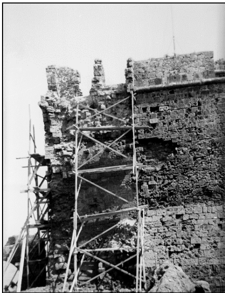
Εικ. 1.5. Εργασίες επιδιόρθωσης της βόρειας εξωτερικής τοιχοποιίας, η κατάσταση του μνημείου είναι κάκιστη (Φωτογραφικό αρχείο Τμήματος Αρχαιοτήτων Κύπρου, 1939).
