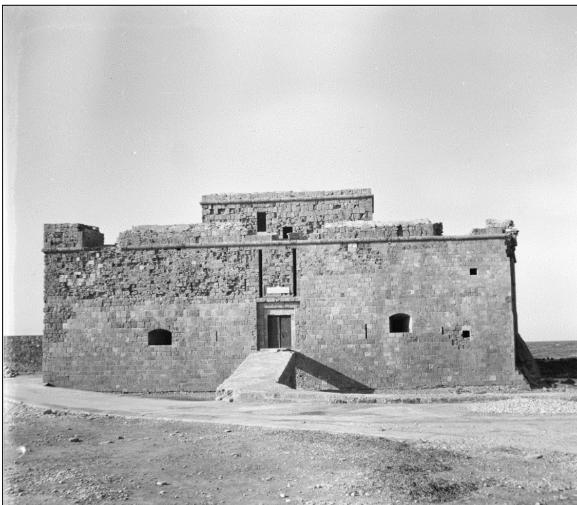
Εικ. 1.8. Πρόσωση του κάστρου, παρατηρείται αντικατάσταση μεγάλου μέρους της προηγούμενης εξωτερικής τοιχοποιίας καθώς επίσης η δημιουργία λιμανιού μπροστά από το κάστρο. Η όψη του κάστρου είναι αισθητά βελτιωμένη (Φωτογραφικό αρχείο Τμήματος Αρχαιοτήτων Κύπρου, 1964).
