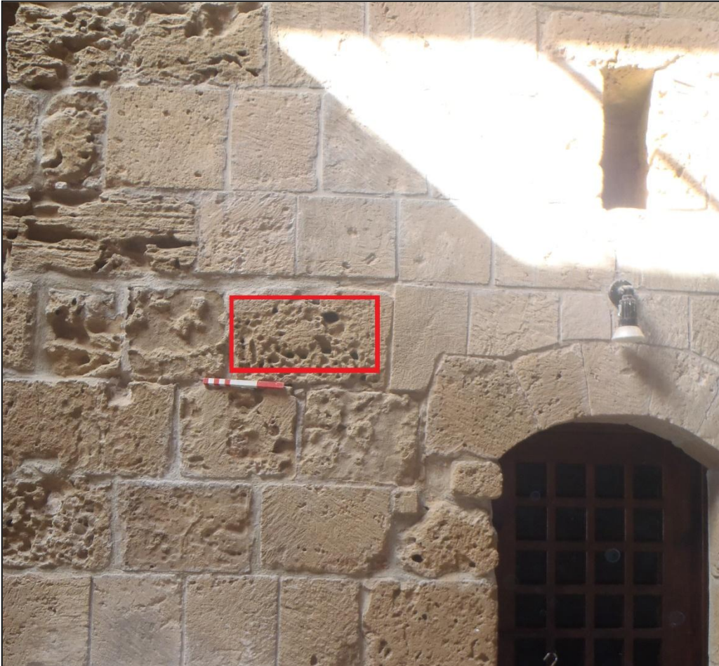
Εικ. 4.1.21α: Μακροσκοπική εικόνα δυτικής εσωτερικής τοιχοποιίας. Θέση δείγματος 21.
