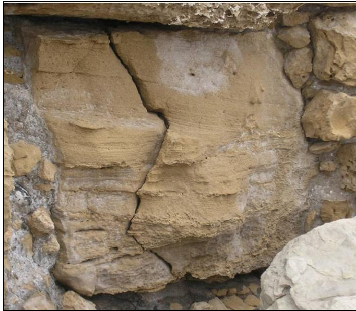
Εικόνα 5.2.1: Μηχανισμός φθοράς τύπου "ρωγή".
