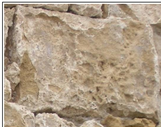
Εικόνα 5.2.4. Μηχανισμός φθοράς τύπου "διάσπαση/ρήξη".
