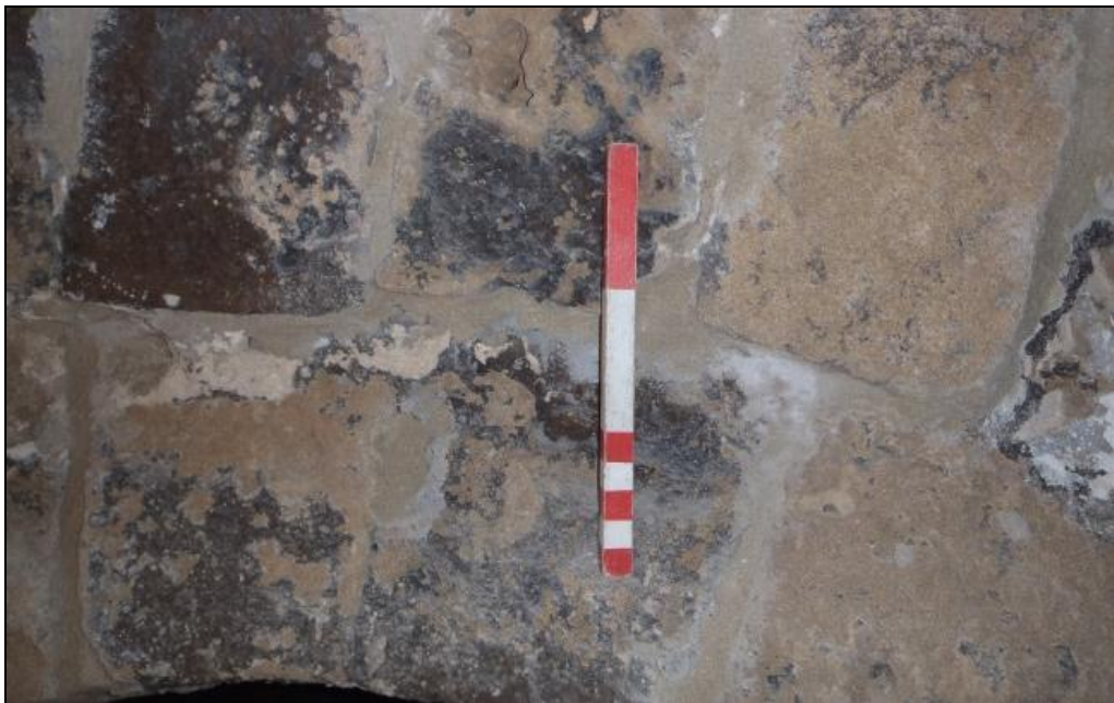
Εικ. 4.1.19β: Μακροσκοπική εικόνα της θέσης λήψεως δείγματος 19.
