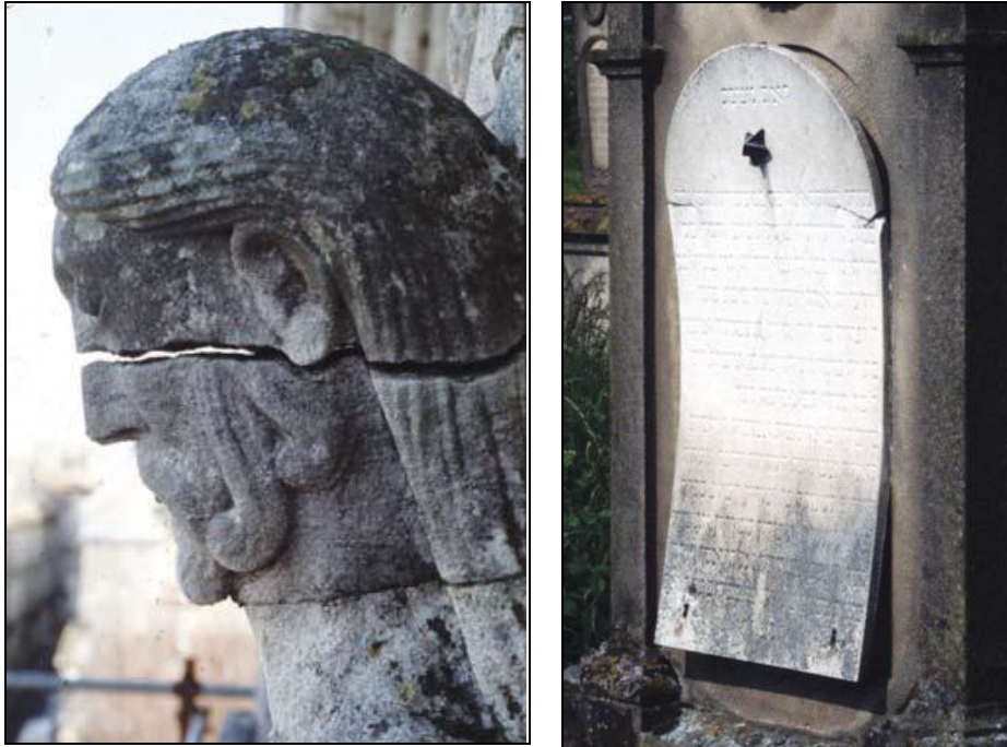
Εικόνα 3.2.1: Οριζόντια ρωγμή (αριστερά) λόγω σκουριασμένου μεταλλικού σφικτήρα και παραμόρφωση (δεξιά) σε λευκή μαρμάρινη πλάκα (ICOMOS-ISCS, 2008).
