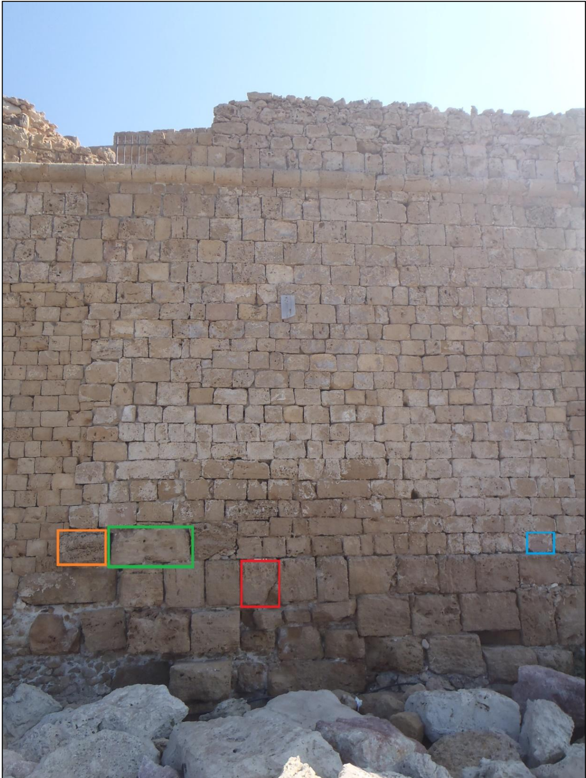
Εικ. 4.1.1α: Μακροσκοπική εικόνα τμήματος εξωτερικής δυτικής τοιχοποιίας. Θέση δείγματος 1, Θέση δείγματος 2, Θέση δείγματος 3, Θέση δείγματος 9.
