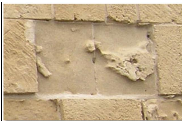
Εικόνα 5.2.3. Μηχανισμός φθοράς τύπου "περιμετρική απολέπιση".
