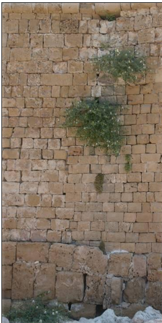
Εικόνα 5.2.15: Μηχανισμός φθοράς τύπου "ανάπτυξη φυτών".
