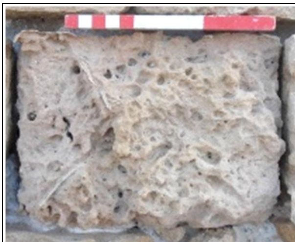
Εικόνα 5.2.9: Μηχανισμός φθοράς τύπου κυψελοειδής και διαφορική διάβρωση.
