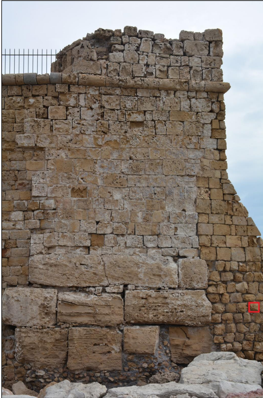
Εικ. 4.1.27α: Μακροσκοπική εικόνα τμήματος δυτικής εξωτερικής τοιχοποιίας, Θέση δείγματος 27.
