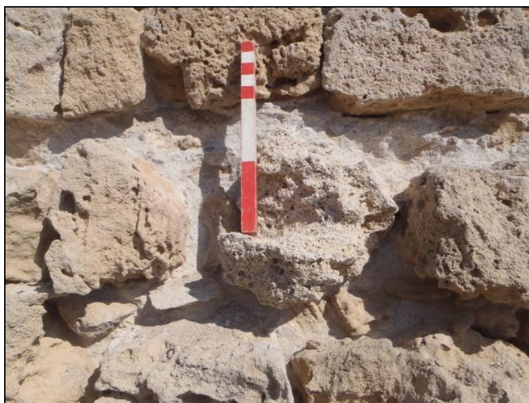
Εικ. 4.1.5β: Μακροσκοπική εικόνα της θέσης λήψεως δείγματος 5.
