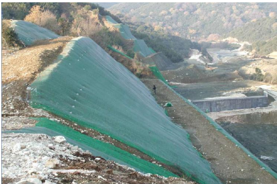
Σχήμα 6. Δημιουργία αναβαθμίδων σε ασταθή κορεσμένα ορύγματα φλύσχη, στη θέση Αγ. Αναστασία στην Εθνική οδό.
