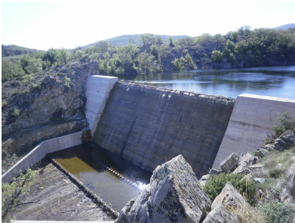
Εικόνα 7: Διαρροές στο Δυτικό αντέρεισμα του φράγματος
