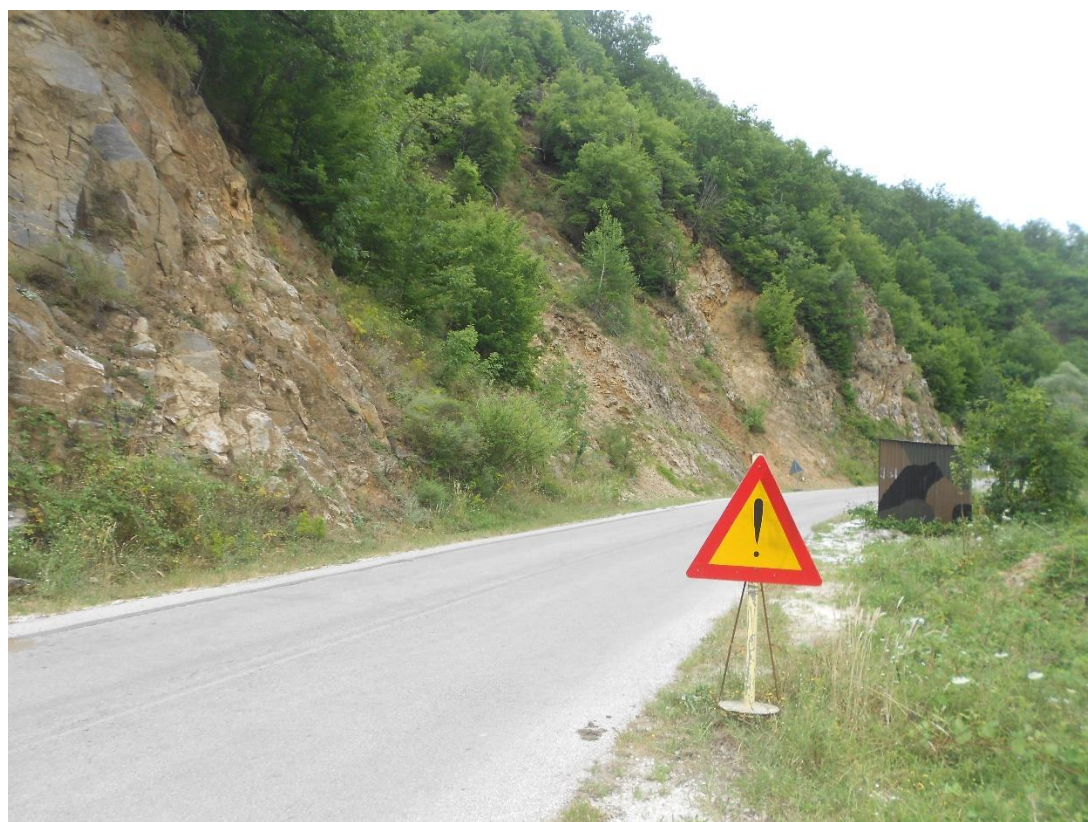
Εικόνα 3.4. Τα πρανές ανάλυσης. Στο βάθος διακρίνεται το αλλοιωμένο γρανιτικό υλικό λόγω της ζώνης του ρήγματος.
