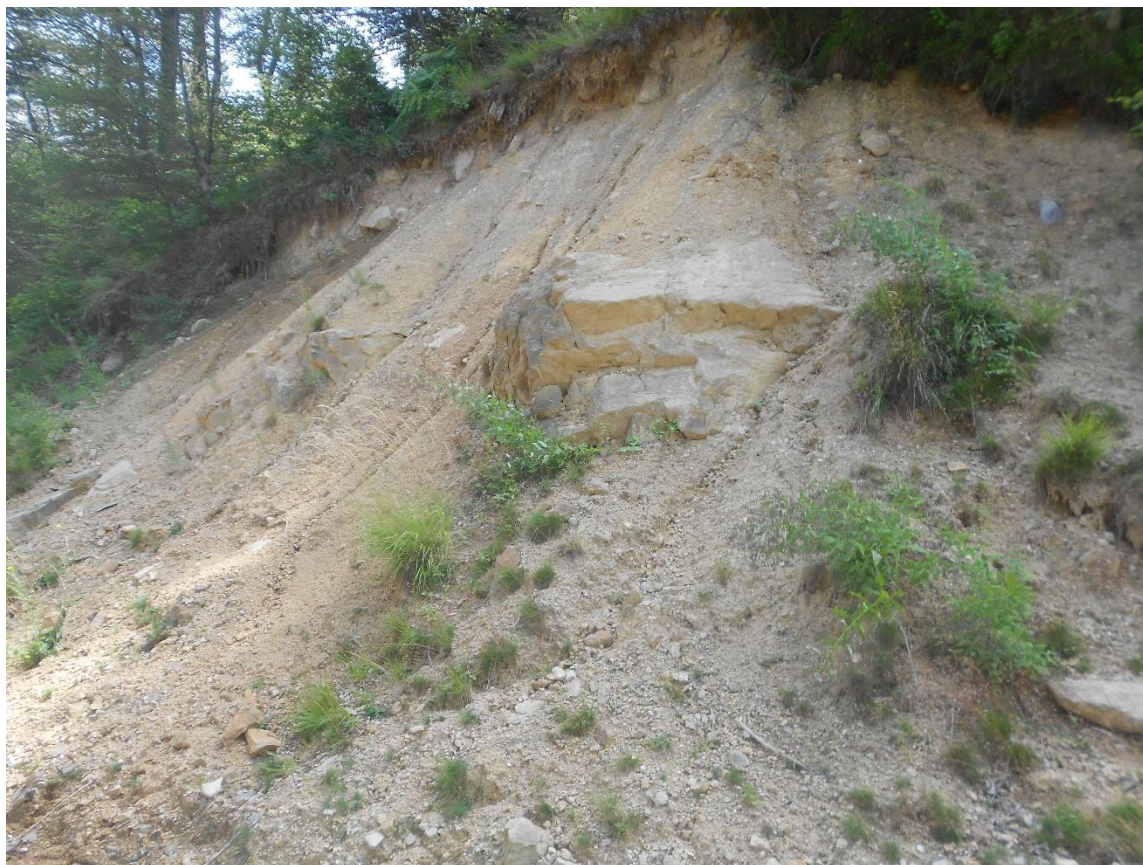
Εικόνα 2.13. Κατολισθέντα υλικά του 4 ου τμήματος Μελίβοια-Σύνορα.
