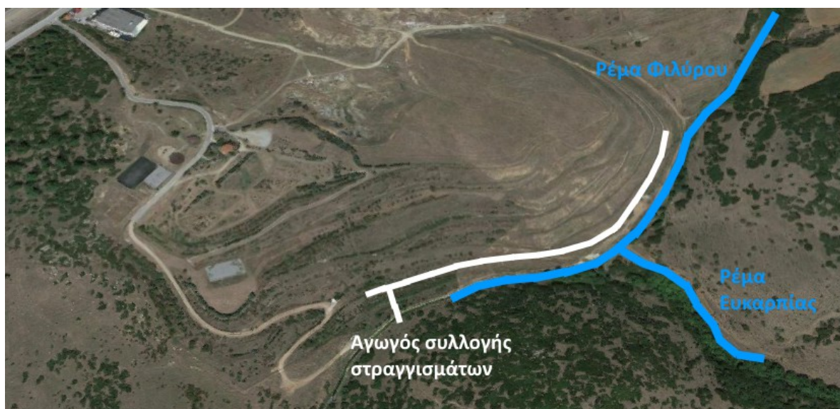
Εικόνα 5: Δίκτυο συλλογής διασταλαζόντων περιμετρικά του Χ.Τ.Α που εκφορτίζει στο ρέμα.
