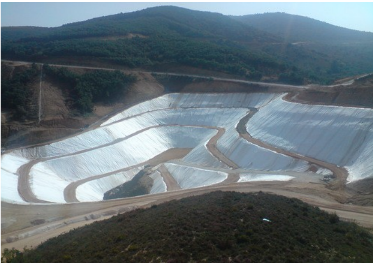
Εικόνα 1: Κατασκευή Χ.Υ.Τ.Α. στον Δήμο Μεσολογγίου ( www.agrinioeculture.gr ).
