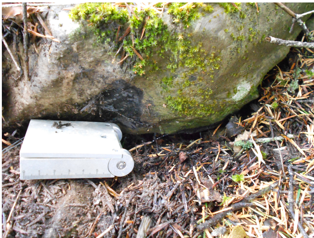
Φωτογραφία 14 Κάτοψη του εδάφους σε σημείο πιο ψηλά από το ύψος του δρόμου, στην οποία φαίνεται εφελκυστική ρωγμή.
