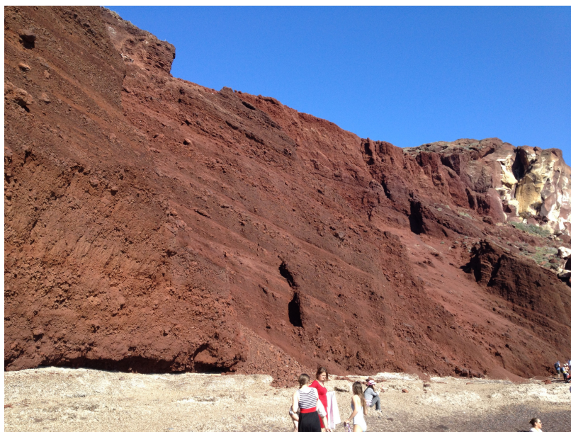
Φωτογραφία 19 Πρανές στην Κόκκινη Παραλία. Φαίνεται η στρώση των σκωριών καθώς και η υποσκαφή στην βάση του πρανούς.
