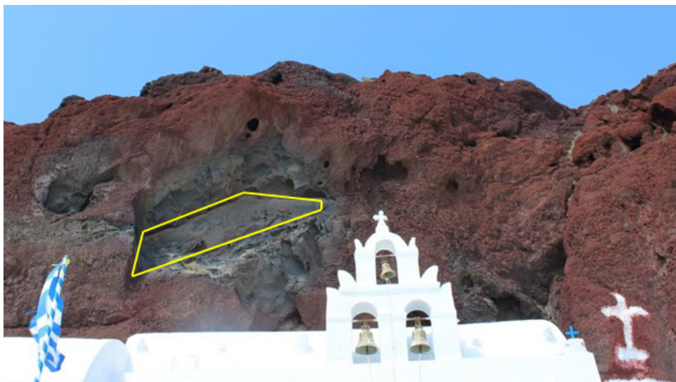
Εικόνα 11.6 Περιοχή Π1 του πάρκινγκ. Φαίνεται το μέρος από το οποίο είχε ξεκολλήσει στο παρελθόν μία σφήνα.
