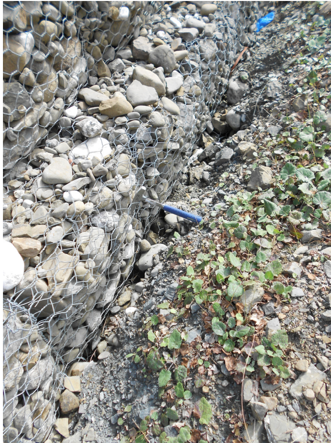
Φωτογραφία 7 Εφελκυστική ρωγμή στην επαφή των συρματοκιβώτιων με τα κορηματικά υλικά.
