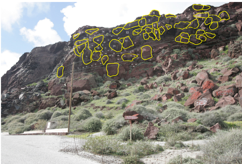
Εικόνα 11.16 Άποψη της θέσης Π3 στην περιοχή του Πάρκινγκ και ανάλυση με το λογισμικό CorelDRAW. Στην εικόνα φαίνονται μόνο τα μεγαλύτερα τεμάχια.
