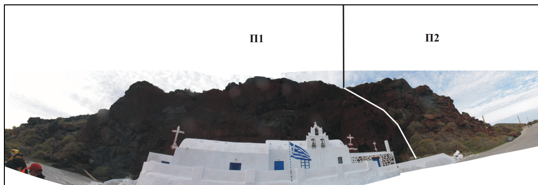
Εικόνα 11.7 Άποψη της περιοχής του Πάρκινγκ στην οποία φαίνονται οι θέσεις Π1 και Π2
