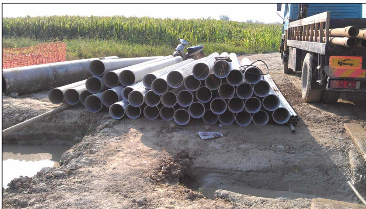
Εικόνα 10. Σωλήνες των γεωτρήσεων (ΘΘ1,ΘΘ2,ΘΘ3) (φιλτροσωλήνες και τυφλοσωλήνες)
