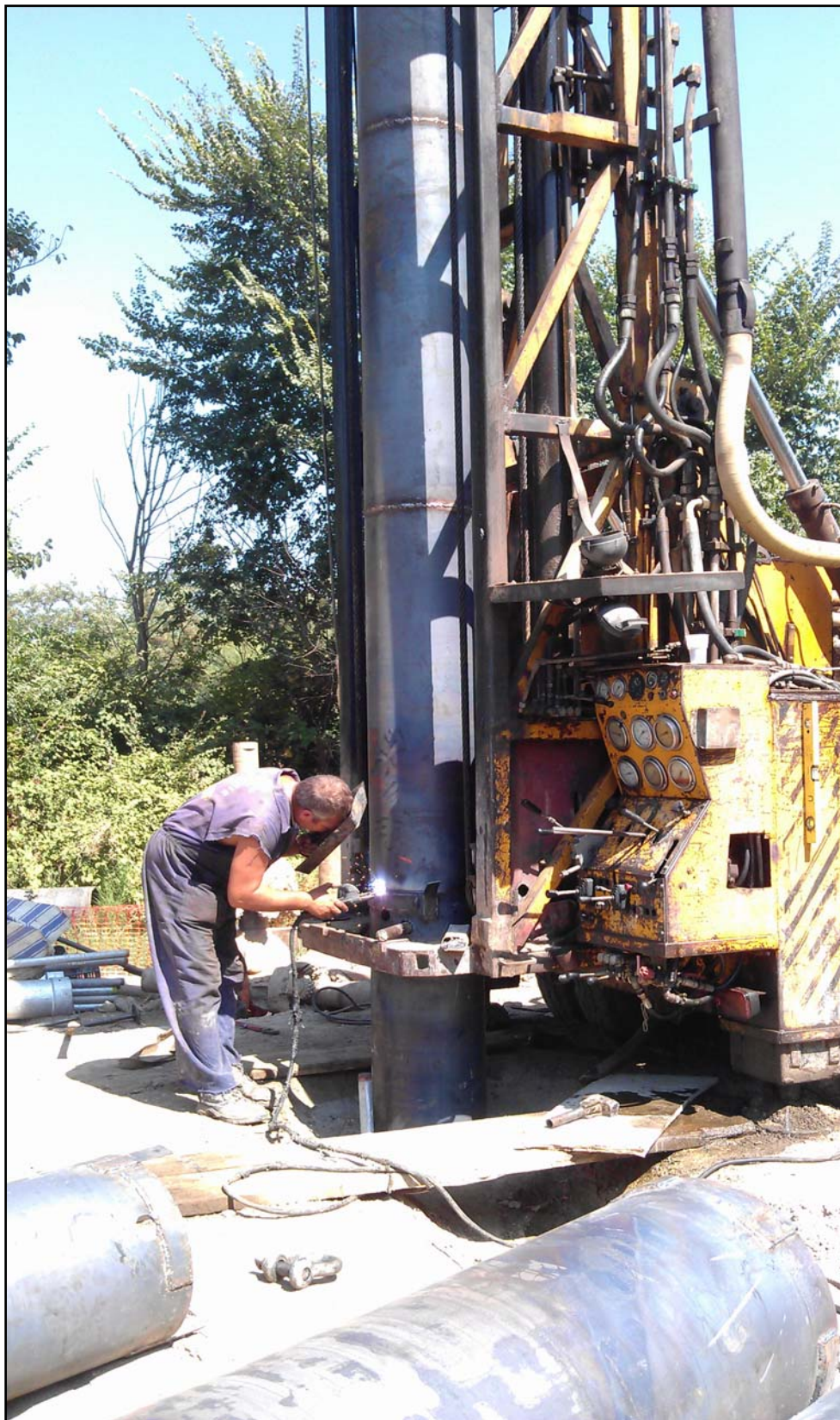
Εικόνα 8. Τοποθέτηση περιφραγματικής σωλήνωσης.
