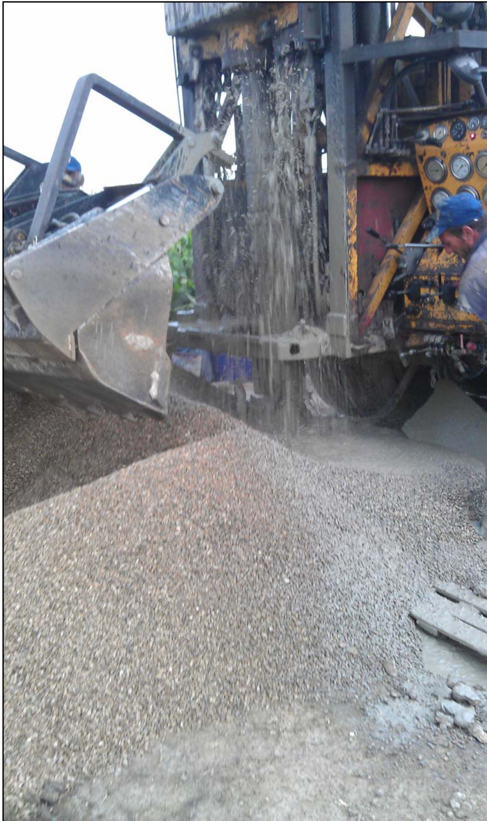
Εικόνα 11. Εισαγωγή χαλκικόφιλτρου (χαλίκωση) των γεωτρήσεων (ΘΘ1,ΘΘ2,ΘΘ3)
