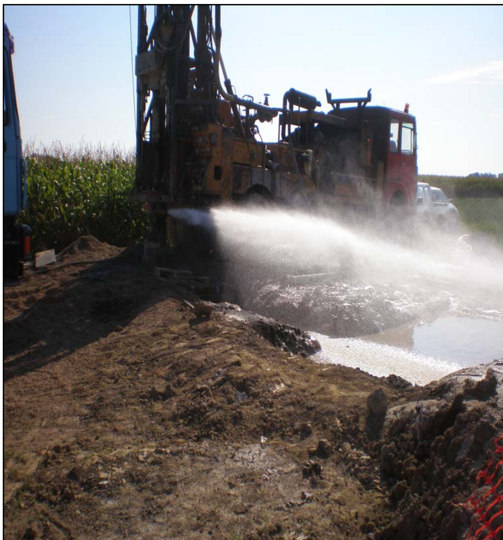
Εικόνα 12. Ανάπτυξη της γεώτρησης με air-lift
