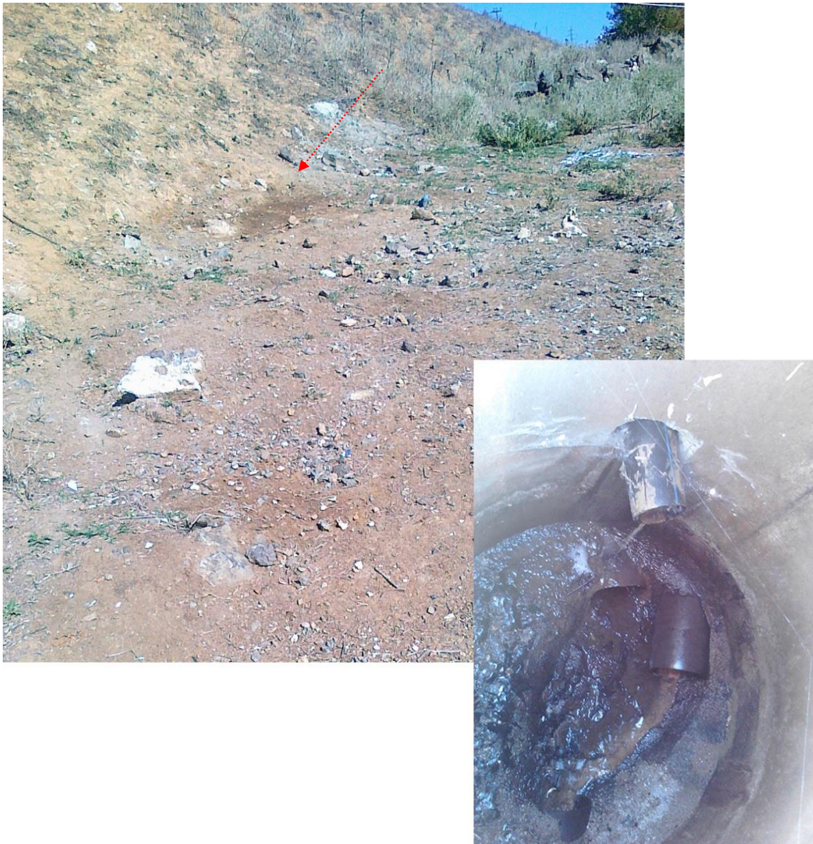
Σχήμα 3.10 : Εικόνα του φρεατίου 9 και θέση εκσκαφής.
