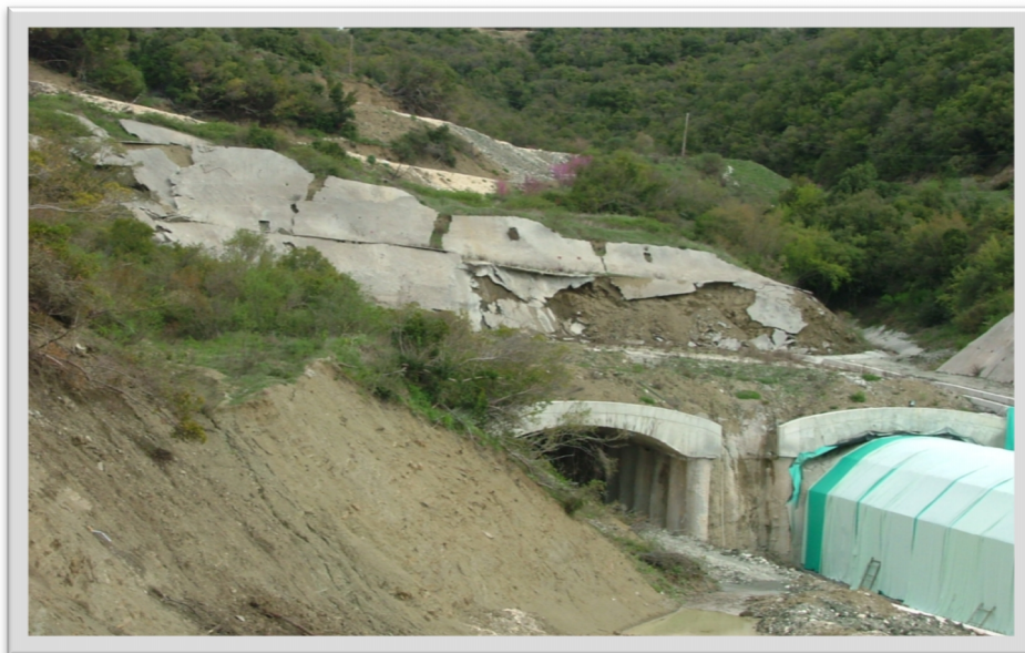
Εικόνα 3.7 : Αστοχία τεχνικού έργου που θεμελιώνεται σε ιζήματα του φλύσχη, [51]
