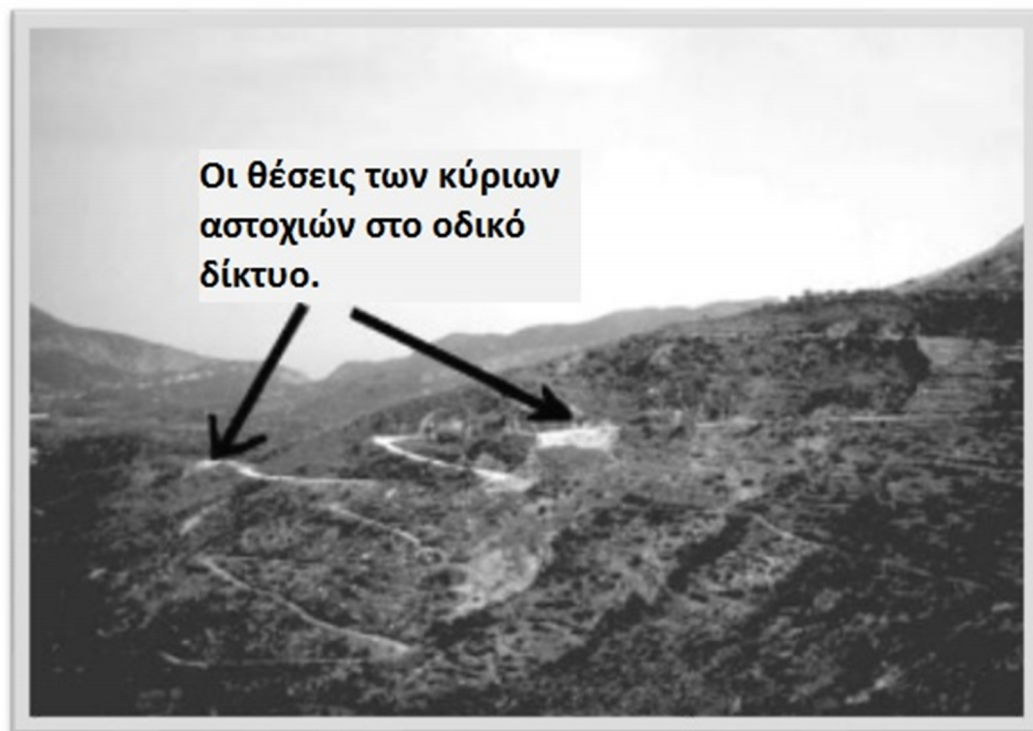
Εικόνα 4.13 : Γενική εικόνα από την περιοχή της κατολίσθησης. Είναι σημειωμένες οι θέσεις των κύριων αστοχιών του οδικού άξονα, Rozos, D., Apostolides, E., Christaras, B., 2002
