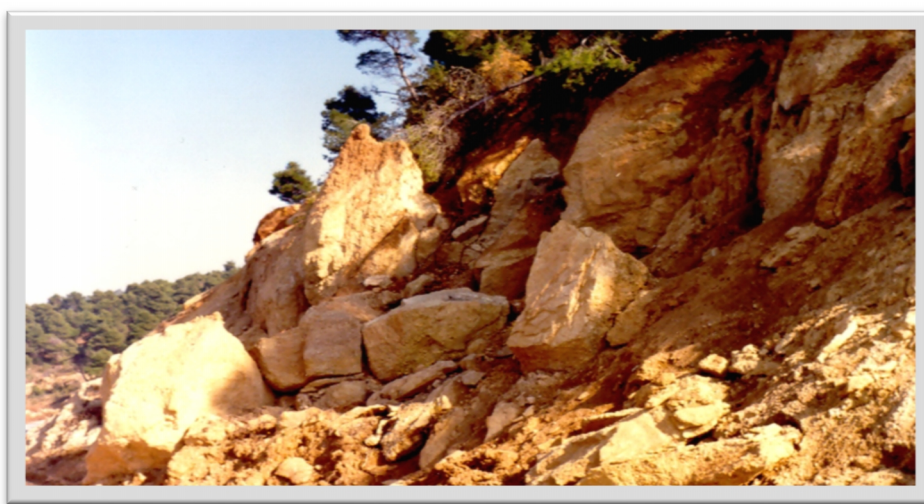
Εικόνα 3.2 : Καταπτώσεις βραχωδών μαζών σε ψαμμίτες των νεογενών (Διακοφτό), [51]
