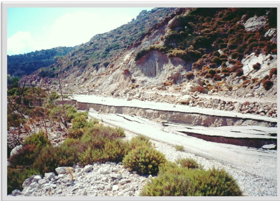
Εικόνα 3.10 : Αστοχίες σε πρανή με υλικά του μανδύα και κορήματα, [51]
