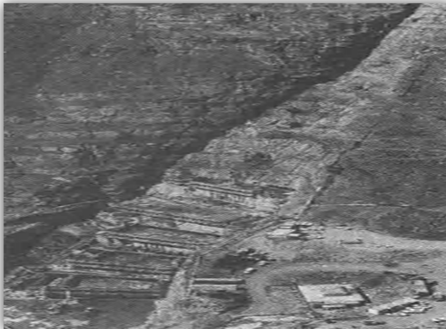
Εικόνα 4.3 : Τμήμα κατασκευής του φράγματος Katse , μέσα του 1993, Bell, F.G., Haskins, D.R., 1997
