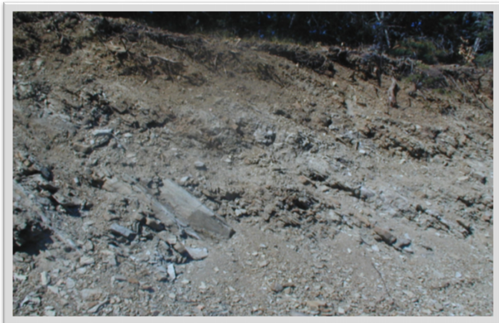
Εικόνα 2.2 : Σχιστοποίηση βράχου λόγω “ύγρρανσης-ξήρανσης”, [52]
