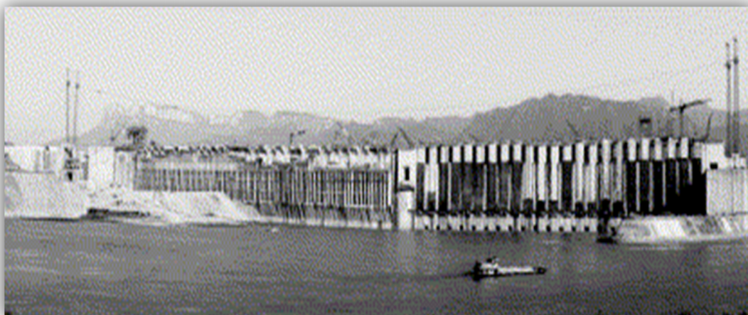
Εικόνα 4.7 : Περιοχή στα ανάντη του φράγματος κατά την κατασκευή, Jian Liua, Xia-Ting Fenga, Xiu-Li Dingb, et al., 2003
