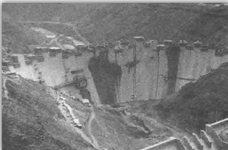
Εικόνα 4.4 : Η κατασκευή του φράγματος Katse στο τελικό του στάδιο, μέσα του 1995, Bell, F.G., Haskins, D.R., 1997
