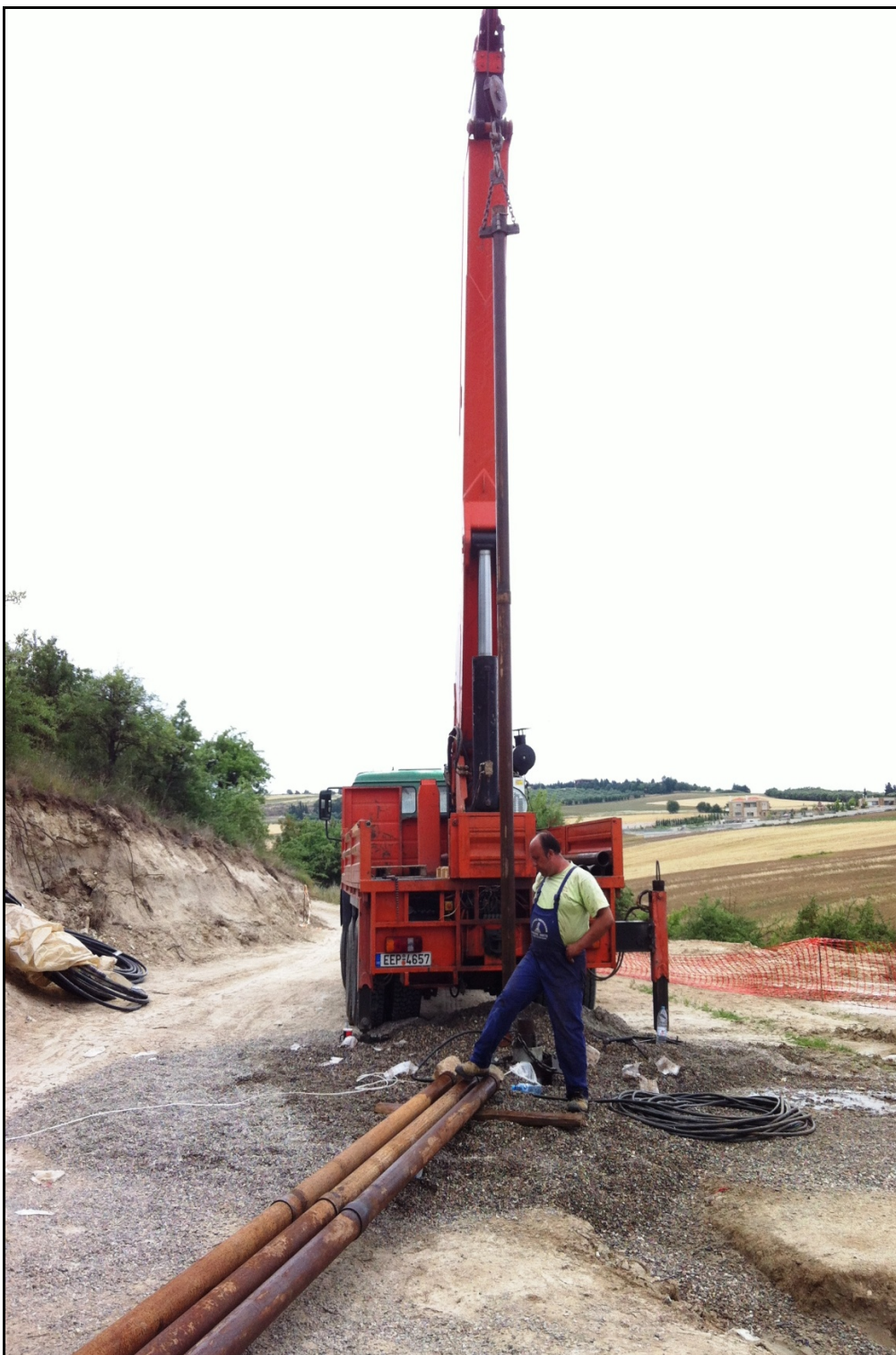
Φωτογραφία 6: Εικόνα από μία υδρογεώτρηση μελέτης.
