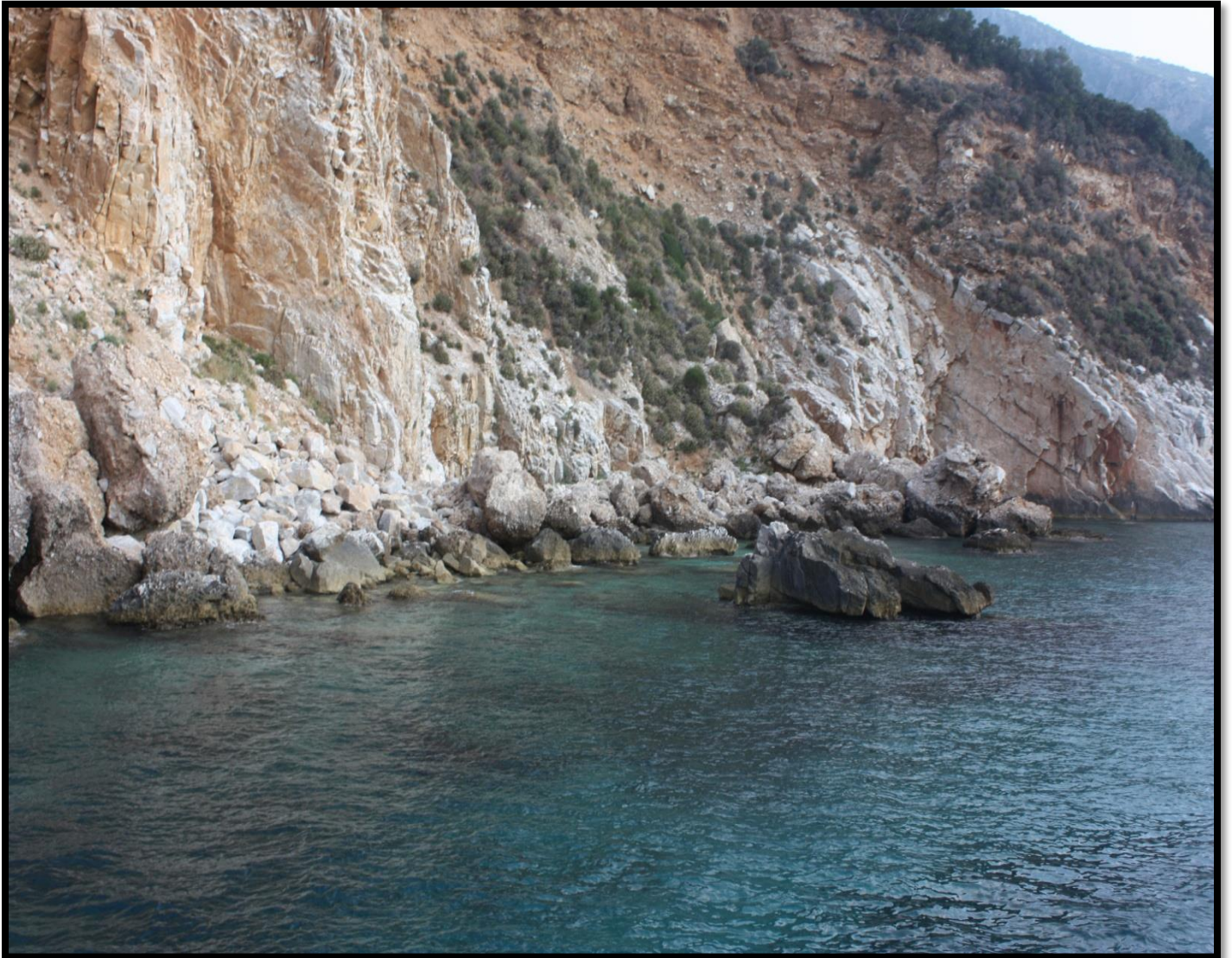
Εικόνα 12: Κατολίσθηση 2 στην περιοχή Κλέφτικο
