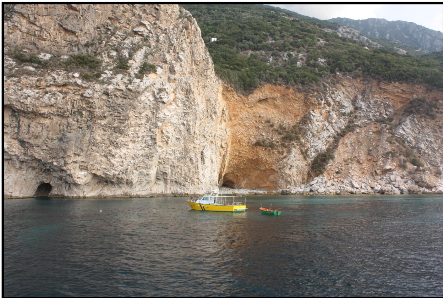
Εικόνα 11: Κατολίσθηση 1 στην περιοχή Κλέφτικο
