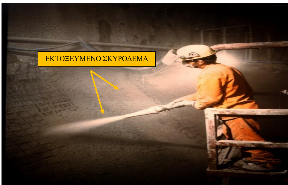
ΕΙΚΟΝΑ 5-2-1 Εφαρμογή εκτοξευμένου σκυροδέματος, ( www.ametro.gr )
