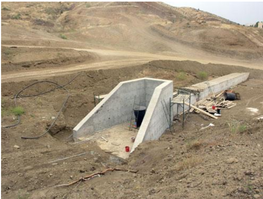
Σχ. 44: Όψη του έργου εισόδου υδροληψίας στη λεκάνη του ταμιευτήρα.
