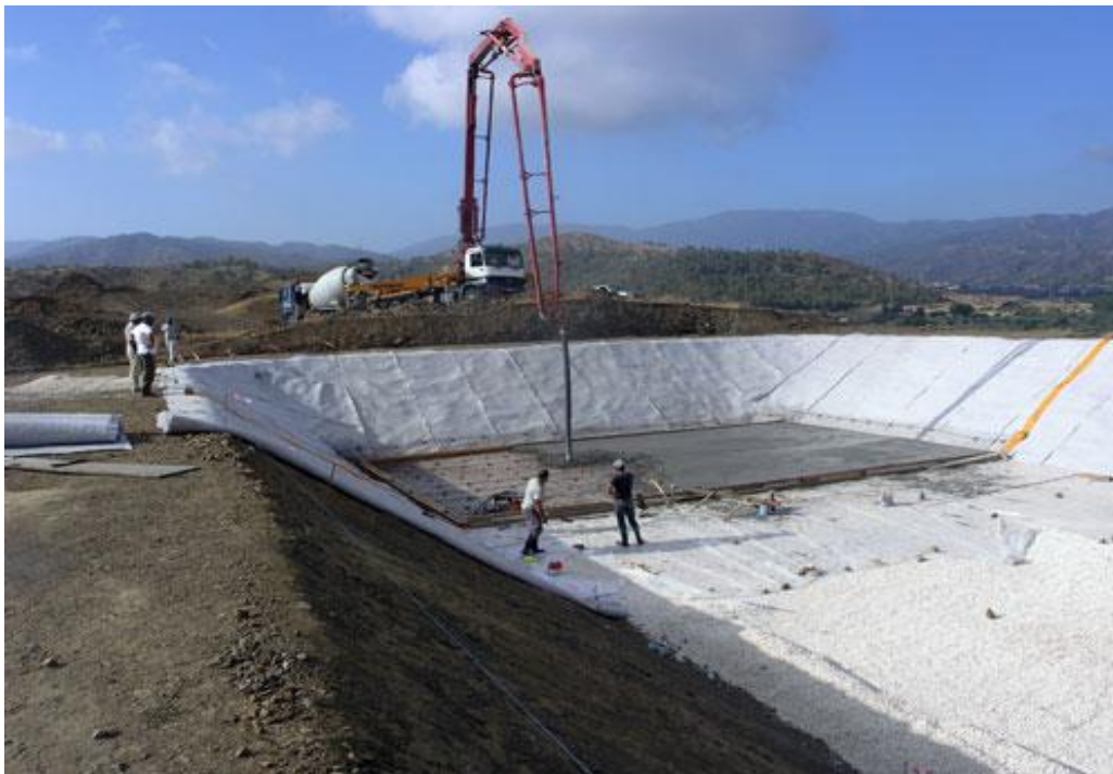
Σχ. 41: Σκυροδέτηση βάσης στο φάτνωμα 1 στην ρυθμιστική δεξαμενή Φλάσου 1 (χωρητικότητα νερού 2.000 m 3 ).
