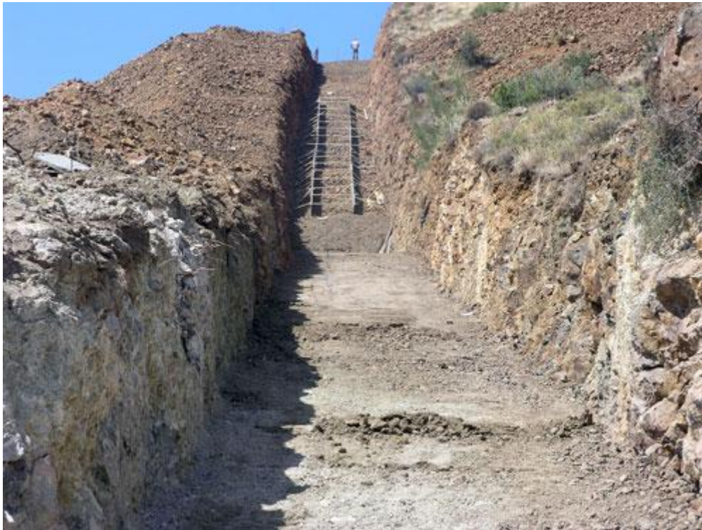
Σχ. 43: Εκσκαφή του υπερχειλιστή του φράγματος.
