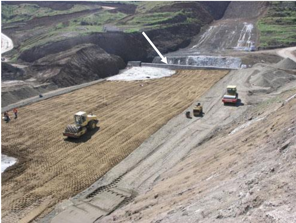
Σχ. 37: Γενική όψη του πυρήνα του φράγματος. Διακρίνεται ο σχετός εκτροπής - εκκένωσης στον πυρήνα του φράγματος (άσπρο βέλος).
