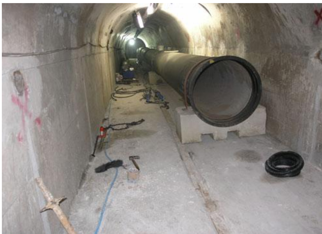
Σχ. 42: Τοποθέτηση αγωγού στον οχετό εκτροπής.
