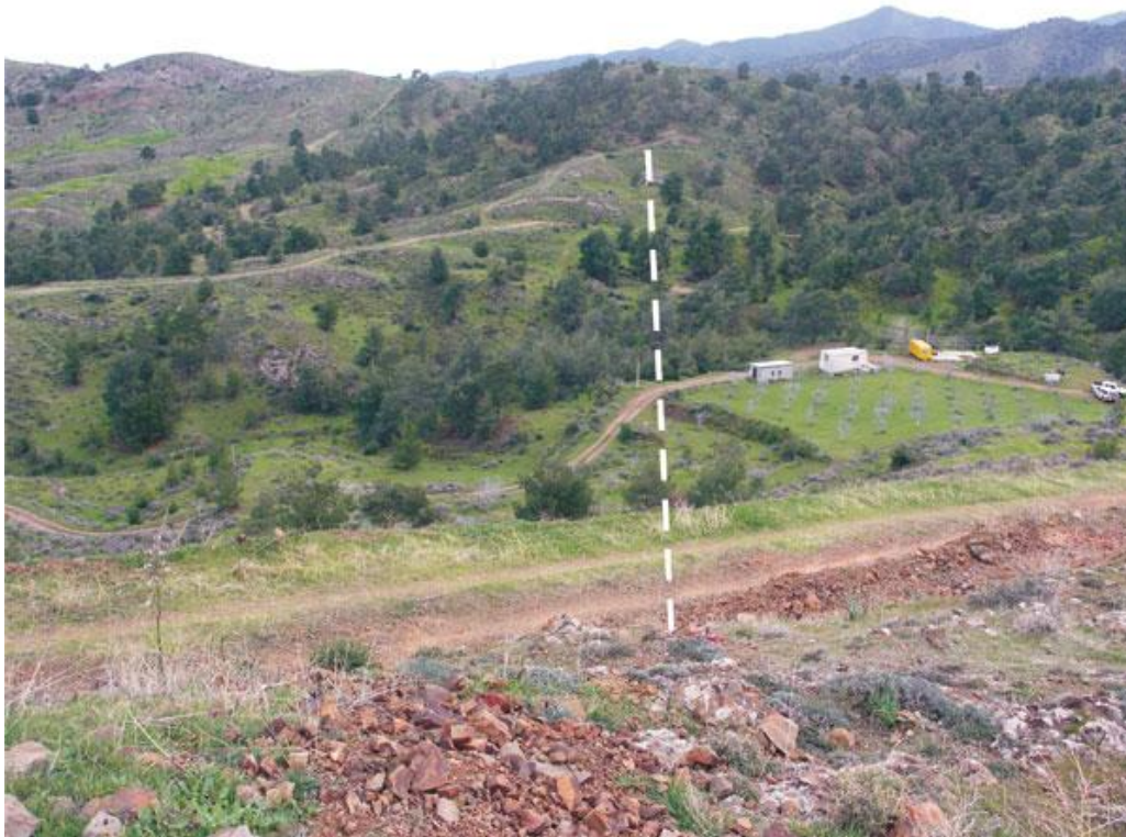
Σχ. 35: Η θέση του άξονα του φράγματος πριν την εκσκαφή.
