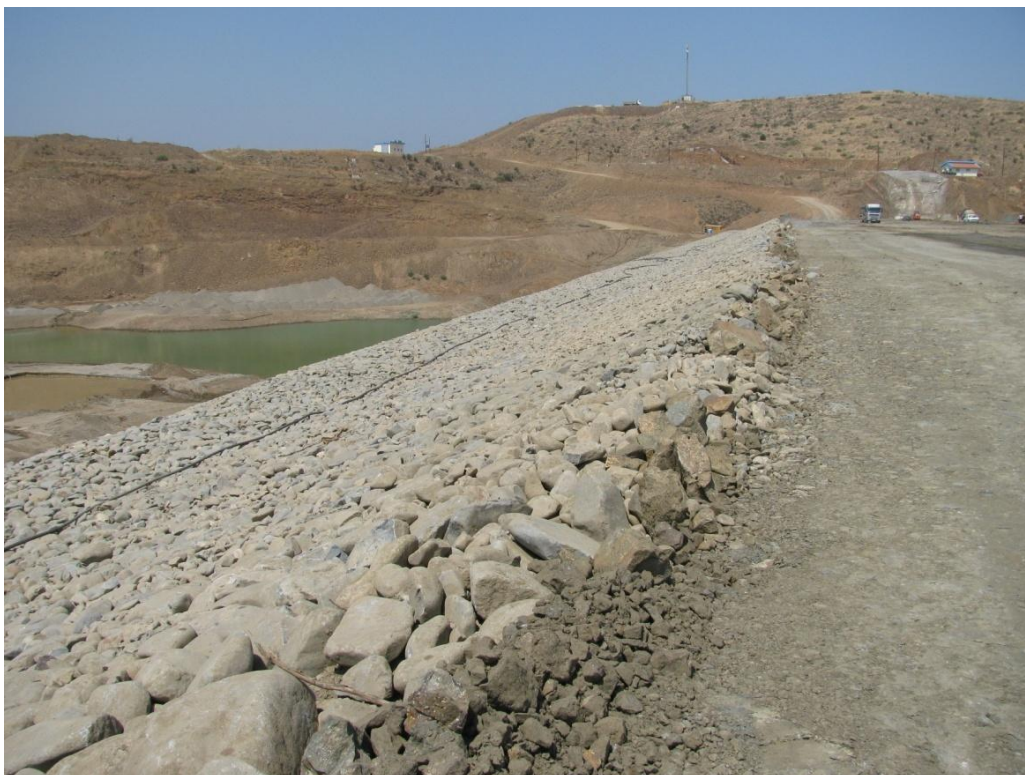
Σχ. 39: Άποψη του ανάντη πρανούς του φράγματος. Διακρίνεται η ζώνη 4Α (λιθορριπή προστασίας).
