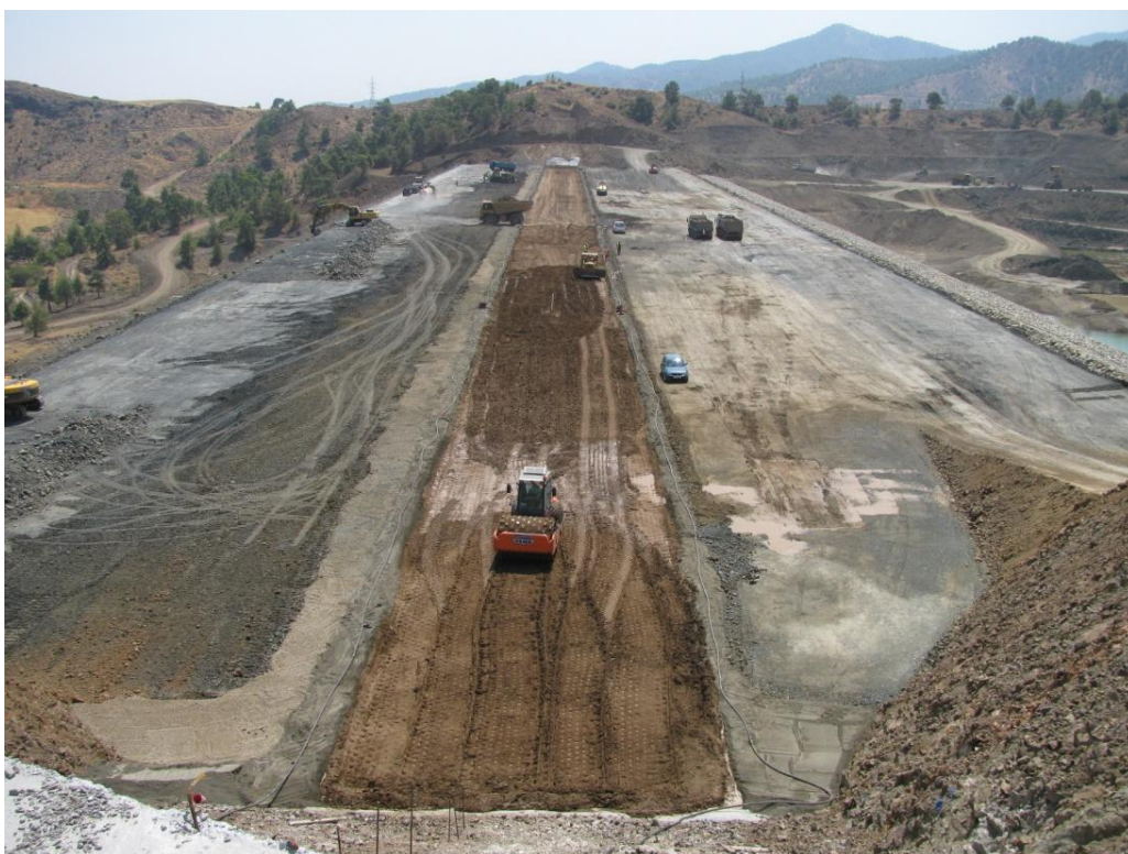
Σχ. 36: Πανοραμική όψη από το αριστερό αντέρεισμα κατά τη φάση κατασκευής. Διακρίνονται οι διάφορες ζώνες του σώματος του φράγματος.
