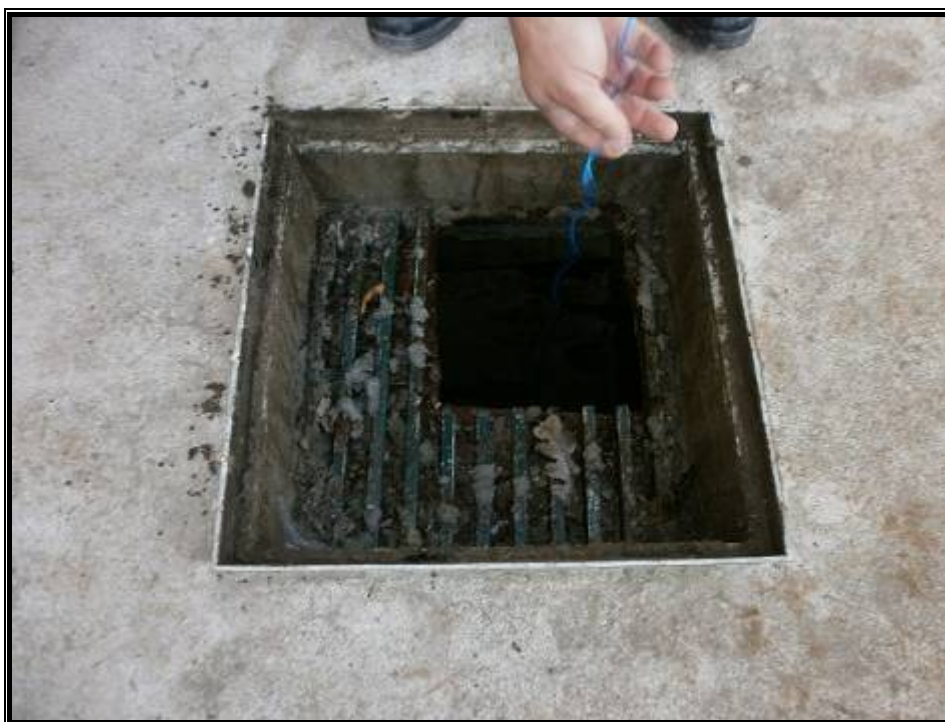
Φωτ. 5.1 Θέση δειγματοληψίας ύδατος από πηγάδι μέσα στο δημοτικό σχολείο του κολλεγίου Δελασάλ (δείγμα RZW1).
