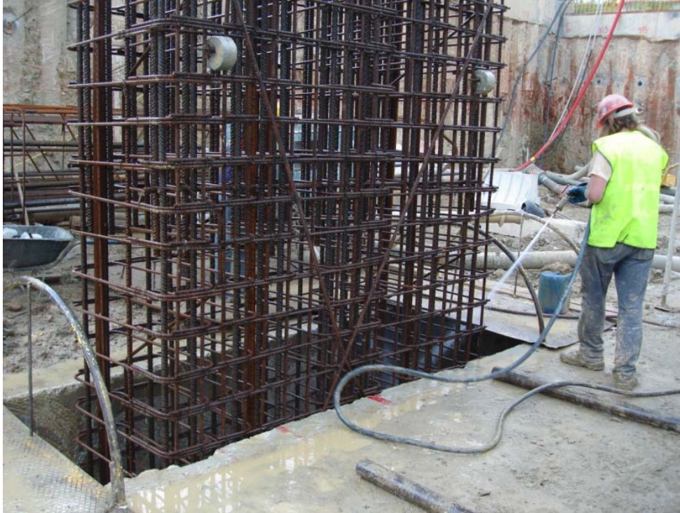
Σχήμα 54. Τοποθέτηση οπλισμού διαφραγματικού πανέλου (Ε. ΠΕΠΠΑΣ, 2014)
