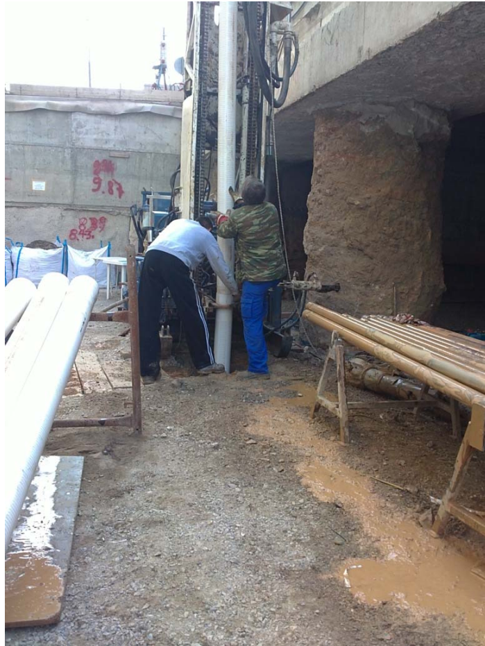
Σχήμα 52. Τοποθέτηση φιλτροσωλήνων σε υδρογεώτρηση στο σταθμό Πανεπιστήμιο (Ε. ΠΕΠΠΑΣ, 2014)
