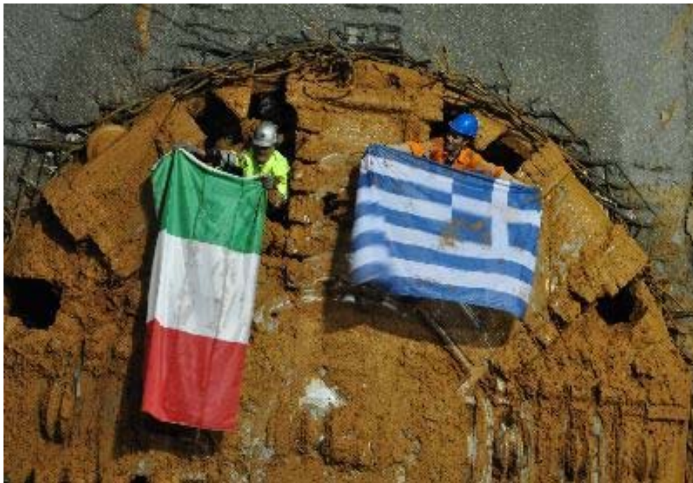
Σχήμα 8. Είσοδος μηχανήματος EPB –TBM σε σκαμμένο υπόγειο σταθμό Διασταύρωση Συντριβάνι ( www.ametro.gr )
