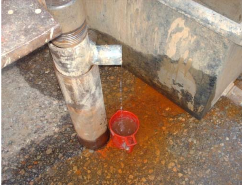
Σχήμα 49. Αρτεσιανισμός κατά την διάρκεια διάτρησης των πιεζόμετρων (Ε. ΠΕΠΠΑΣ, 2014)
