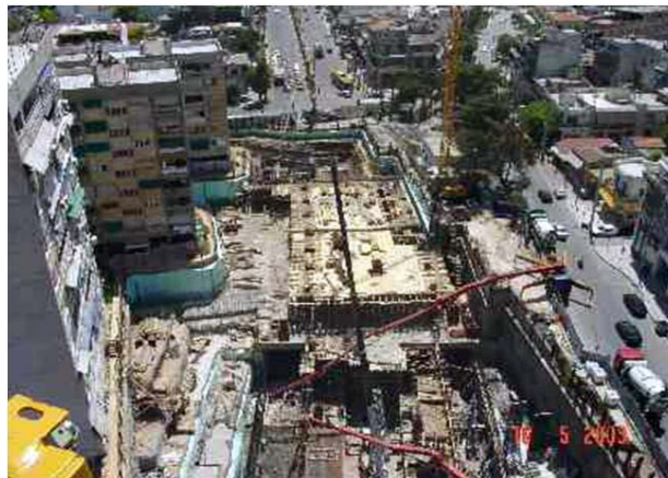
Σχήμα 1. Εκμετάλλευση του υπεδάφους για την κατασκευή Μετρό (Εργα αττικό Μετρό Αθηνών –Omikron Kappa Consulting.
