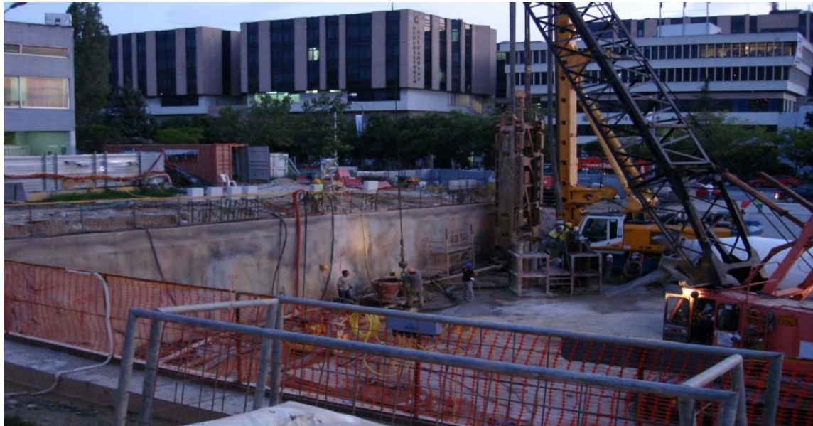
Σχήμα 53. Εκσκαφή διαφραγματικού με υδροφρέζα (Ε. ΠΕΠΠΑΣ, 2014)
