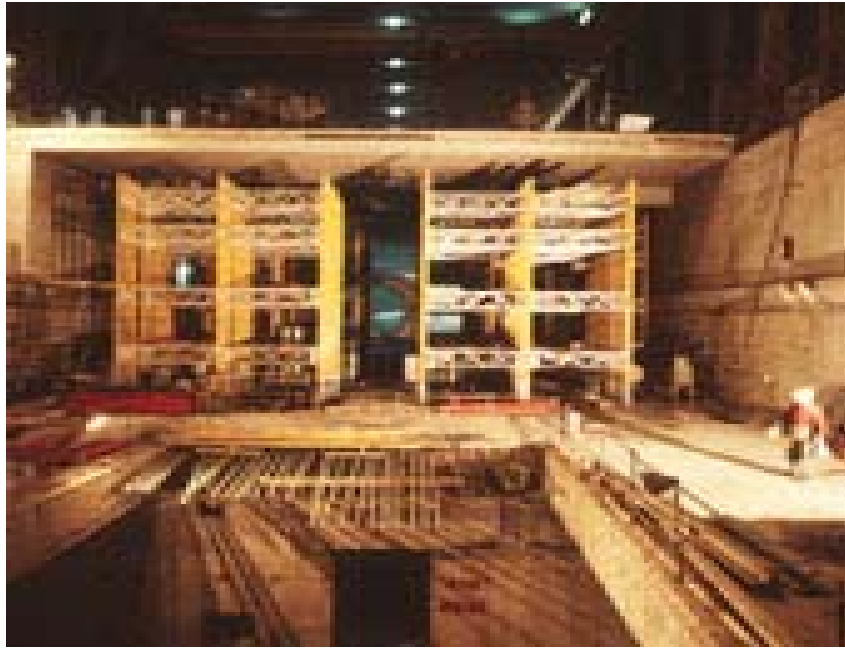
Σχήμα 6. Μέθοδος κατασκευής υπόγειου σταθμού (top down) ( www.ametro.gr )
