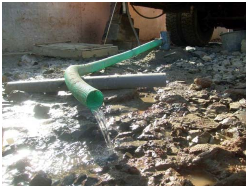
Σχήμα 50. Αρτεσιανισμός κατά την διάρκεια διάτρησης των πιεζόμετρων (Ε. ΠΕΠΠΑΣ, 2014)
