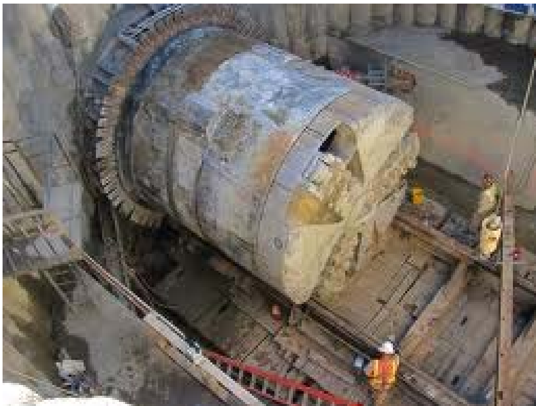
Σχήμα 9. Είσοδος μηχανήματος EPB –TBM σε σκαμμένο υπόγειο σταθμό Ευκλείδη (Ε. Πέππας, 2011)
