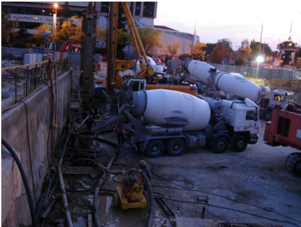
Σχήμα 55. Σκυροδέτηση διαφραγματικού πανέλου (Ε. ΠΕΠΠΑΣ, 2014)
