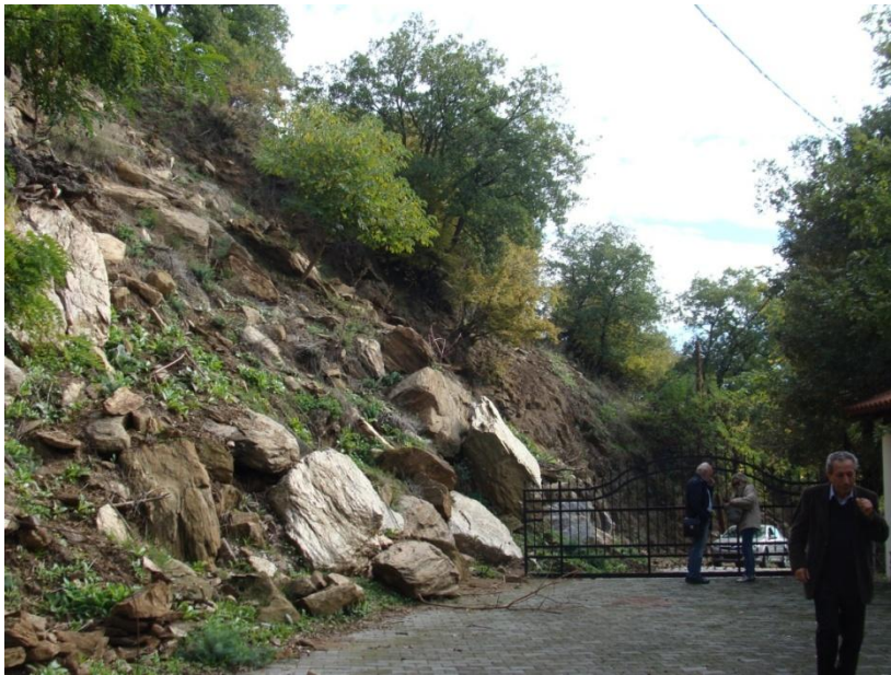
Εικ.6.1 Ο πόδας της κατολίσθησης στην είσοδο της κατασκήνωσης. Το σώμα της κατολίσθησης αποτελείται από σχιστολοθικούς όγκους μέσα σε εδαφικά υλικά αποσάθρωσης .
