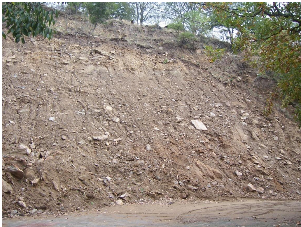
Φωτ.1: Η εικόνα του πρανούς με τον μεγάλο όγκο εδαφικού υλικού. Οι όγκοι των κατολισθαίντων σχιστολίθων έχουν απομακρυνθεί με σκαπτικό μηχανήμα. (Λήψη φωτ.Νοέμβρης 2013).
