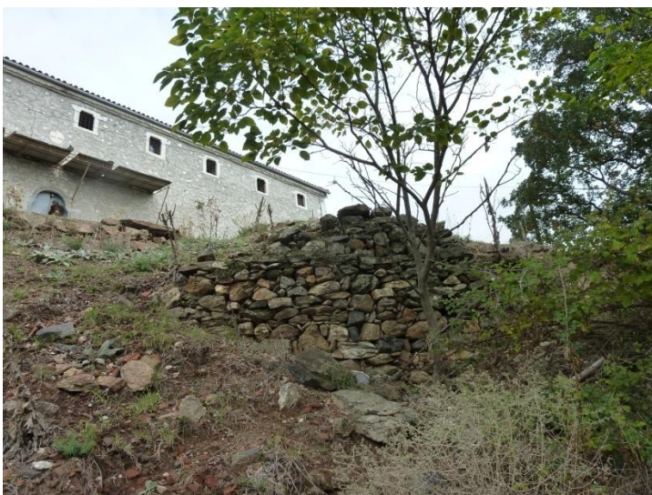
Εικ.6.5 Η εκκλησία του Αγ. Γεωργίου στα 25m από το άνω όριο της κατολίσθησης.
