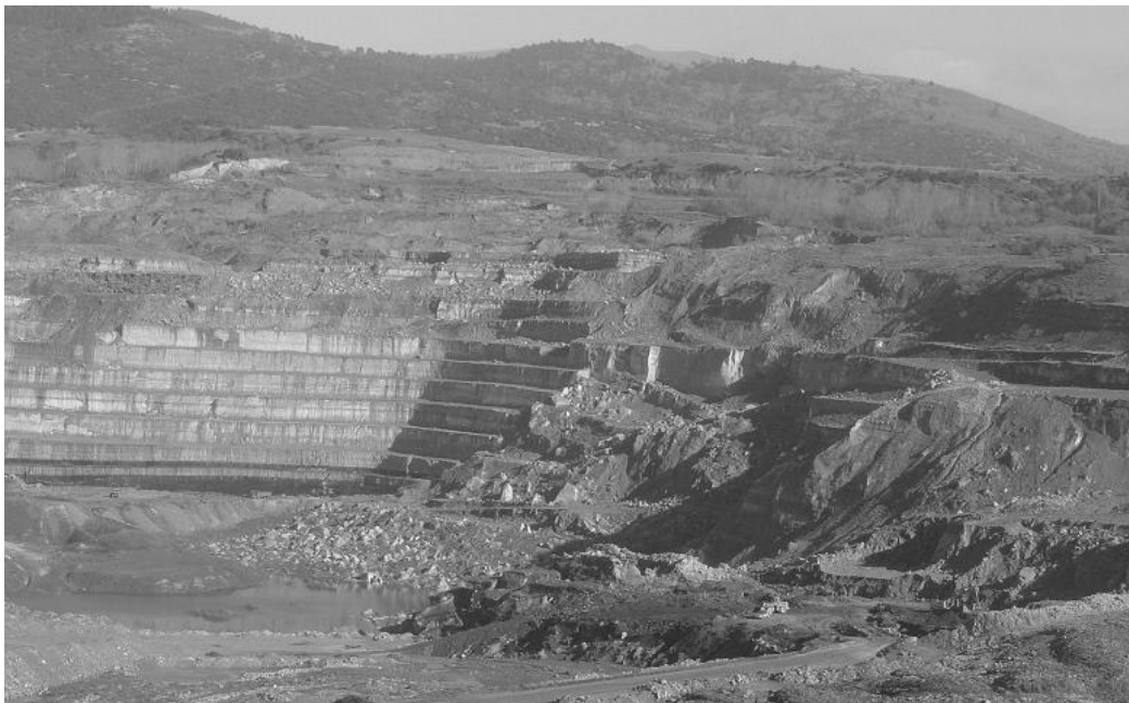
Σχήμα 4.5.6 Γενική άποψη του ορυχείου και της περιοχής της κατολίσθησης (Προυντζόπουλος et.al. 2010)
