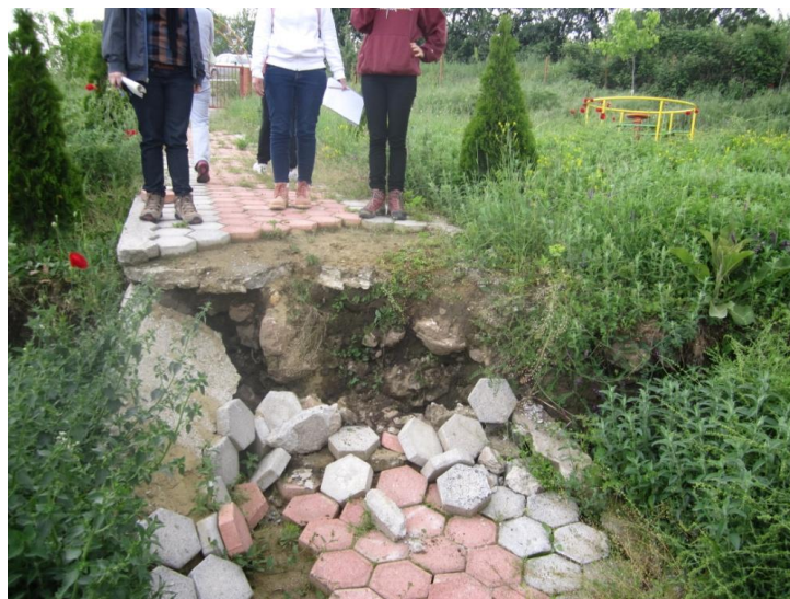
Επιφανειακές ρωγμές ανάμεσα στον οικισμό και το ορυχείο, ΒΔ του οικισμού και στον προαύλιο χώρο από το εκκλησάκι του Αγίου Νικολάου.
