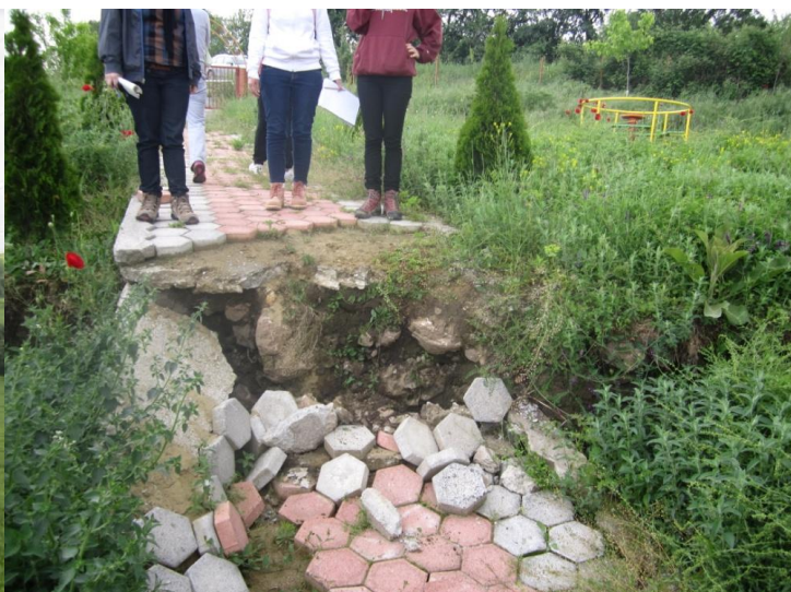
Σχήμα 5.31 Επιφανειακές ρωγμές ανάμεσα στον οικισμό και το ορυχείο, ΒΔ του οικισμού και στον προαύλιο χώρο από το εκκλησάκι του Αγίου Νικολάου.
