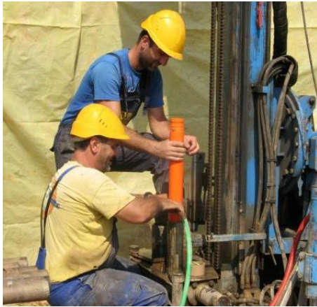
Σχήμα 1.4.1: Εγκατάσταση κλισιομετρικού σωλήνα και βολίδα
