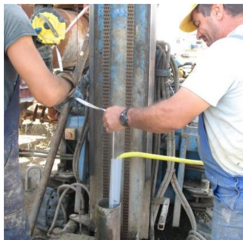
Σχήμα 1.4.3: Εικόνα από πιεζόμετρο και τοποθέτηση πιεζομέτρου για λήψη στάθμης
