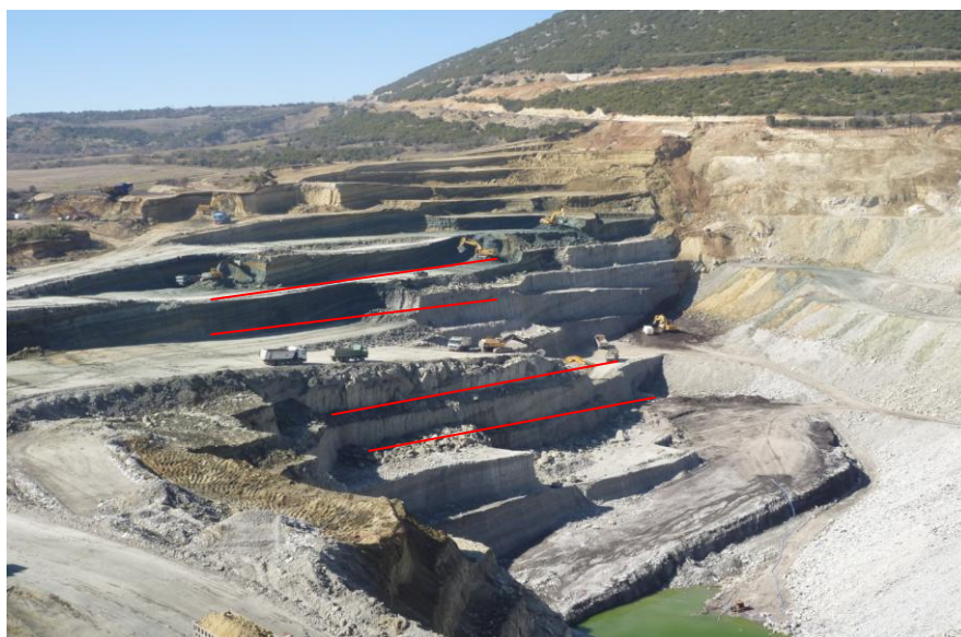
Σχ. 4.5.4 Οι παράλληλες επιφάνειες ασυνέχειας που εμφανίζονται στο μέτωπο της εκσκαφής.( Μαρίνος 2012)
