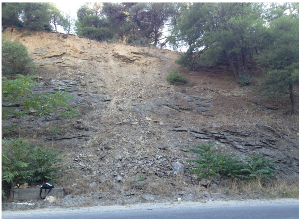
Εικόνα 4.9 Αποκολλήσεις μικρών τεμαχών – blocks στο πρανές
