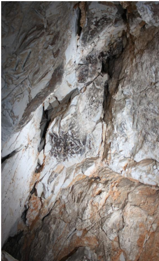
Εικόνα 32: Άποψη στην οροφή του KAST 6 κατά μήκος της διάκλασης ανάπτυξης
