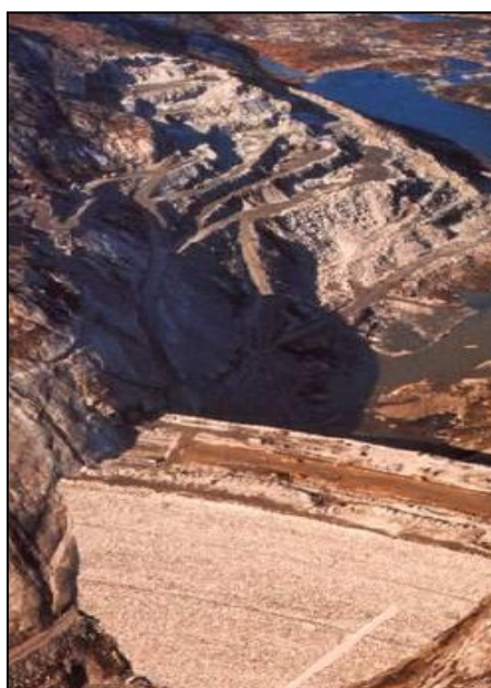
Σχήμα 1: Χωμάτινο φράγμα, διακρίνεται στο κέντρο ο αργιλικός πυρήνας, (Μαρίνος Β. 2011).
