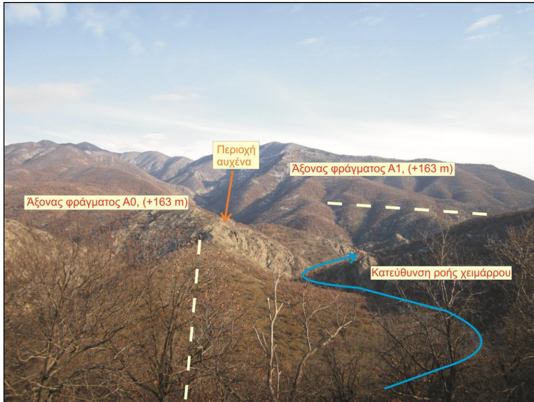
Σχήμα 4: Άποψη των δύο προτεινόμενων αξόνων, λήψη φωτογραφίας από το δεξί αντέρεισμα του Α0.
