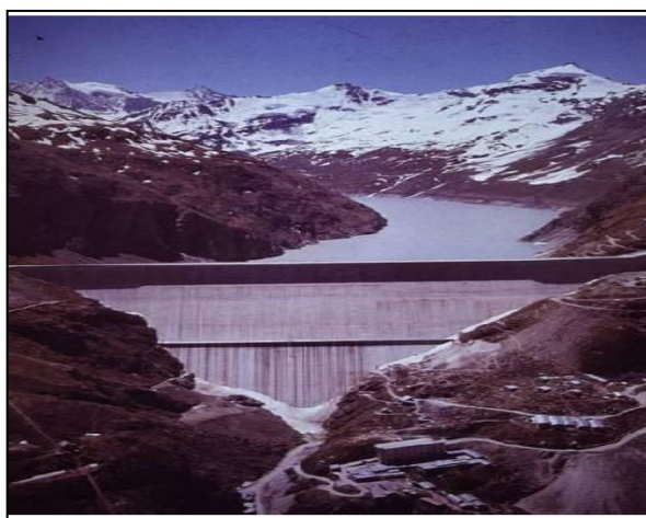
Σχήμα 2: Φράγμα βαρύτητας, (Μαρίνος Β. 2011).
