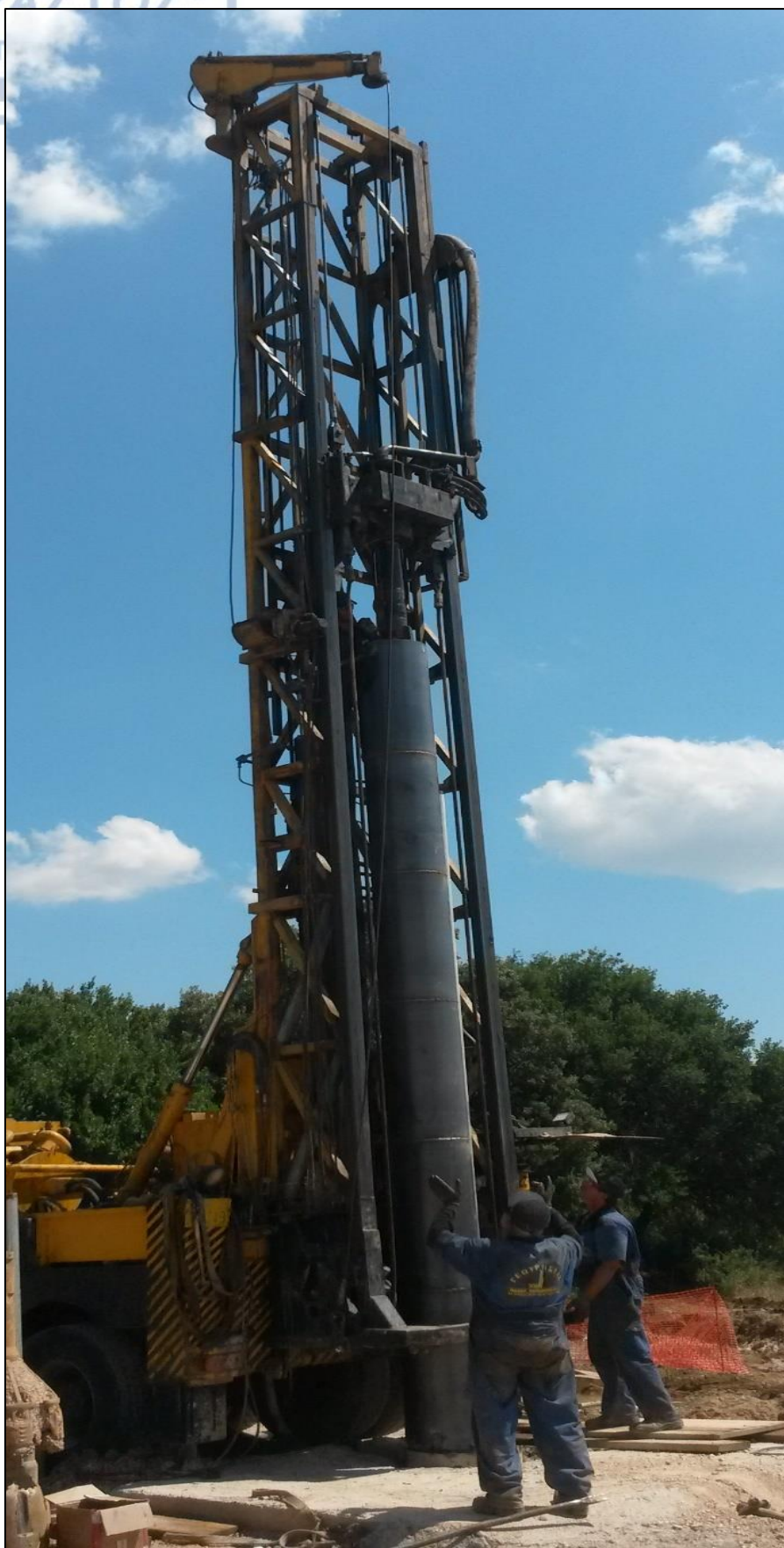
Σχήμα 14 - Ικρίωμα του γεωτρύπανου κατά τη φάση τοποθέτησης του 2ου Περιφραγματικού Σωλήνα
