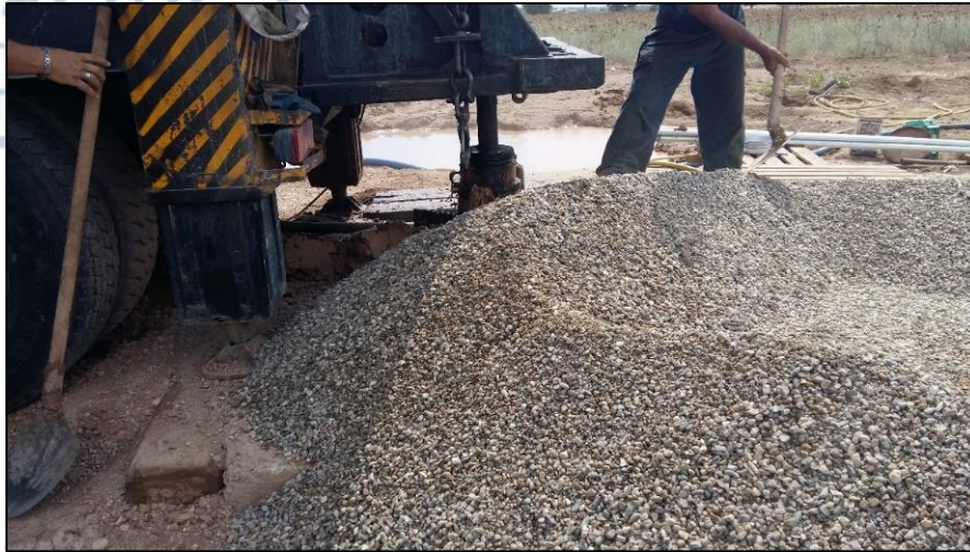
Σχήμα 24 - Χαλίκια για χρήση στο Χαλικόφιλτρο
