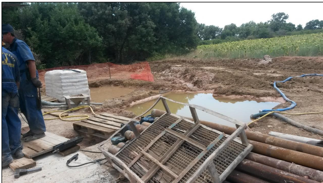
Σχήμα 12 - Λάκκοι παρασκευής του γεωτρητικού πολτού για την καθίζηση των τριμμάτων. Κάτω δεξιά διακρίνονται τα στελέχη του γεωτρυπάνου
