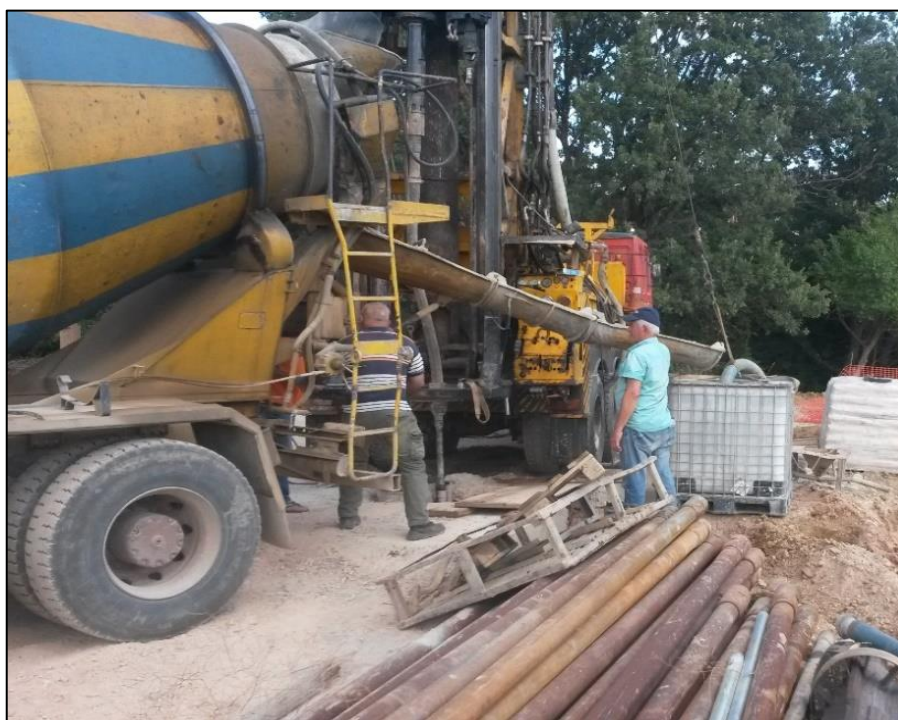
Σχήμα 18 - Διαδικασία Ενεμάτωσης
