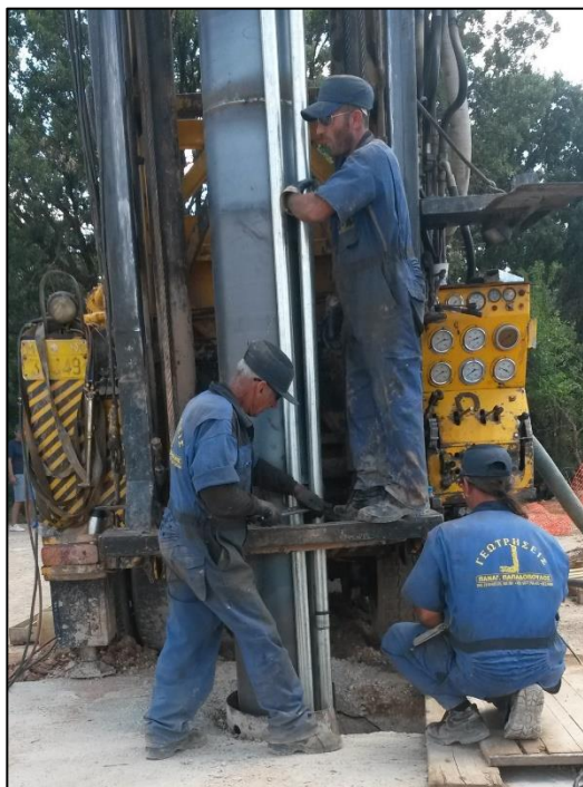
Σχήμα 17 - Τοποθέτηση 2ου Περιφραγματικού Σωλήνα (Αριστερά: Σωλήνας Ενέματος, Δεξιά: Πιεζόμετρο)
