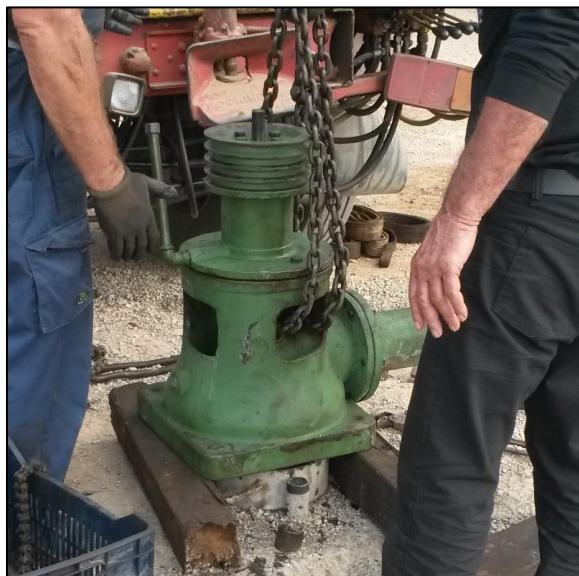
Σχήμα 26 - Τοποθέτηση της κεφαλής της πομόνας
