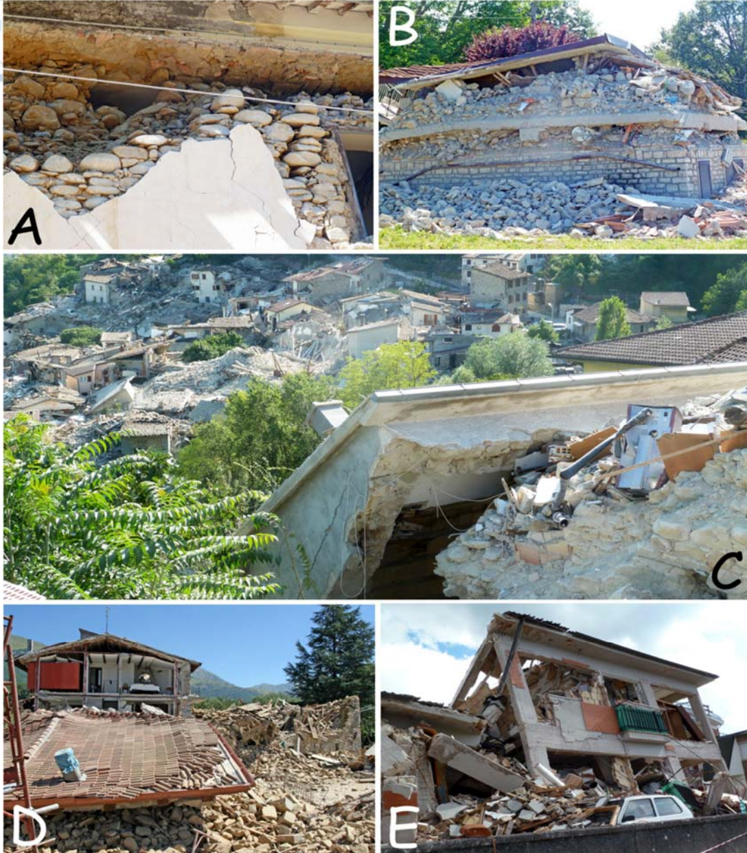
Σχήμα 2.3. Κτίρια και (κτίσματα, φτιαγμένα από υλικά του γεωλογικού υποβάθρου της περιοχής, μετά το σεισμό του Αυγούστου του 2016. (Livio et al., 2016)
