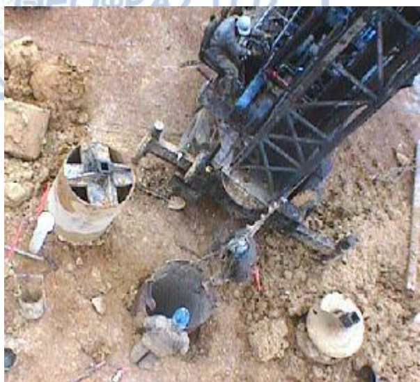
Εικ.12:Εγκατάσταση σωλήνωσης επαφής (Πηγή: GEORGAKOPOULOS ΕΥΣΤΑΘΕΙΑ ΓΕΩΤΡΗΣΕΩΝ.pdf)
