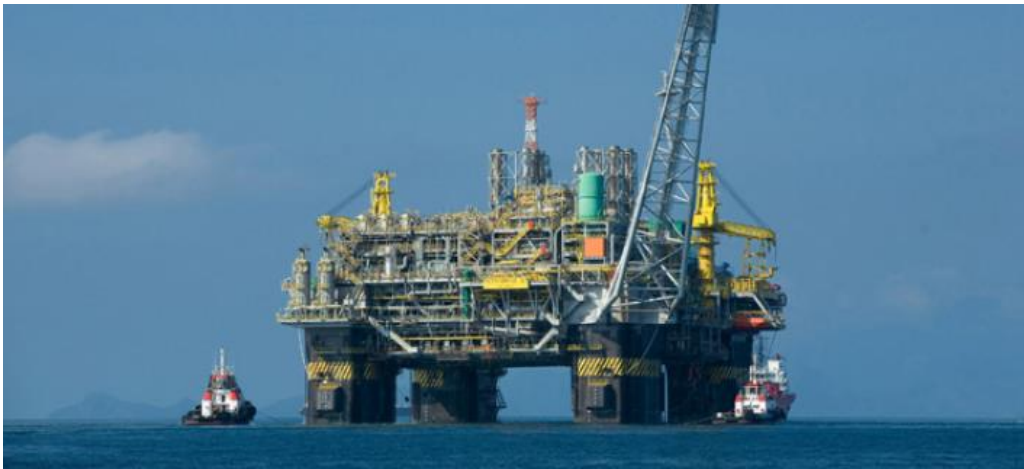
Εικ.4: Πλαίσιο στήριξης γεωτρύπανου σε θαλάσσιο περιβάλλον, όπου το γεωτρύπανο μεταφέρεται με πλωτή κατασκευή (Πηγή: http://www.iefimerida.gr )
