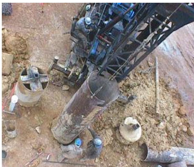
Εικ.12:Εγκατάσταση σωλήνωσης επαφής (Πηγή: GEORGAKOPOULOS ΕΥΣΤΑΘΕΙΑ ΓΕΩΤΡΗΣΕΩΝ.pdf)
