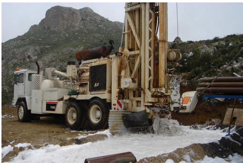
Εικ.2: Υδραυλικό κρουστικό γεωτρύπανο (Πηγή: http://www.drillmaster.gr )
