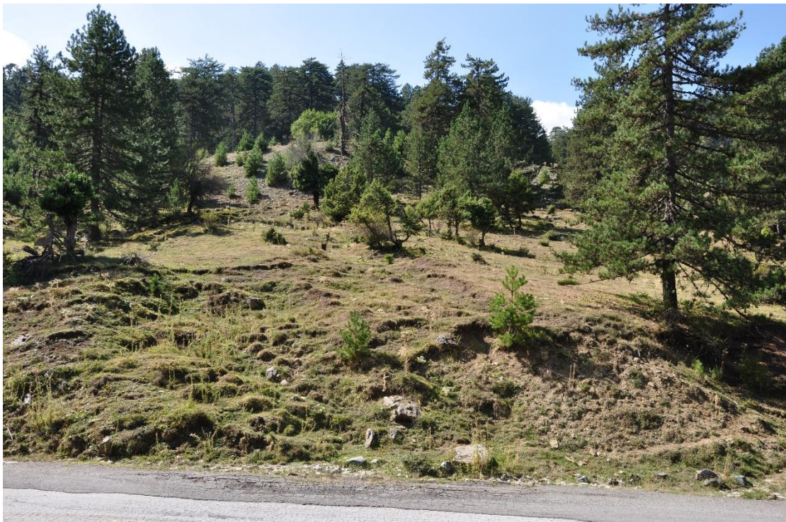
Εικόνα 7.27 Η κατολίσθηση Ls_Per8. Παρατηρούνται εξάρσεις στο ανάγλυφο και στο κατώτερο μέρος της φωτογραφίας παρατηρείται αναθόλωση και διάρρηξη του δρόμου εξαιτίας της δράσης αυτής.
