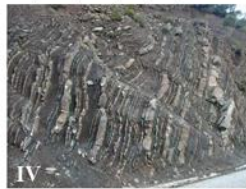
Τύπος IV. Μέτρια διαταραγμένη βραχώμαζα αποτελούμενη από εναλλαγές ψαμμίτη-ιλιούθου σε ίσες αναλογίες
