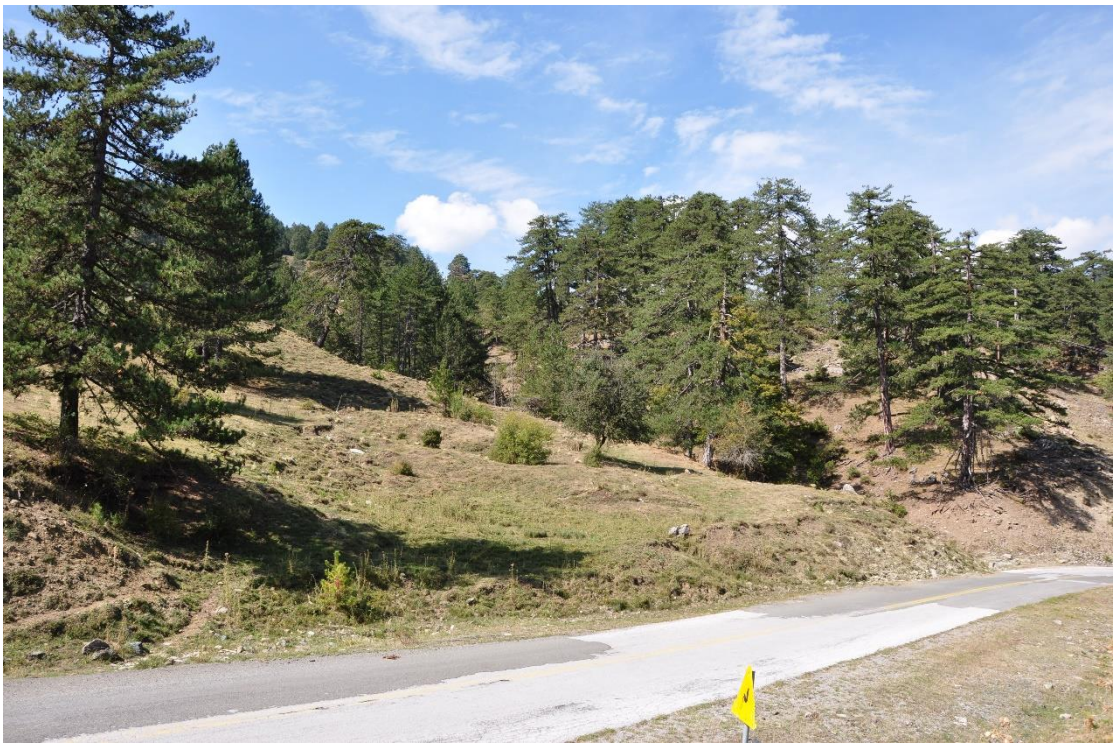
Εικόνα 8.4 Το πόδι της κατολίσθησης όπως αυτό εμφανίζεται στην ύπαιθρο. Προεκτείνεται και στα κατάντη του δρόμου
