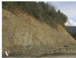
Τύπος V. Μέτρια διαταραγμένη βραχώμαζα αποτελούμενη από ιλιούθου με ενστρώσεις ψαμμίτη
