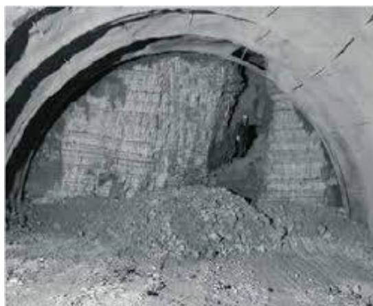
Εικόνα 2.9: Το καρστικό κενό το οποίο «άδειασε» στο εσωτερικό της σήραγγας. (Πηγή: Σήραγγες στην Ελλάδα, γεωλογία, σχεδιασμός, κατασκευή 2016)
