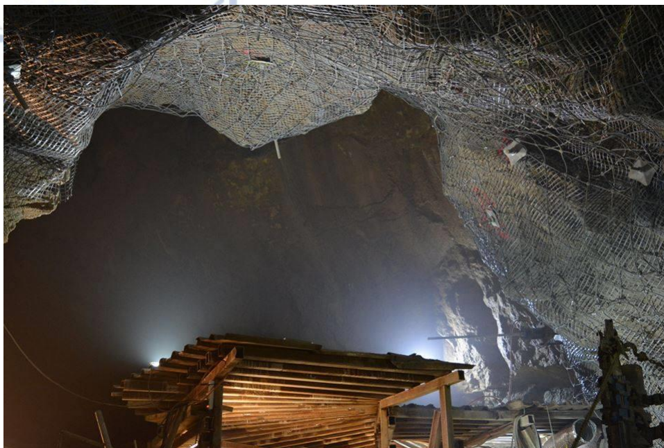
Εικόνα 2.8: Το εσωτερικό του καρστικού σπηλαίου της σήραγγας Αποσελέμη (Πηγή: Σήραγγες στην Ελλάδα, γεωλογία, σχεδιασμός, κατασκευή 2016)
