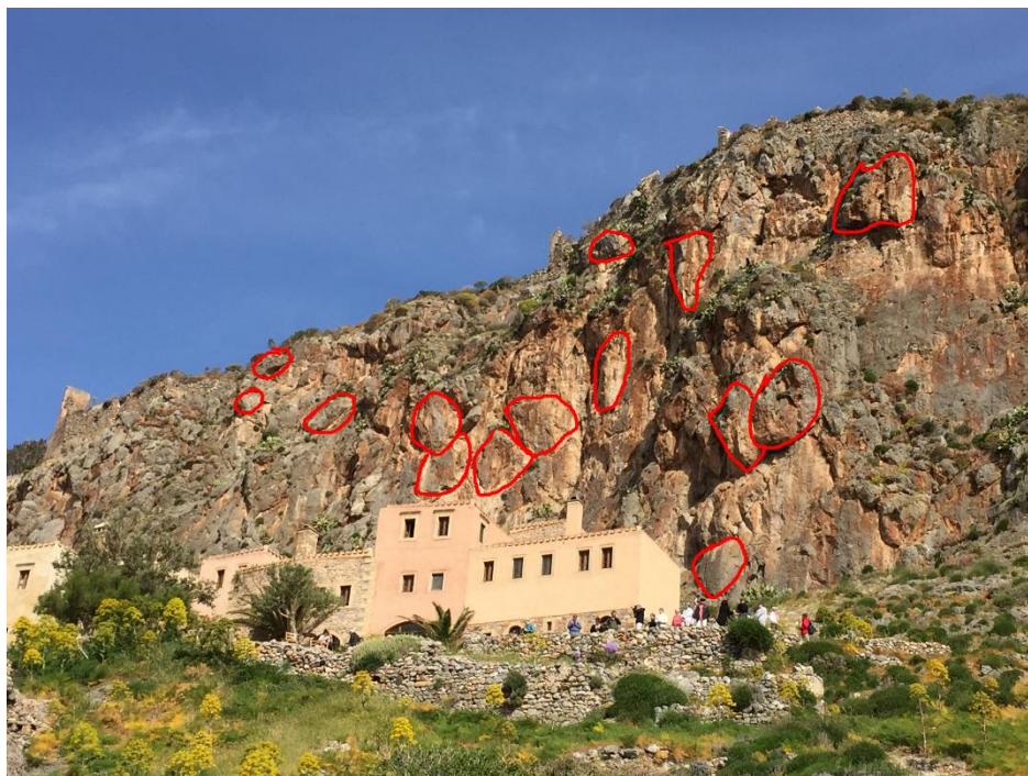
Εικόνα 5.14. Μεγάλα επισφαλή τεμάχη στο πρανές 1
