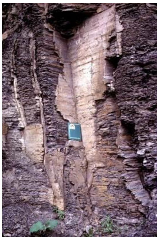
Εικόνα 1.4. Σφηνοειδής ολίσθηση, State Route 2, West Virginia (Πηγή: http://dipanalyst.com )
