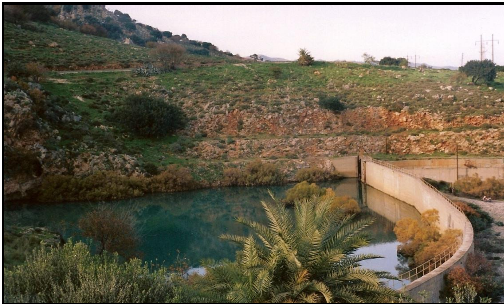
Εικόνα 39 Σημερινή εικόνα της πηγής του Αλμυρού Ηρακλείου και η κατασκευή του επιπλέον φράγματος (Arfib et al., 2007).
