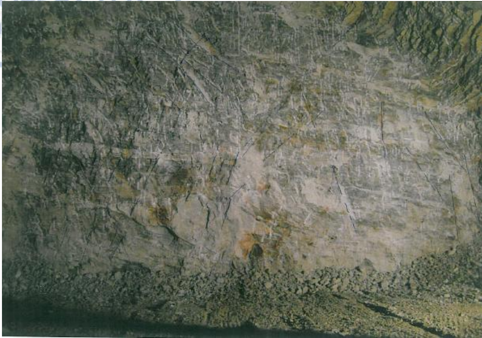
Σχήμα 85: Ανακρυσταλλωμένος ασβεστόλιθος τύπου k1 σε μέτωπο του Βόρειου κλάδου της T2 σήραγγας στην χιλιομετρική θέση 9279,6m (από Δελτίο Χαρτογράφησης Μετώπου ).
