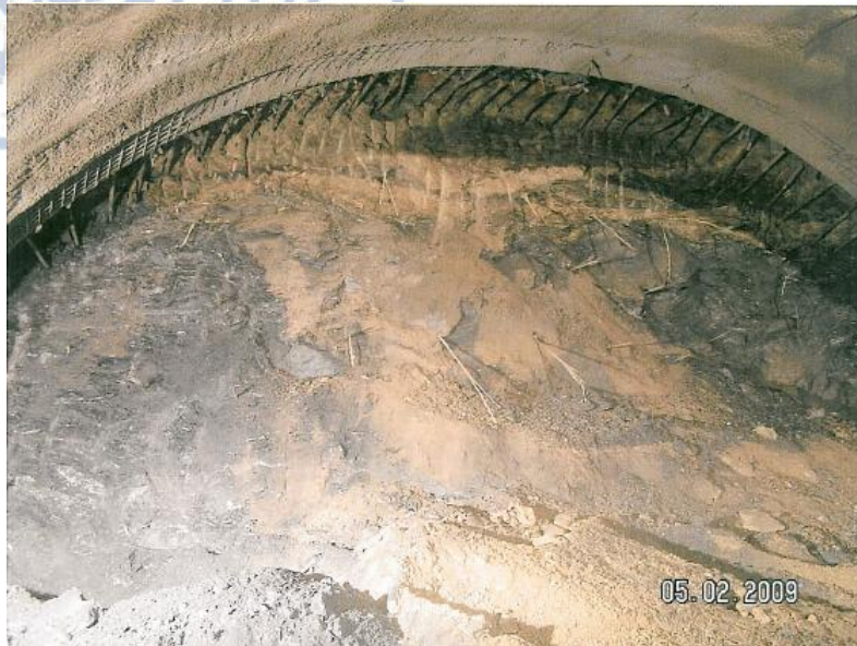
Σχήμα 34: Ενδεικτική εικόνα του ανακρυσταλλωμένου ασβεστόλιθου κατά την διάνοιξη της σήραγγας T2 των Τεμπών (από Δελτίο Χαρτογράφησης Μετώπου).
