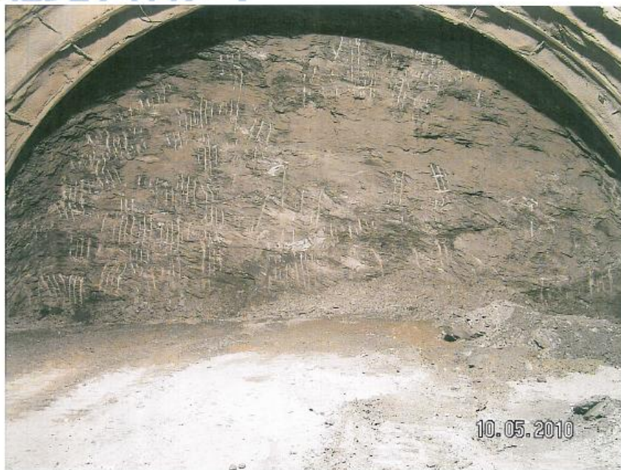
Σχήμα 83: Φυλλίτης τύπου rh1 σε μέτωπο του Βόρειου κλάδου της T2 σήραγγας στην χιλιομετρική θέση 10702.2m (από Δελτίο Χαρτογράφησης Μετώπου).
