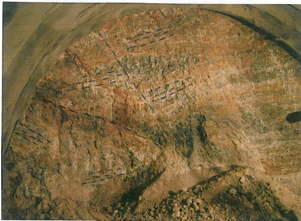
Σχήμα 86: Ανακρυσταλλωμένος ασβεστόλιθος τύπου k2 σε μέτωπο του Βόρειου κλάδου της T2 σήραγγας στην χιλιομετρική θέση 8631,6m (από Δελτίο Χαρτογράφησης Μετώπου).
