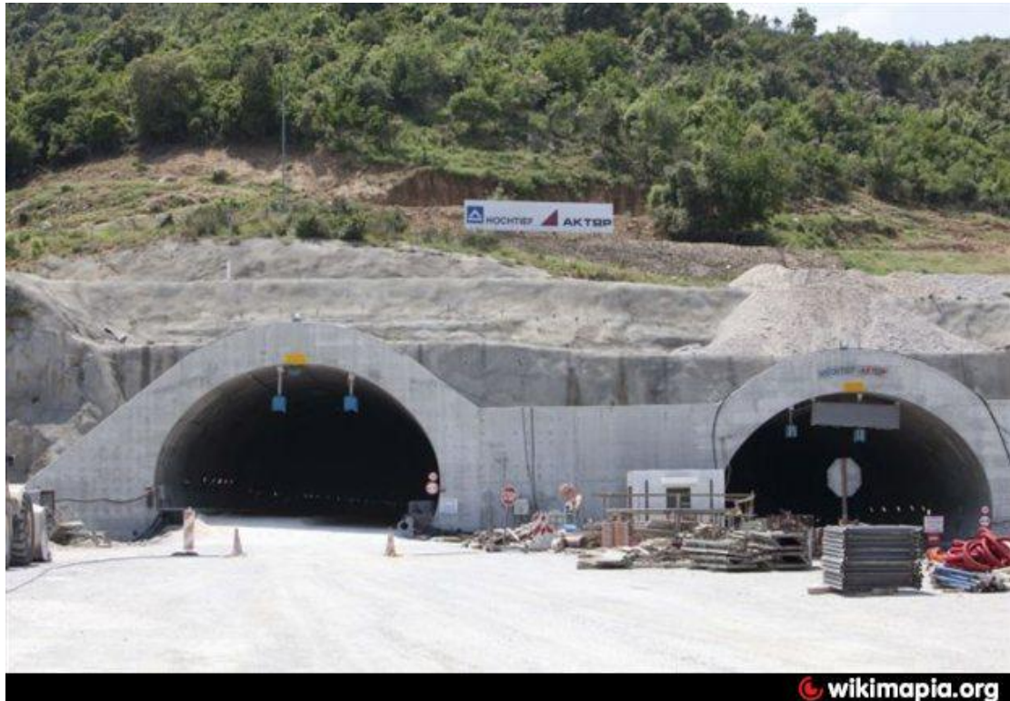
Σχήμα 1: T2 δίδυμες σήραγγες κατά την διάρκεια κατασκευής τους (wikimapia.org).
