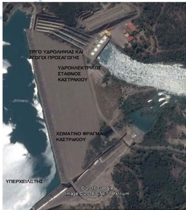
Φωτ. 2-8: Χωμάτινο φράγμα Καστρακίου, Ν. Αιτωλοακαρνανίας και συνοδά έργα φράγματος (Google Earth)
