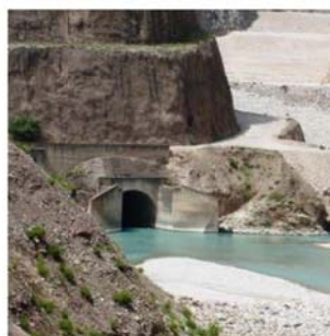
Είσοδος και έξοδος σήραγγας εκτροπής φράγματος Ιλαρίωνα
