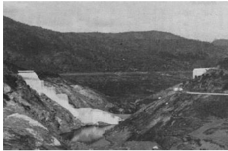
Φωτ. 2-15: Τοξωτό Φράγμα Malpasset, όψη από κατάντη πριν και μετά την αστοχία του (Duffault, 2013)
