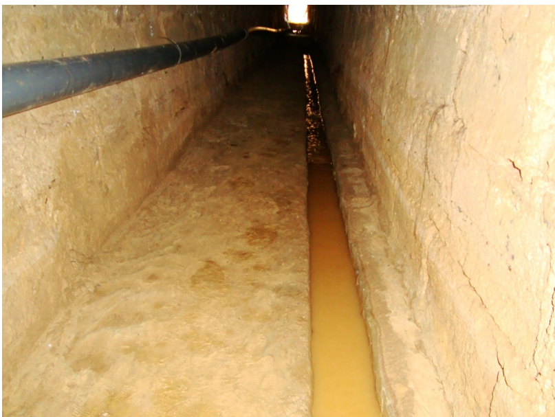
Εικ.21: Το τούνελ του Qanat Ροδολίβους. Διακρίνεται κάτω δεξιά το κανάλι μεταφοράς νερού. Το χρώμα του νερού οφείλεται σε εργασίες του δήμου.
