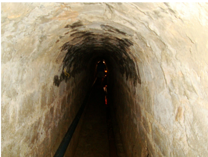
Εικ.20: Το τούνελ του Qanat Ροδολίβους. Διακρίνεται η θολωτή οροφή και η κατασκευή των τοιχωμάτων από πέτρες
