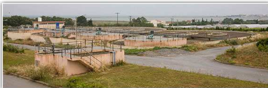
Εικόνα 14: Οι εγκαταστάσεις του βιολογικού σταθμού επεξεργασίας λυμάτων «Αίνεια» ( http5 ).
