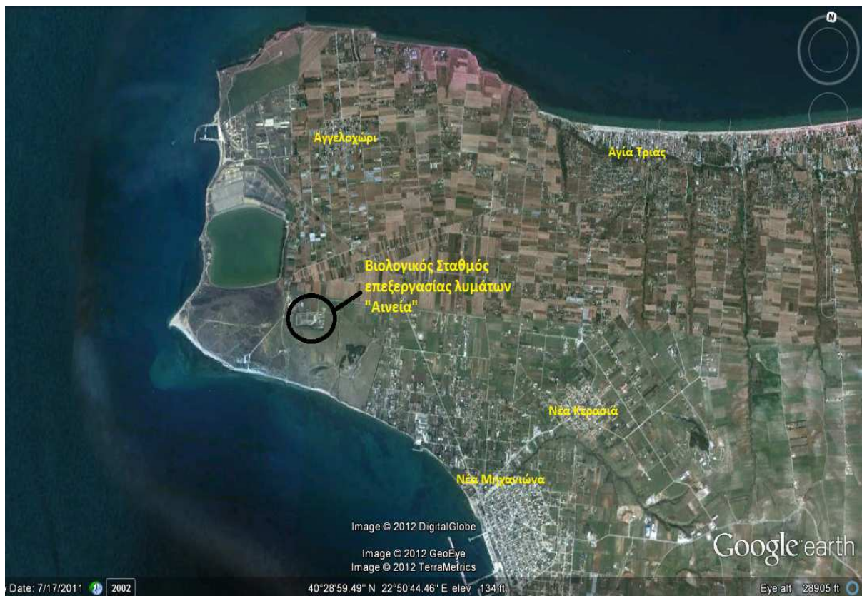
Εικόνα 12: Άποψη του Βιολογικού σταθμού επεξεργασίας λυμάτων από αεροφωτογραφία. (Google earth).
