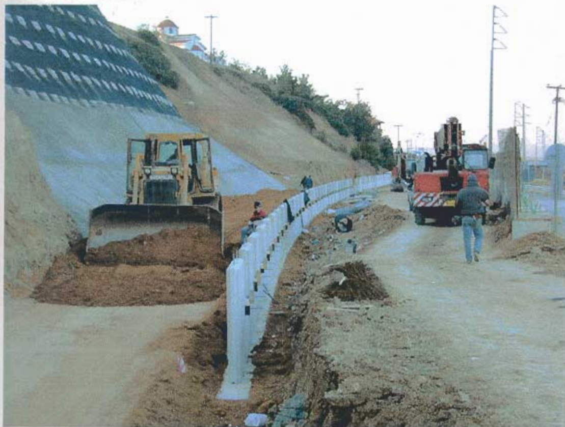
Φωτ. 8 Εξέλιξη έργου 4
