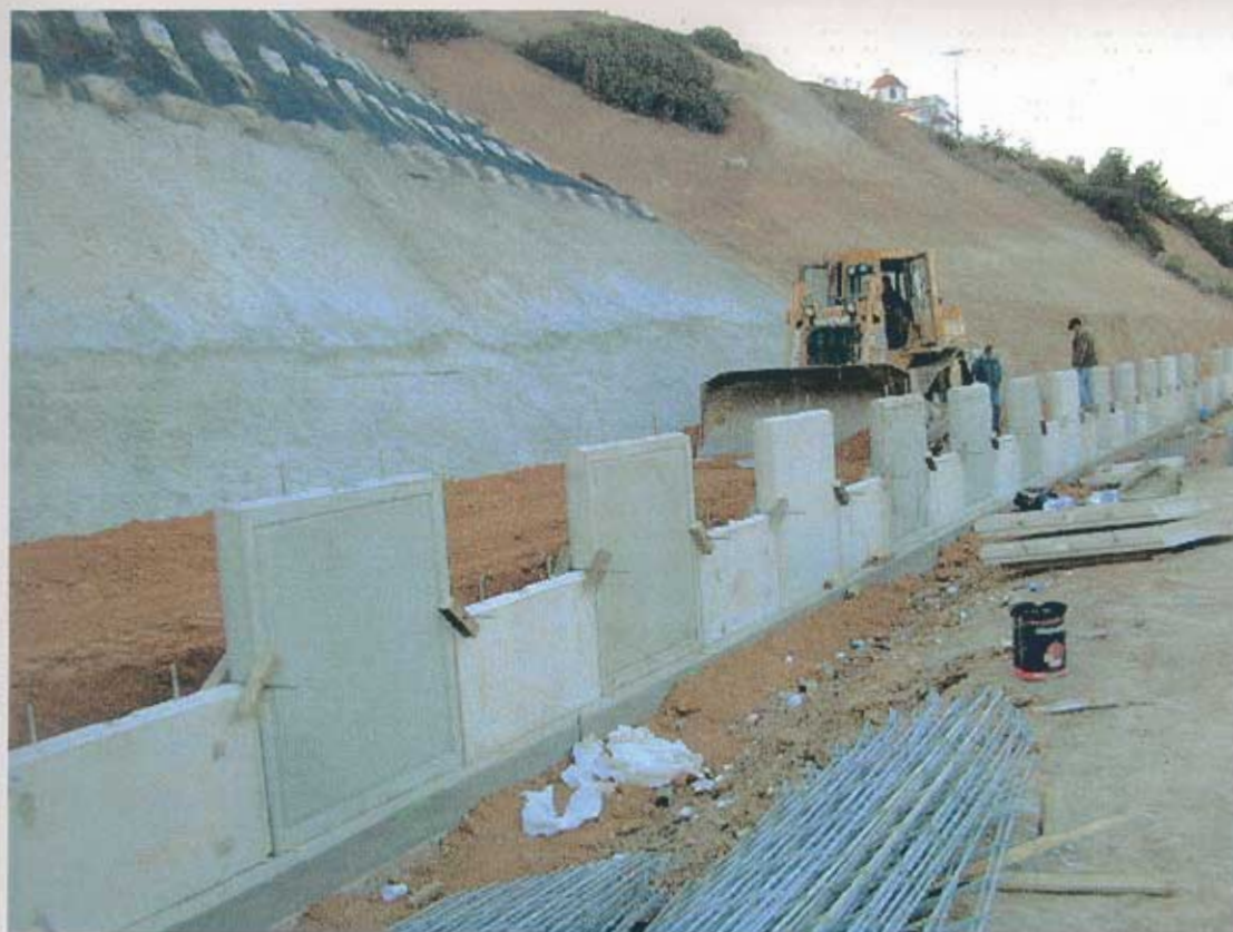
Φωτ. 7 Εξέλιξη έργου 3.
