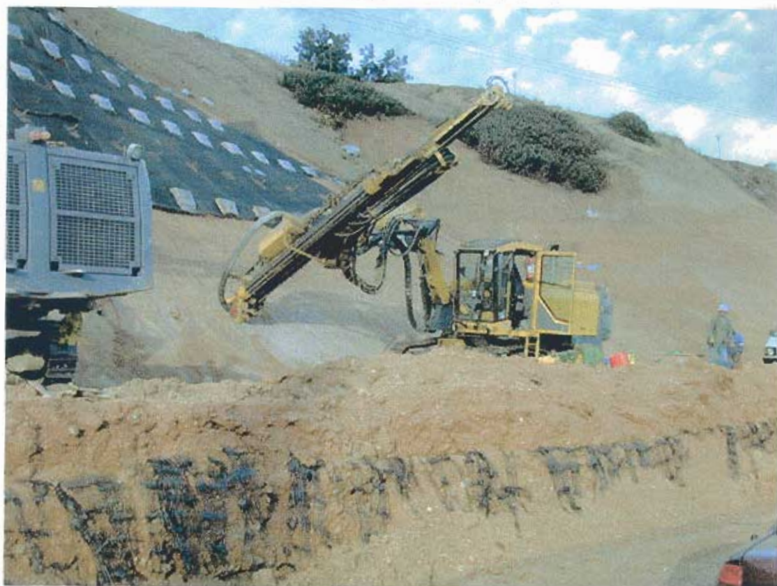
Φωτ. 3 Τοποθέτηση αγκυρίων
