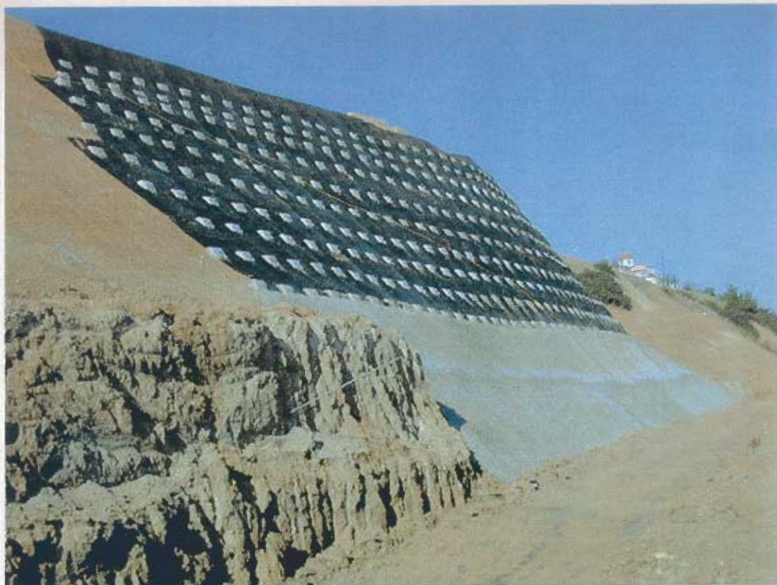
Φωτ. 5 Εξέλιξη έργου 1.
