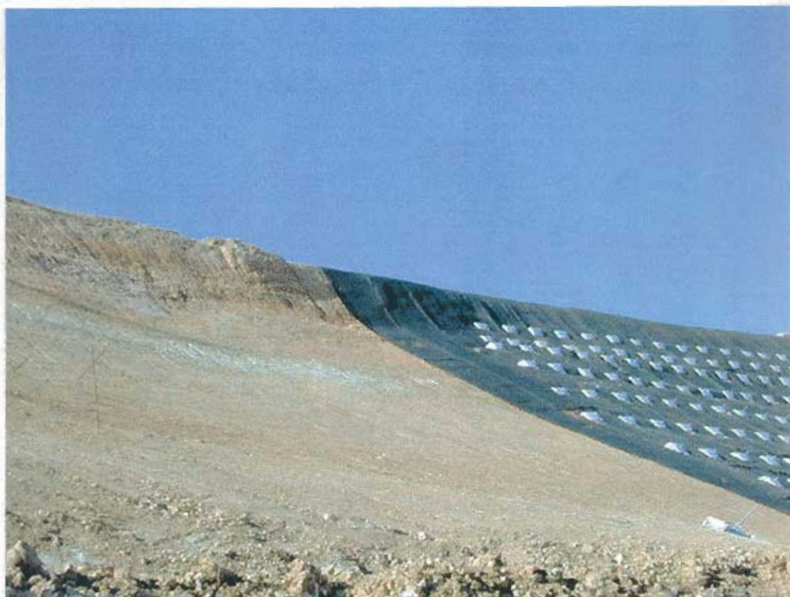
Φωτ. 6 Εξέλιξη έργου 2.
