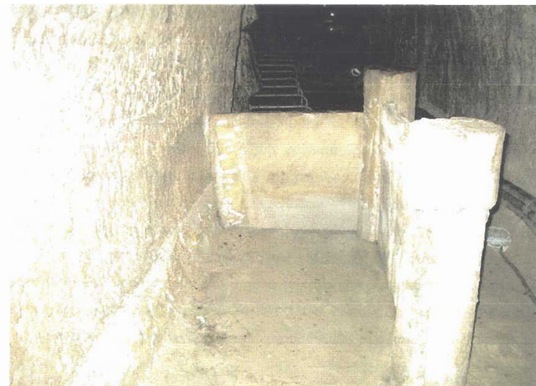
Φωτ. 9.6.1 Η δεξαμενή νερού , που χρονολογείται από την εμφάνιση των πρώτων Χριστιανών στο νησί.
