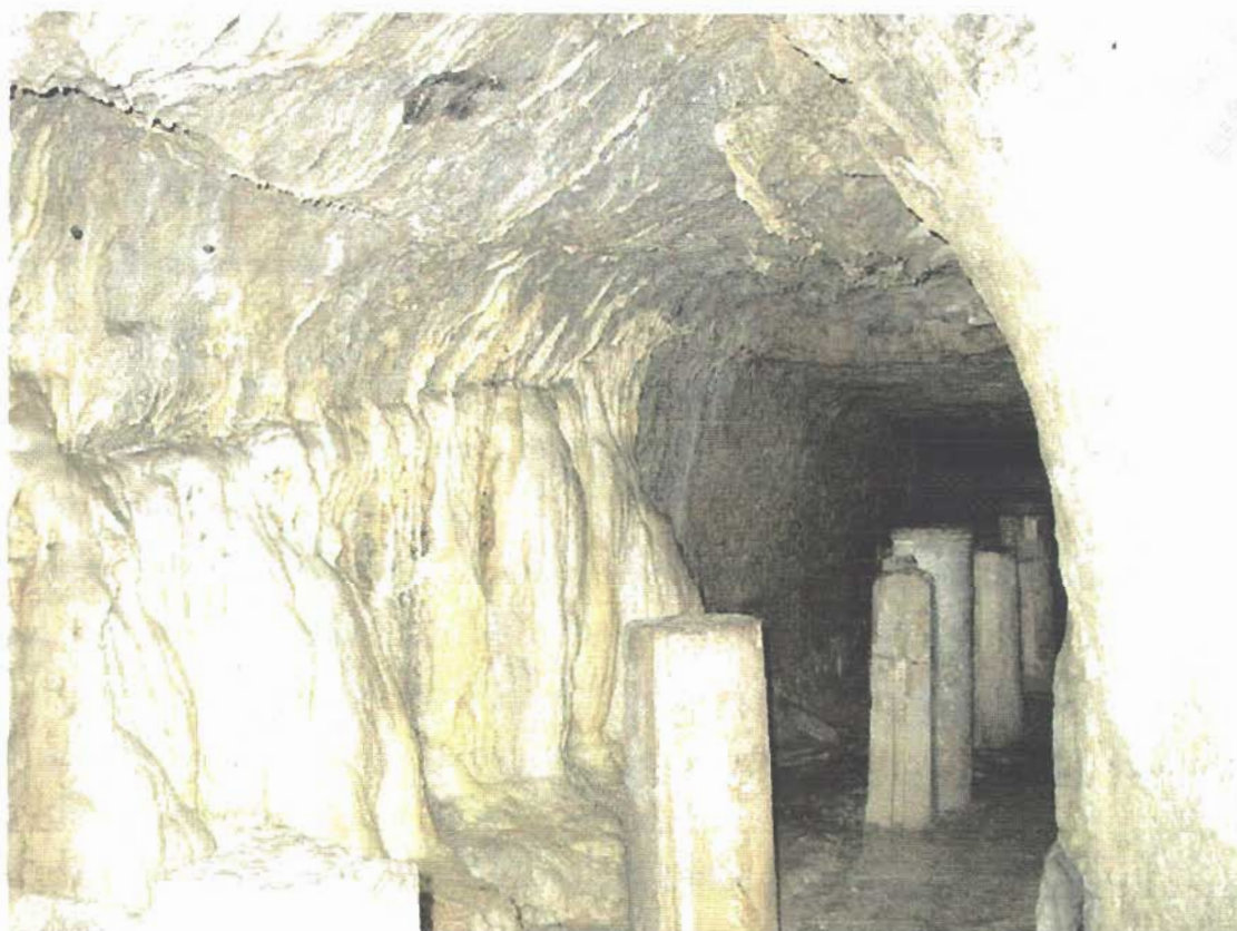
Φωτ. 9.6.2 Δράση καρστικού νερού στη σήραγγα του Ευπαλινείου. Διακρίνονται επιχρίσματα \text{CaCO}_3 στην πλευρά της δεξαμενής συγκέντρωσης ύδατος κάτω δεξιά.
