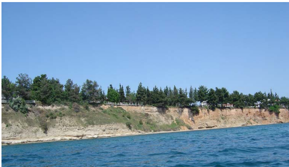
Εικόνα 14: Αυλή σπιτιού που πέφτει λόγω διάβρωσης
