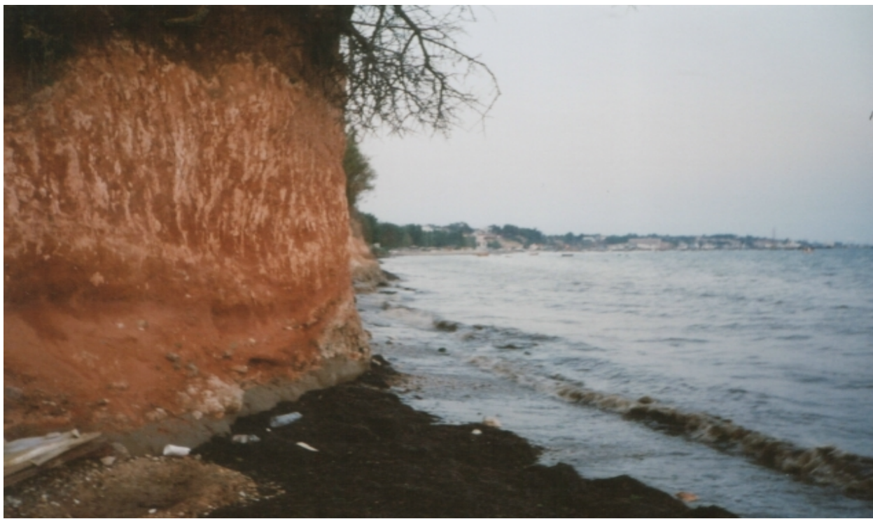
Εικόνα 5: Περιοχή όπου διακρίνεται η διάβρωση
