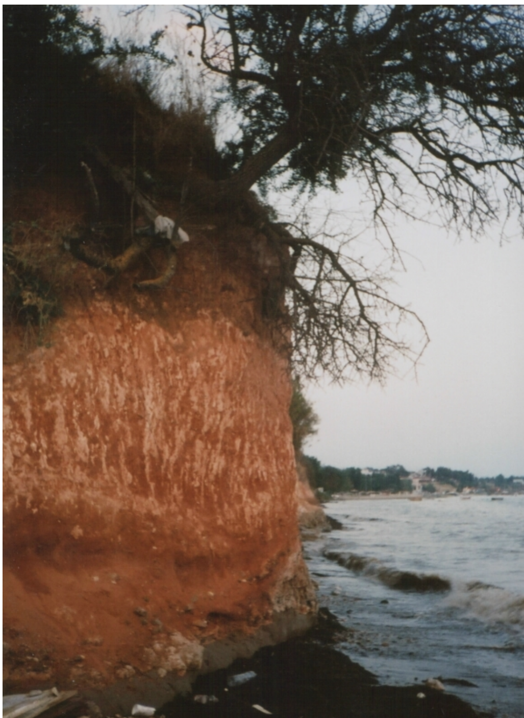
Εικόνα 12: Περιοχή όπου διακρίνεται η διάβρωση
