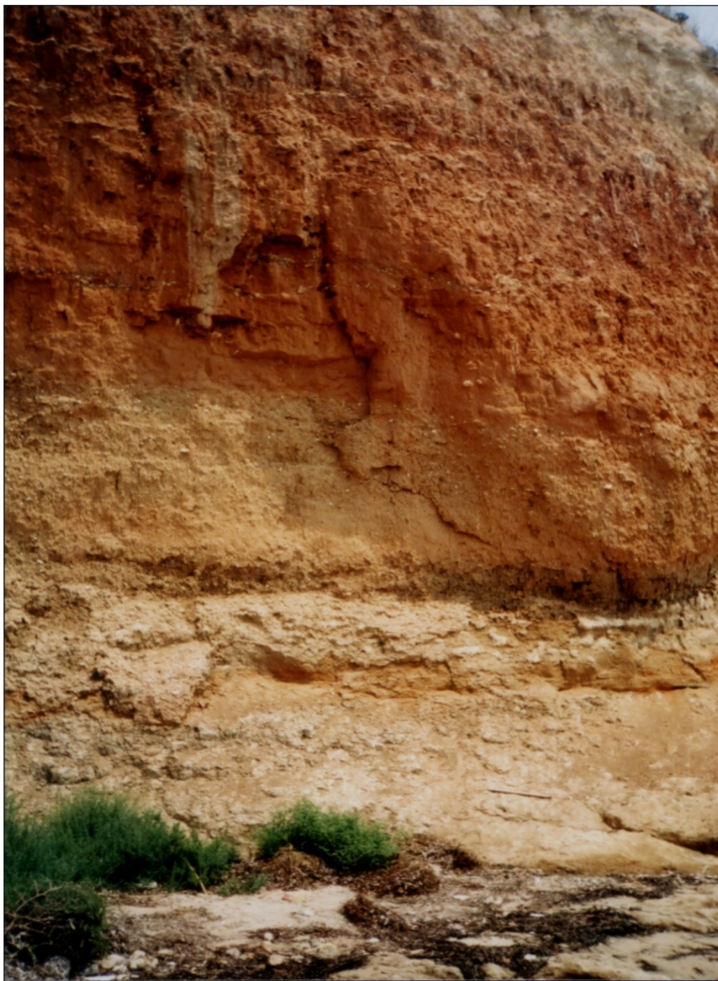
Εικόνα 8: Περιοχή όπου διακρίνεται η διάβρωση
