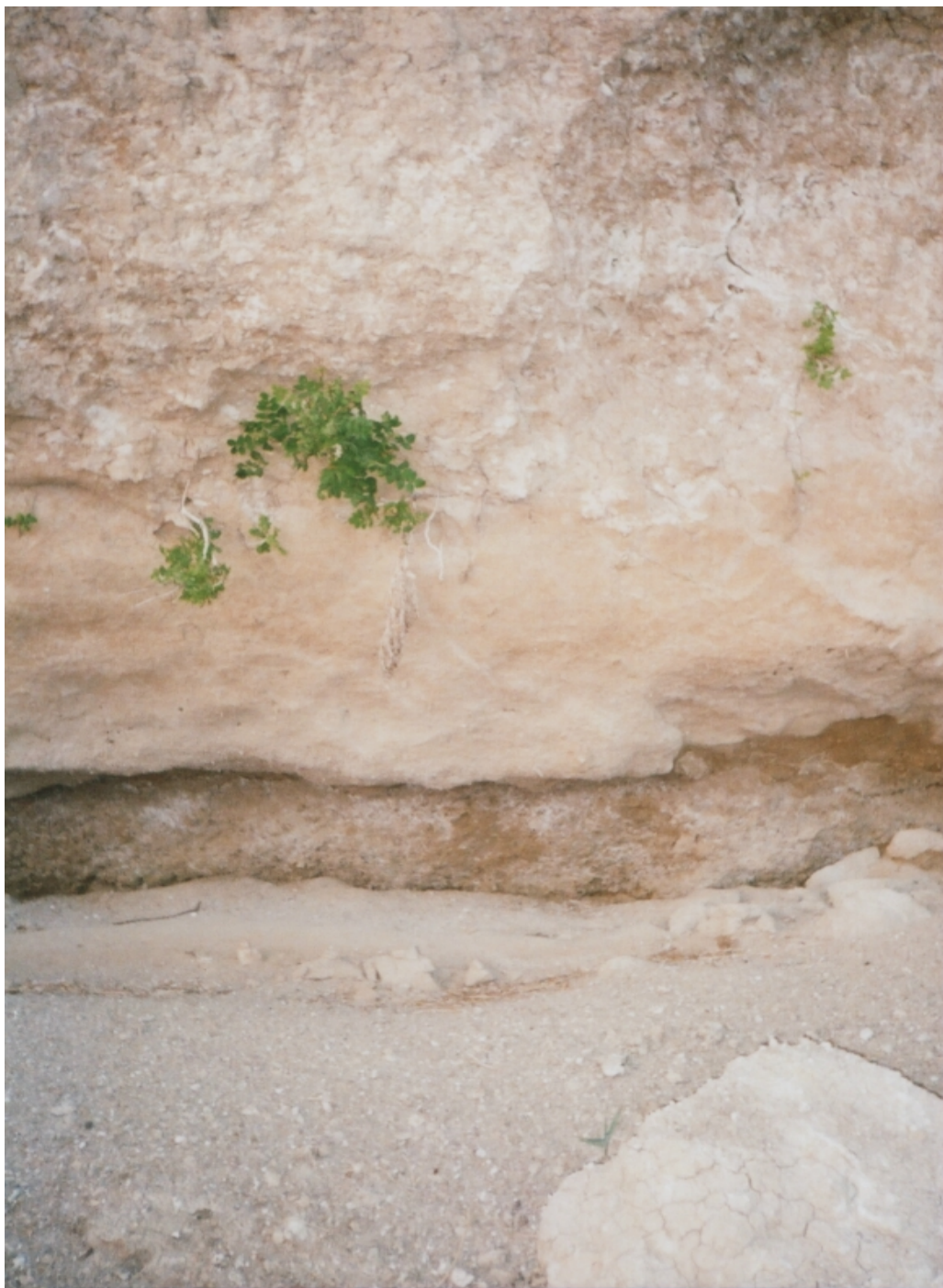
Εικόνα 6: Περιοχή όπου διακρίνεται η διάβρωση και συγκεκριμένα η υποσκαφή της βάσης της αναβαθμίδας
