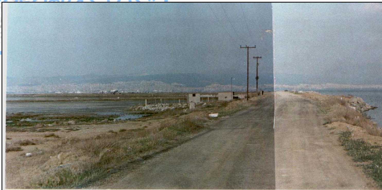
Φωτογραφία 3. Άποψη του παράκτιου αναχώματος νότια του Καλοχωρίου. Διακρίνεται η συγκέντρωση νερού στο εσωτερικό του αναχώματος και το αντλιοστάσιο απαγωγής και μεταφοράς αυτού προς τη θάλασσα, η οποία βρίσκεται σε υψηλότερη στάθμη.
