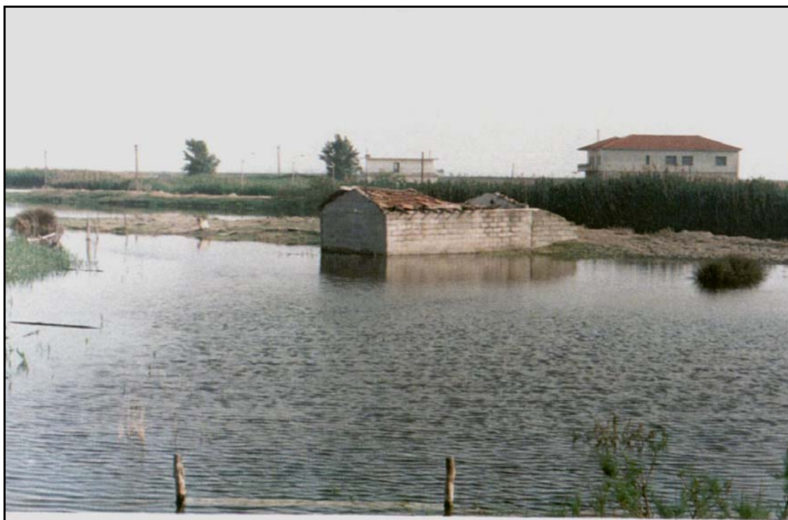
Φωτογραφία 2. Οικίσκος στις εκβολές του Γαλλικού ποταμού, που λόγω των εδαφικών υποχωρήσεων περιβρέχεται πλέον από τα νερά της θάλασσας.
