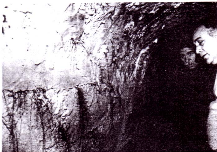
Φωτ. 9. Η διείσδυση ριζών πεύκων από τους αρμούς των τοιχωμάτων των Qanat και η ανάπτυξή τους μέσα στα τούννελ προκαλεί μείωση της παροχής κατά την θερινή περίοδο (Βαβλιάκης, 1989).
