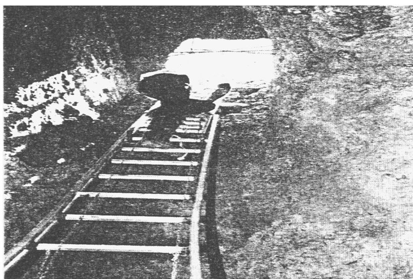
Φωτ. 3. Άποψη του εσωτερικού χώρου πηγαδιού του Qanat της Ν. Ζίχνης. Η διαφορά της διαμέτρου είναι ενδεικτική του σχήματος της φιάλης του πηγαδιού (Βαβλιάκης 1989).
