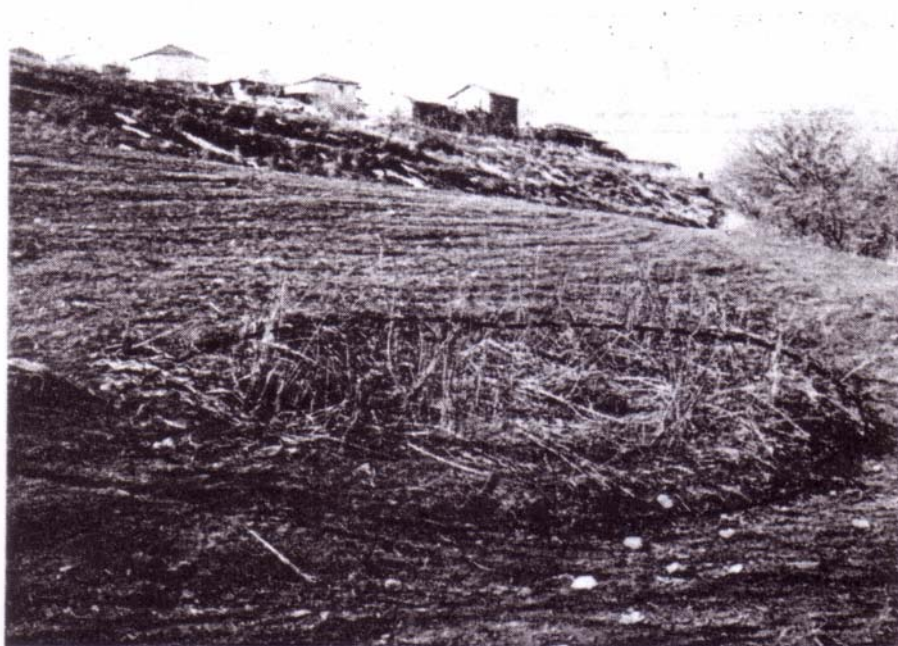
Φωτ. 10. Το επιφανειακό έγκοιλο που σχηματίστηκε το 1985 όταν υποχώρησαν τα τοιχώματα του υποκείμενου ανατολικού Qanat Αγγίστας (Βαβλιάκης Ε., 1989).
