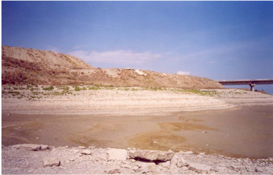
Εικόνα 16. Στον πόδα του πρανούς διακρίνεται η παλιά ακτογραμμή της λίμνης, που προέκυψε από τις διακυμάνσεις της στάθμης του νερού. Πρόκειται για το αριστερό πρανές ανάντη της γέφυρας της Αιανής.
