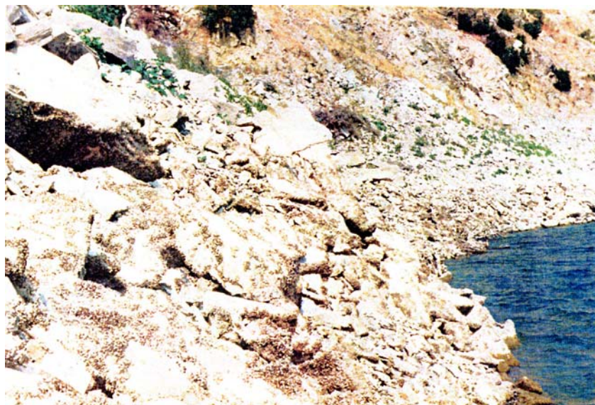
Εικόνα 15. Έντονα χαλαρωμένο πέτρωμα στα πρανή περιμετρικά της λίμνης εξαιτίας των μεταβολών της στάθμης.
