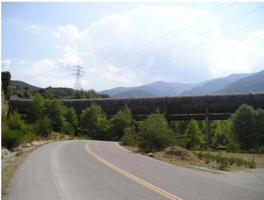
Εικόνα 5. Σήραγγα προσαγωγής. Και στις δύο φωτογραφίες φαίνεται το υπαίθριο τμήμα της.
