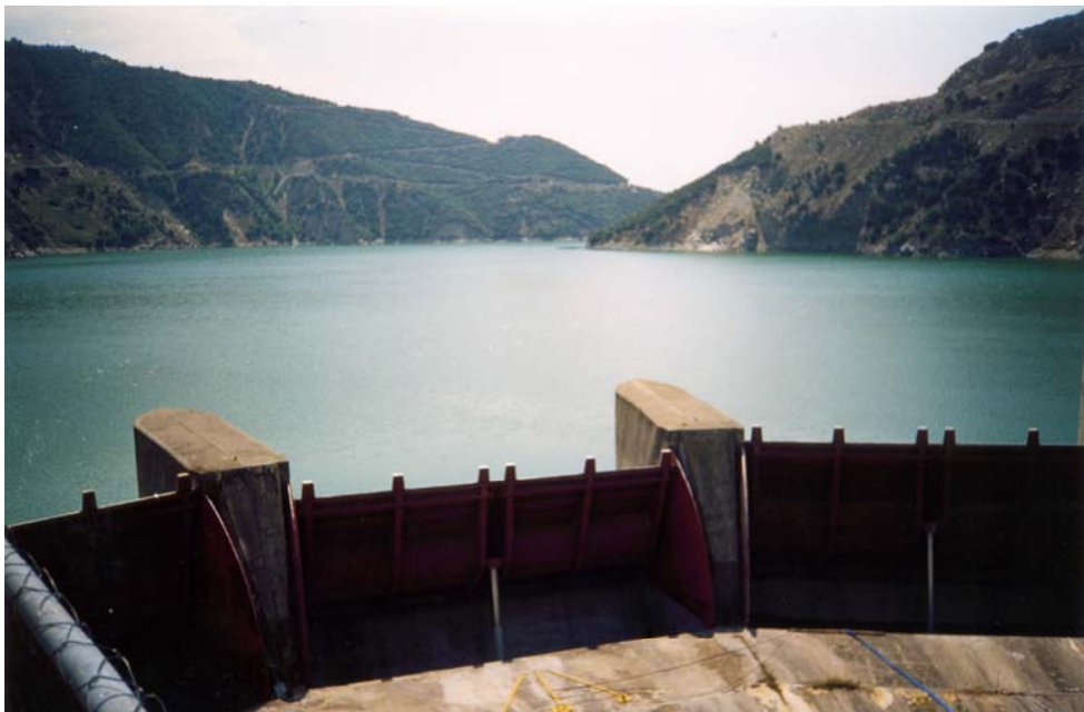
Εικόνα 4. Ο υπερχειλιστής του υδροηλεκτρικού έργου. Διακρίνονται τα τρία θυροφράγματα.
