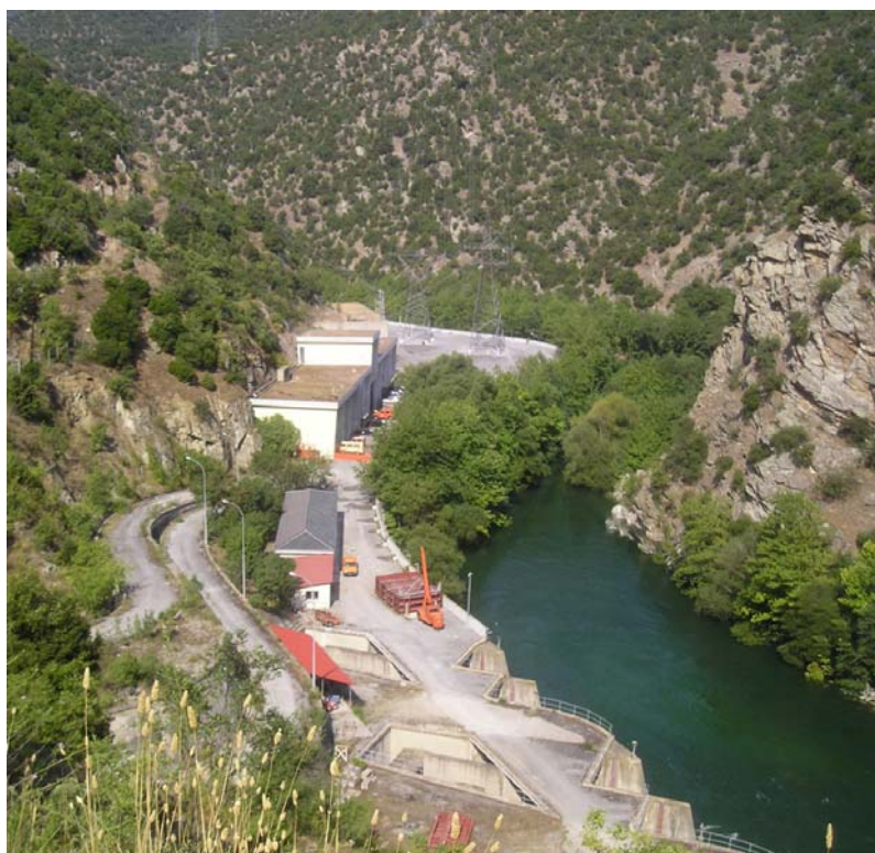
Εικόνα 2. Εγκαταστάσεις Υ.Η.Σ. Πολυφύτου. Η είσοδος του υπόγειου σταθμού βρίσκεται στο κτίριο το οποίο φαίνεται στο βάθος.
