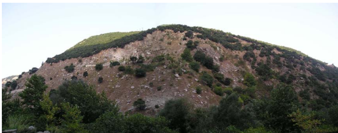
Εικόνα 7. Βορειοδυτικό κατάντη πρανές του φράγματος. Σε κάποια σημεία φαίνεται το γνευσιακής σύστασης (προαλπικό) υπόβαθρο.
