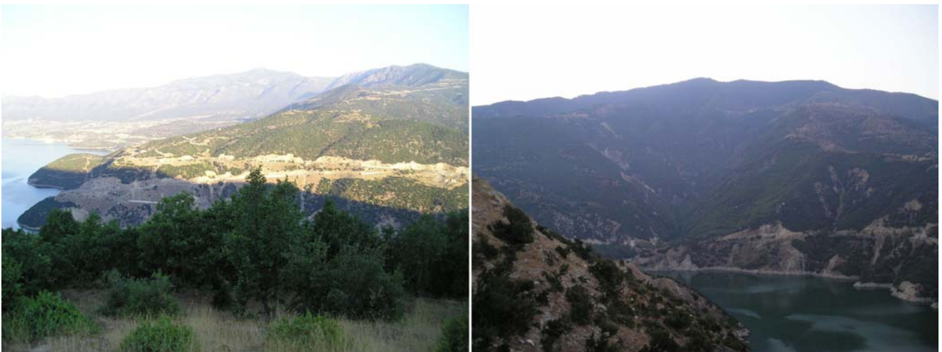
Εικόνα 11. Στις δύο παραπάνω φωτογραφίες φαίνεται το πυκνό υδρογραφικό δίκτυο που έχει αναπτυχθεί στην ευρύτερη περιοχή του φράγματος.
