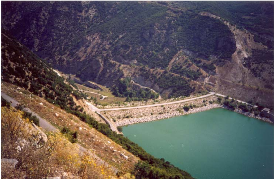
Εικόνα 3. Άποψη του λιθόρριπτου φράγματος Πολυφύτου.
