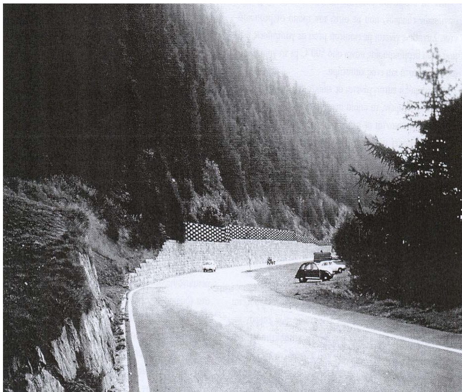
Εικόνα 11. Τοίχοι αντιστήριξης και ξύλινα πλέγματα κατά μήκος οδικού δικτύου.
