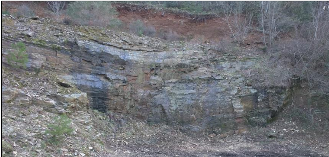
Εικόνα 51. Άποψη του πρανούς στη Θέση 11. Διακρίνονται μεγάλου μήκους ασυνέχειες με έντονη αποσάθρωση (όψη προς νότια)
