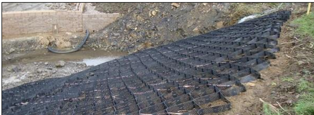
Εικόνα 132. Γεωπλέγμα για προστασία από τη διάβρωση (Πηγή: http://greenfix.co.uk )
