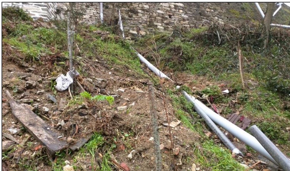
Εικόνα 53. Άποψη του μετώπου στη θέση παρατήρησης 16
