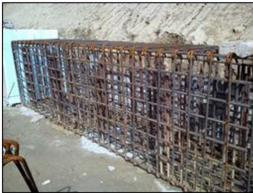
Εικόνα 128. Κατασκευή κεφαλόδεσμου (Πηγή: http://www.koumoulos.com )
