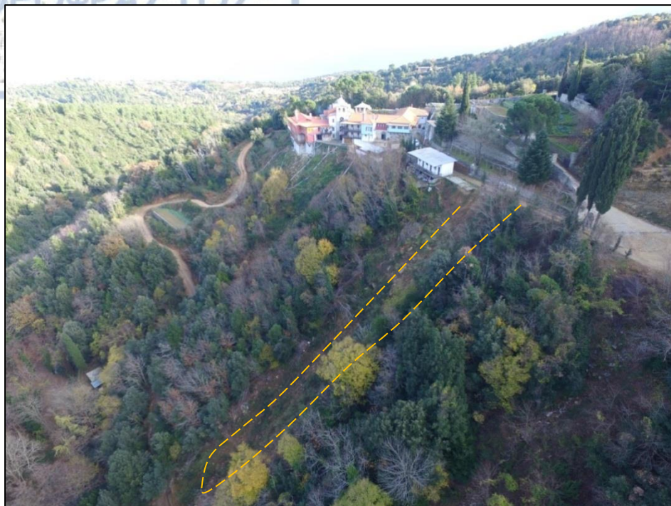
Εικόνα 6. Αποψη του μορφολογικού αναγλύφου της περιοχής μελέτης από Δυτικά. Σημειώνεται με κίτρινο χρώμα η οριοθέτηση τμήματος του δρόμου που έχει ολισθήσει και έχει συμπαρασύρει μαζί του και μικρό κτίριο που εδράζονταν στο σημείο.
