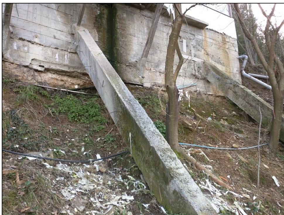
Εικόνα 50. Όψη αντηρίδων συγκράτησης του αγιογραφείου από τη θέση παρατήρησης 13
