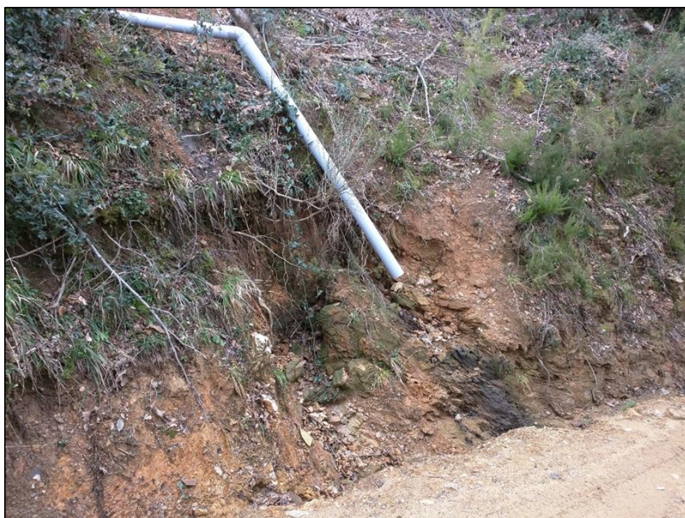
Εικόνα 41. Χαρακτηριστική εικόνα απογύμνωσης του υποβάθρου από την απορροή των υδάτων.
