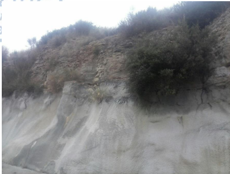
Εικόνα 57(a, b). Κάλυψη ενδιάμεσων στρωμάτων με εκτοξευμένο σκυρόδεμα.
