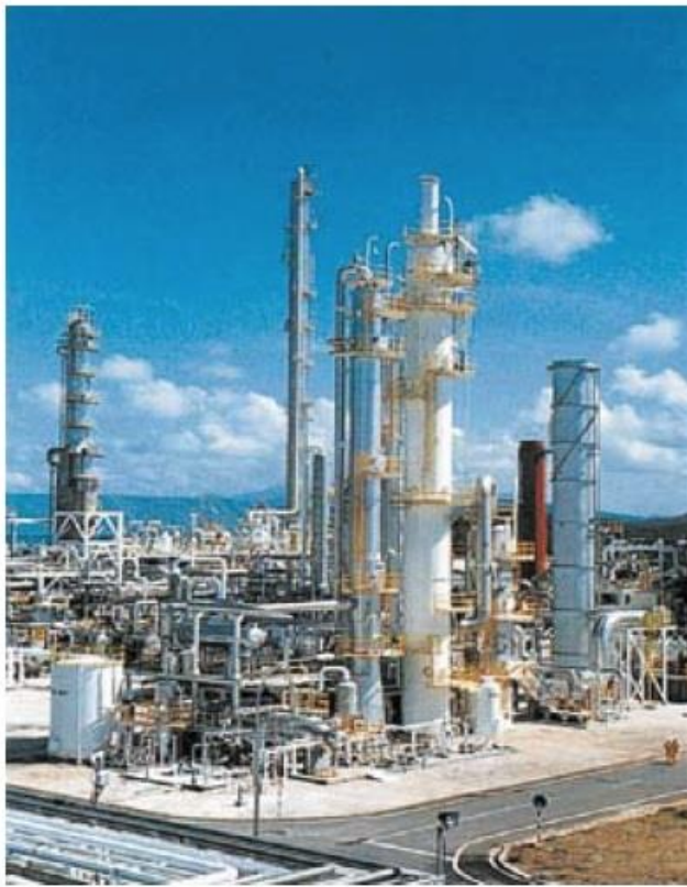
Εικόνα 3.4 : Εγκατάσταση δέσμευσης CO 2 στη Μαλαισία με χρήση της διεργασίας χημικών KEPCO / MHI. Η εγκατάσταση αυτή παράγει περίπου 200 t CO 2 / ημέρα.
