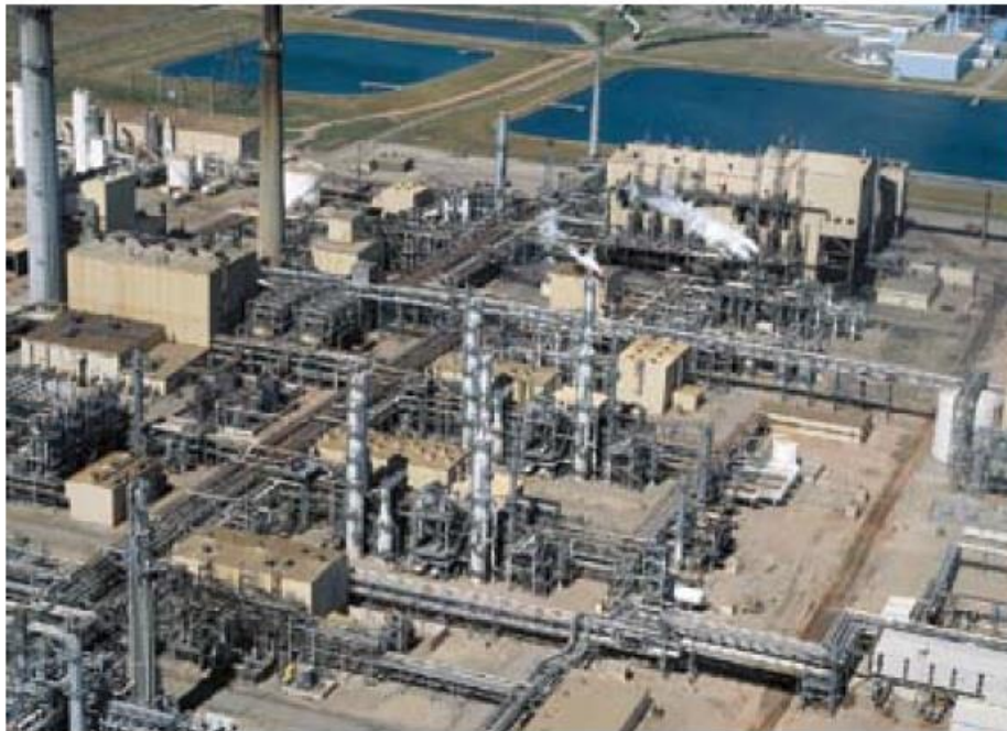
Εικόνα 3.10 : Εγκατάσταση εξαερίωσης γαιάνθρακα στη Βόρεια Ντακότα με ετήσια παραγωγή 3.3 Mt CO 2 . Για τη δέσμευση του CO 2 , χρησιμοποιείται μια διεργασία φυσικού διαλύτη με κρύα μεθανόλη. Μέρος του δεσμευμένου CO 2 μεταφέρεται στο Weyburn στο Saskatchewan του Καναδά για EOR.
