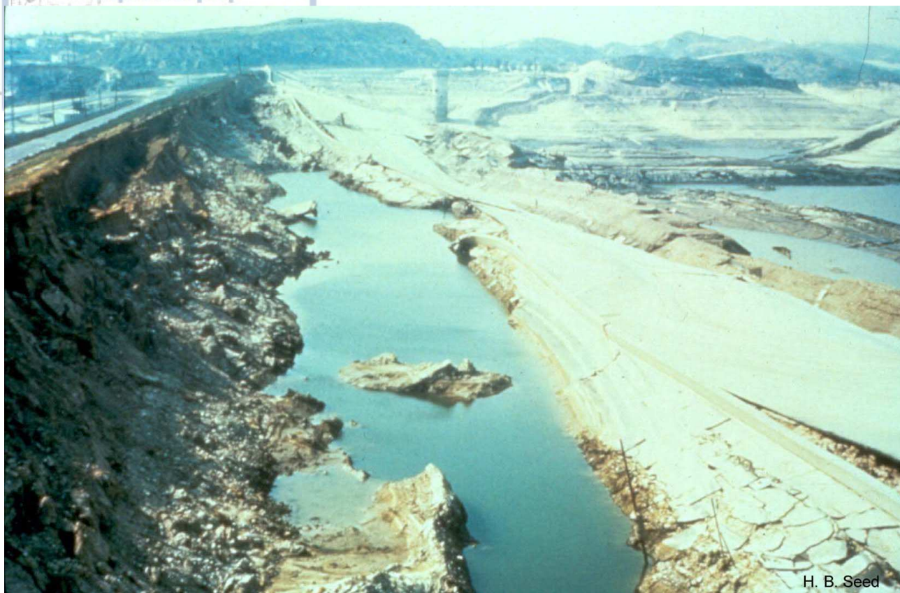
Εικόνα 2.1 β : Τα ανάντη του φράγματος Lower San Fernando μετά την εδαφική ροή (Dahms., 2004).
