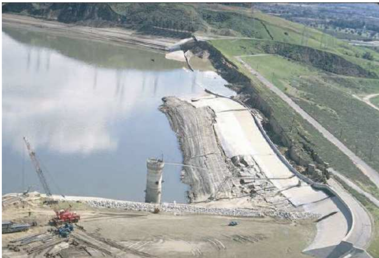
Εικόνα 2.1 α : Το φράγμα Lower San Fernando μετά την εδαφική ροή (Dahms., 2004).
