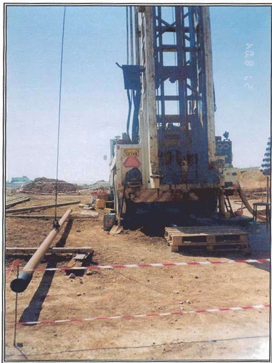
Εικόνα 14. Ανύψωση στελέχους με κινούμενο συρματόσχοινο
