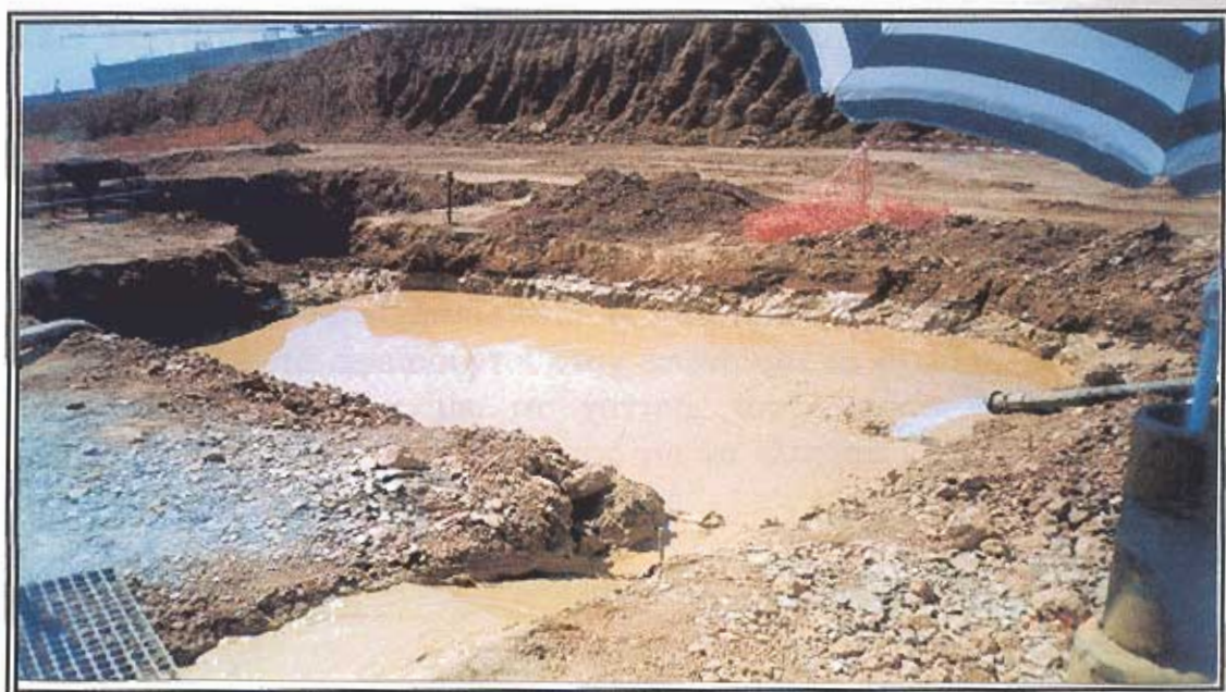
Εικόνα 12. Πλήρωση δεξαμενής με νερό
