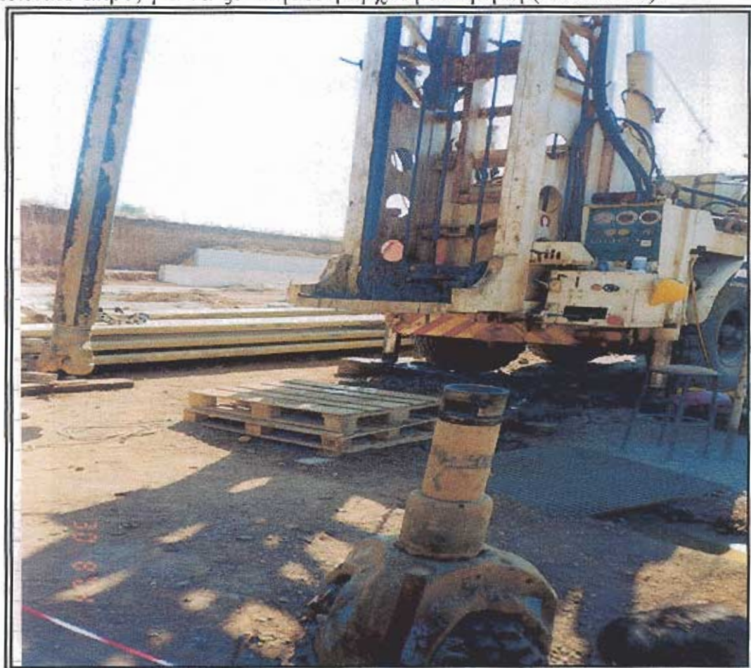
Εικόνα 13. Οδηγός και κεφαλή αρχικής διάτρησης
